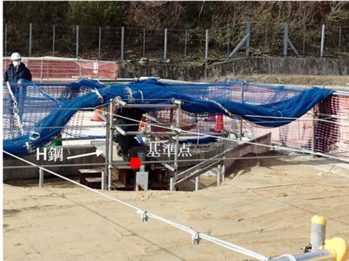
図 A1-5 換気立坑の変化量確認基準点
