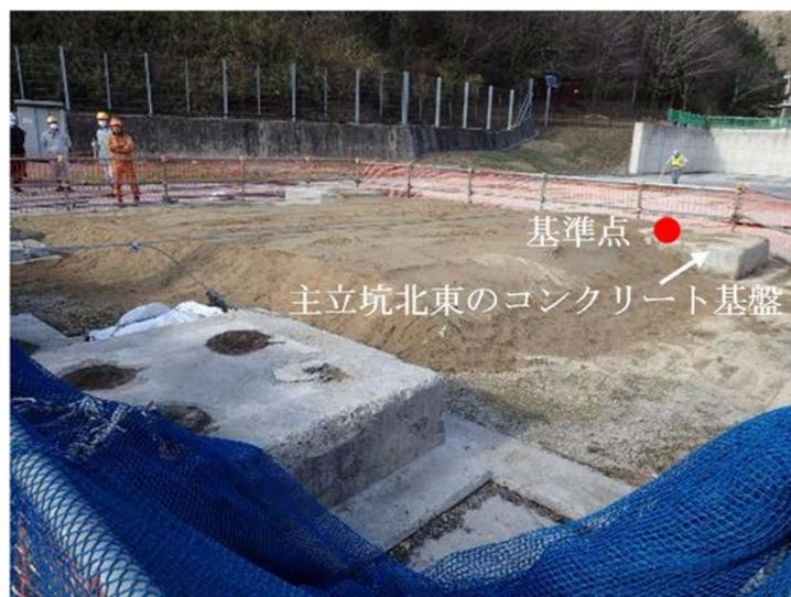
図 A1-4 主立坑の変化量確認基準点
