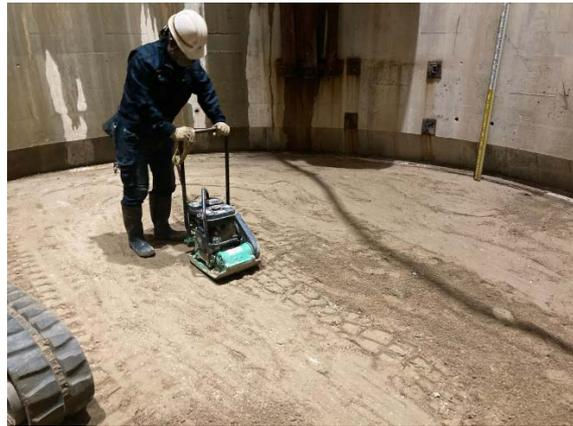
主立坑深度 500～400 m 締固め
