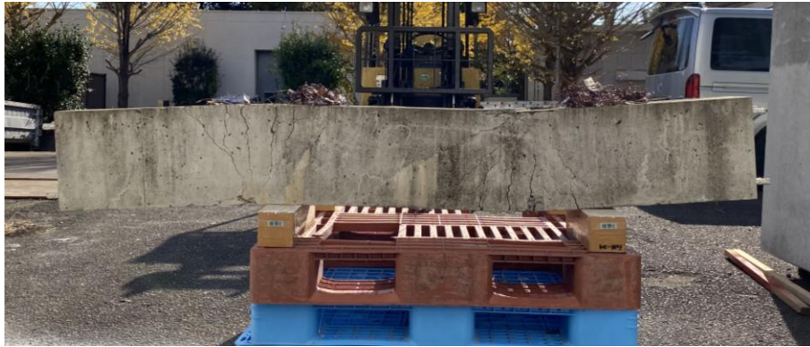
図 3.3.2-2 損傷したコンクリート梁模擬試験体
