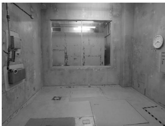
グローブボックス N (解体後)
