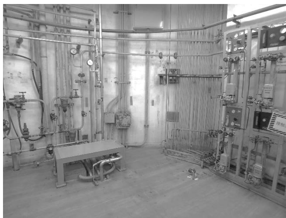
グローブボックス P (解体後)
