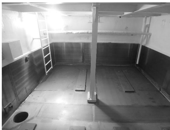
地下ピット廃液受槽 (MV-1、2、3) (解体後)
