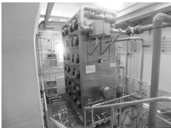
グローブボックス L (解体前)
