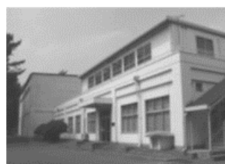
環境シミュレーション試験棟
