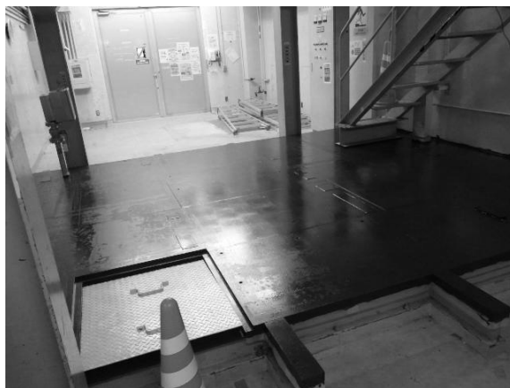
グローブボックス K (解体後)
