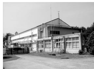
放射性廃棄物処理場 （液体処理場）
