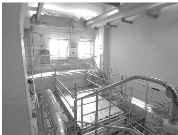
グローブボックス L (解体後)
