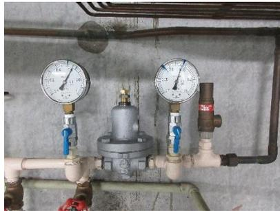
写真 2.2.16-1 減圧弁交換後の圧力値
