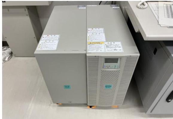
写真 2.2.10-2 無停電電源装置(更新後)
