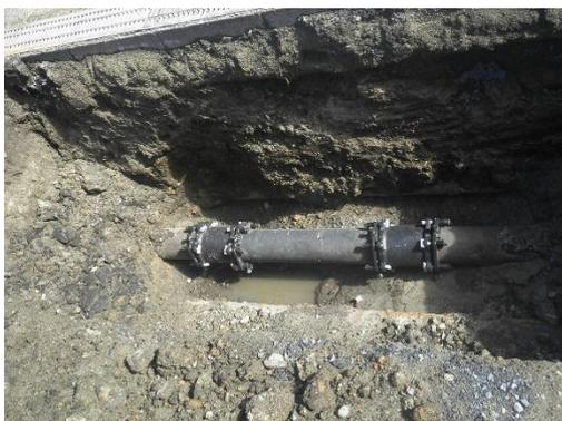
写真 2.2.18-6 工業用水配管(補修工事後)
