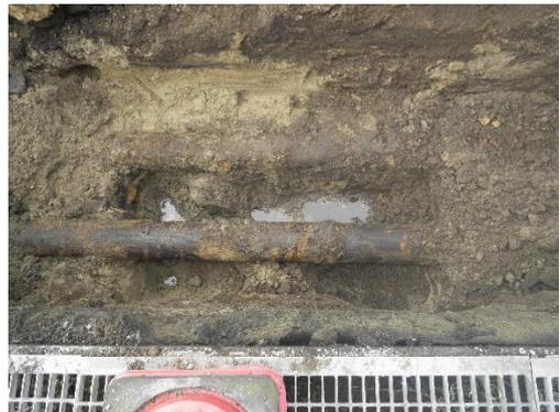
写真 2.2.18-5 工業用水配管(漏水部)
