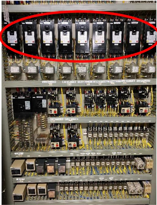
写真 2.2.13-1 漏電遮断器(更新前)
