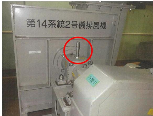
写真 2.2.2-2 エア抜きの取り付け
