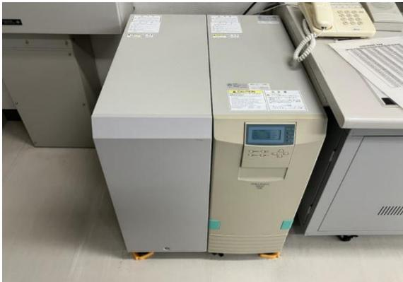
写真 2.2.10-1 無停電電源装置(更新前)
