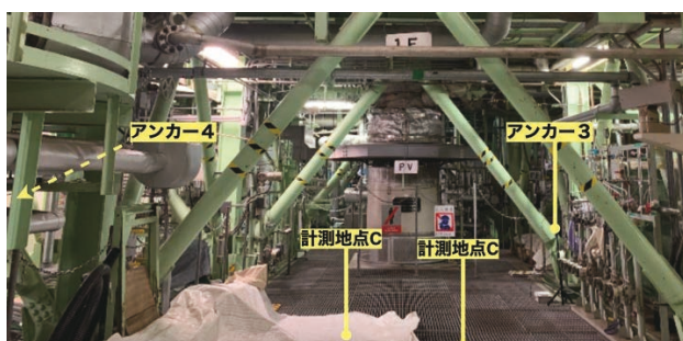
(b) 計測地点Cとアンカー位置の状況
