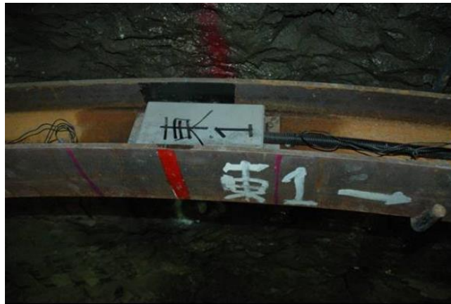
図 81 鋼製支保工応力計設置例
