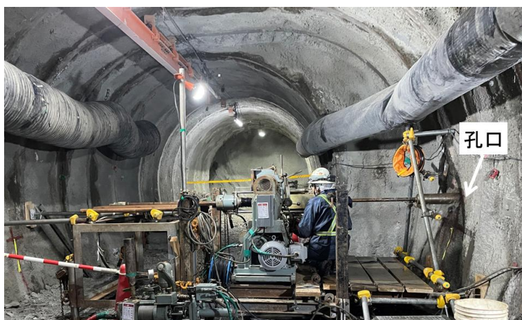
(a) ボーリング孔の掘削
