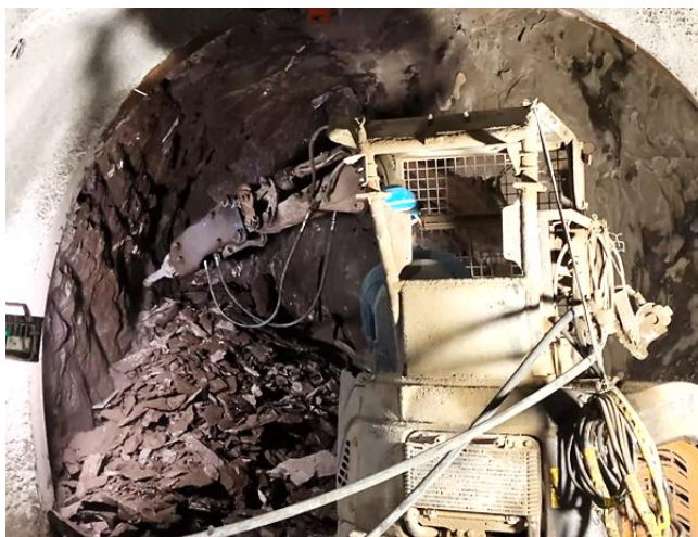
図 89 500m 調査坑道の掘削状況
