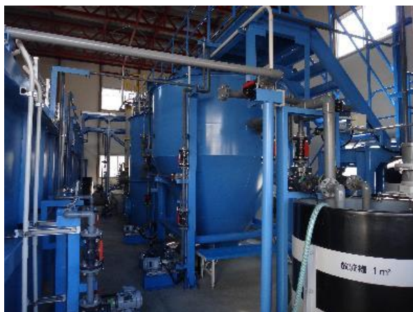
(a) 硝酸性窒素処理設備
