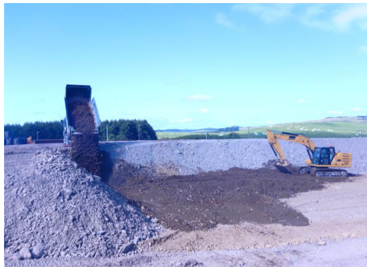
図 92 掘削土（ズリ）置場への掘削土（ズリ）搬入の様子
