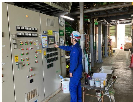
(b) 排水処理設備の運転・監視
