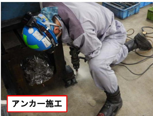
写真3 加工機の設置作業状況
