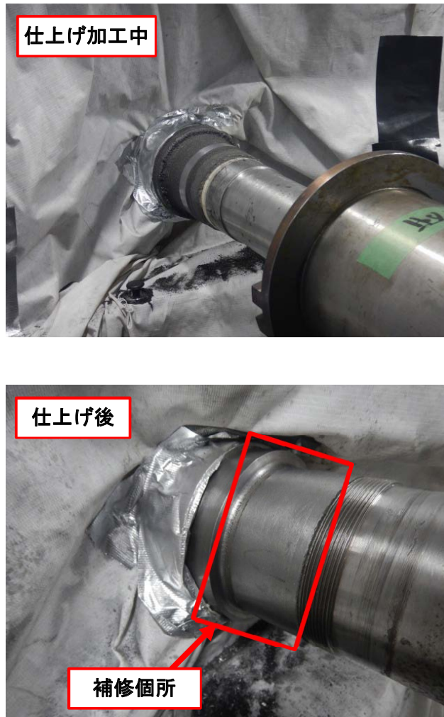
写真7 仕上げ加工状況 (2/2)
