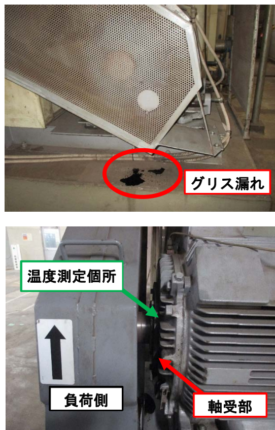
写真 1-1 軸受部近傍の外観及び状況写真 (1/2)
