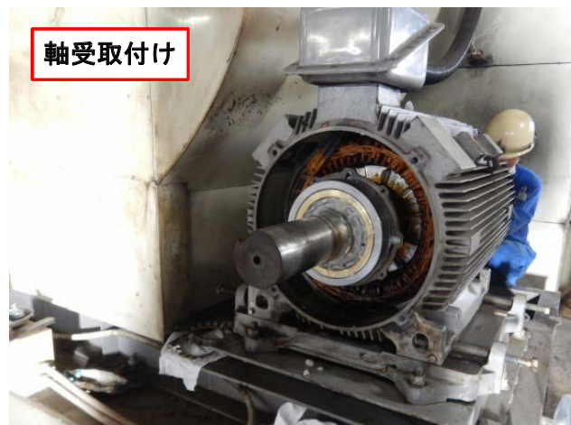
写真2 軸受の交換作業状況 (2/2)
