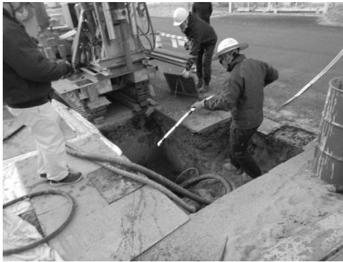
接地極設置作業
