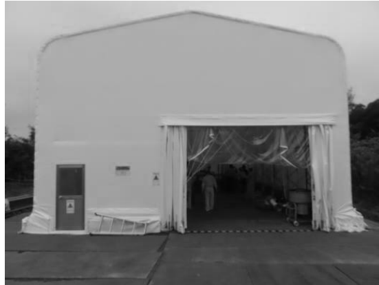
図 8.2-1 事故由来廃棄物等取扱施設
