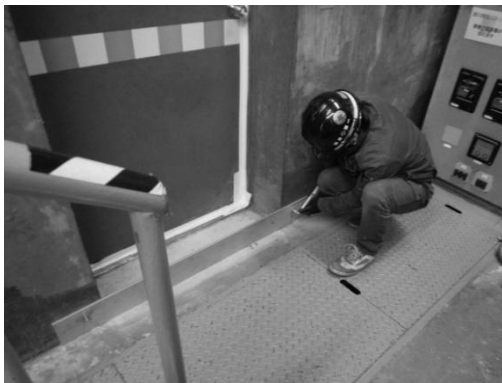
鋼板取付作業
