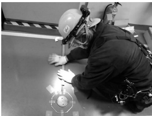
検知器設置作業
