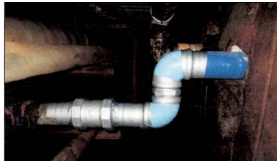
写真 2.2.18-7 工業用水配管修理
