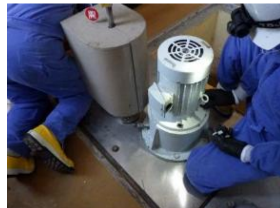
写真 2.2.5-4 ポンプ整備後
