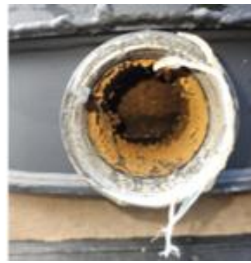
写真 2.2.18-2 ドレン管内部
