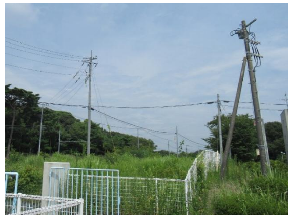
写真 2.2.17-2 引込みケーブル(撤去後)
