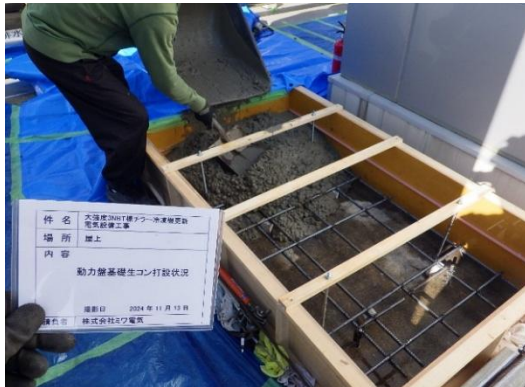
写真 2.11.7-7 屋上動力盤用基礎コンクリート 打設状況
