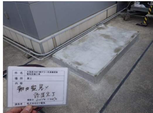
写真 2.11.7-8 屋上動力盤用基礎コンクリート (新設後)
