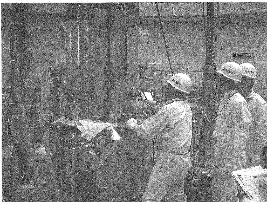
写真 5.3-5 遮へい体を Si 照射装置にセット
