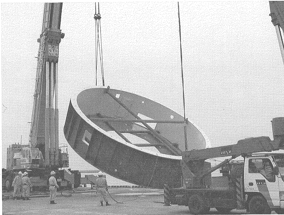
Photo 32 運搬車両に積載のためのアウターライナー上部立て起こし
