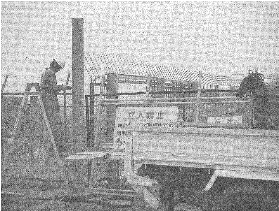
Photo 26 ゲートの一時撤去作業
