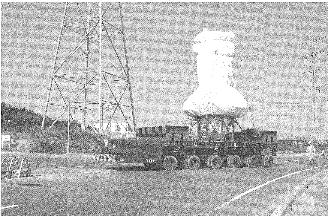
Photo 50 ヘリウムベッセル輸送 工事用道路進入部
