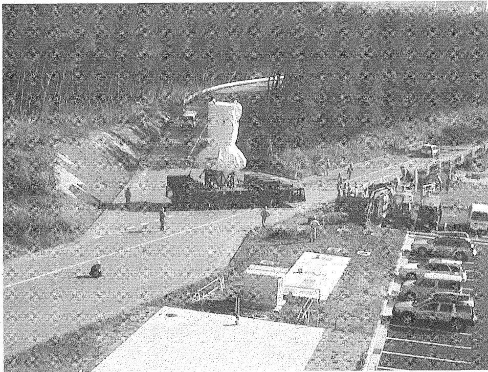
Photo 52 ヘリウムベッセル輸送 構内輸送道路合流部
