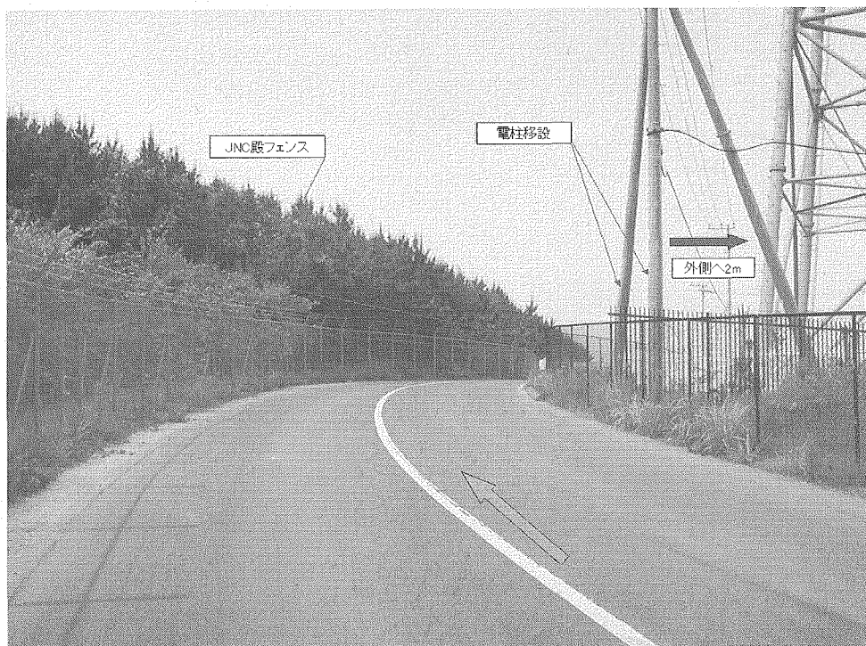
Photo 4 工事用道路 送電線鉄塔付近 JNC フェンス上部の一時撤去のみで輸送実施
