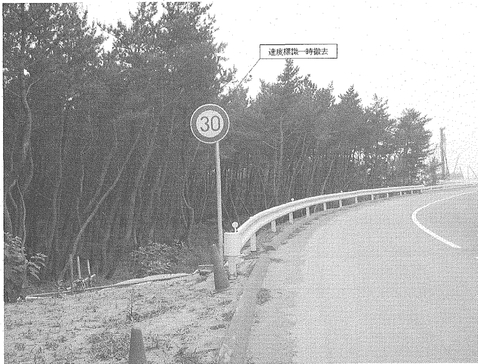
Photo 16 構内道路速度標識
