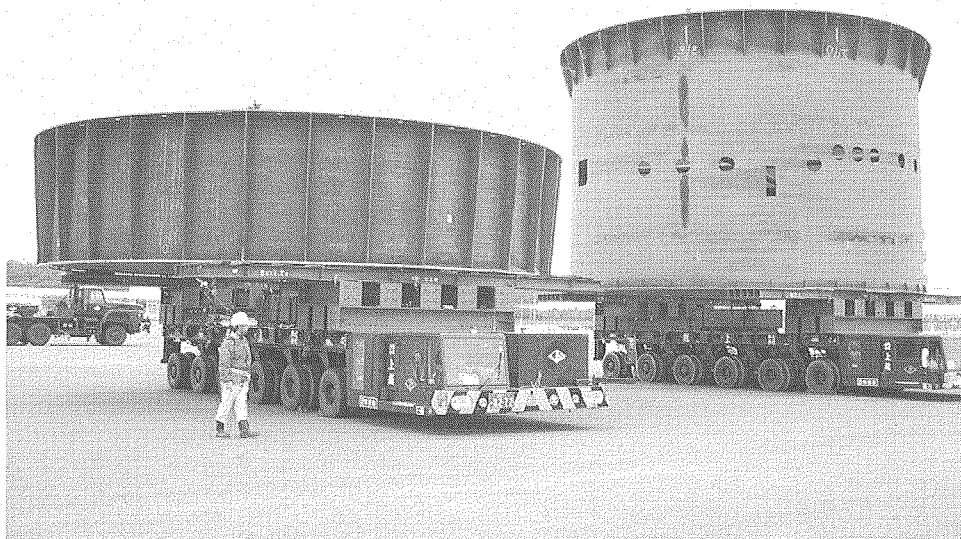
Photo 33 165t ユニットキャリアに積載したアウターライナー (写真右側：下部、写真左側：上部)
