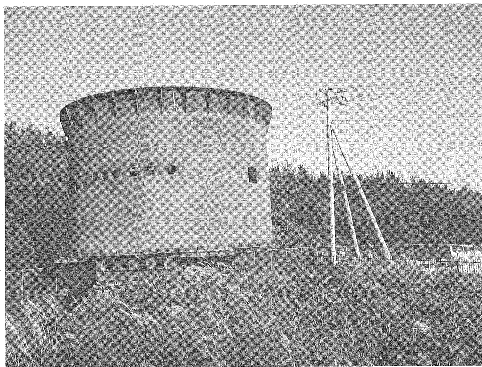
Photo 36 アウターライナー下部輸送 工事用道路 フェンス忍び返し撤去部
