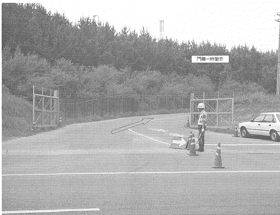
Photo 3. 工事用道路入口ゲート
