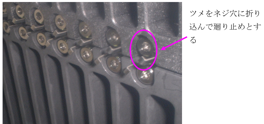
図 25 廻り止め取付け
