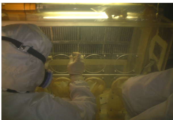
図5 グローブボックスの設置
