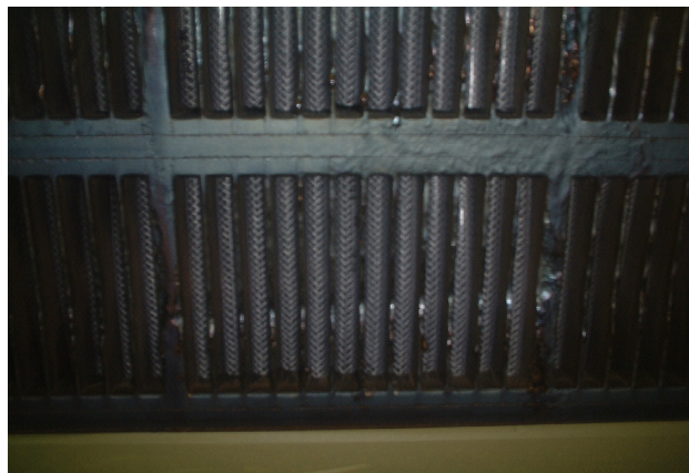
図 4 ブレードホースの挿入
