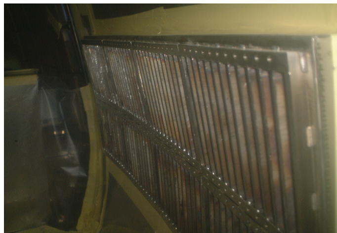
図 24 ベース部仕上げの完了
