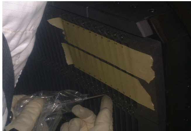
図 26 ボルトの本締め
