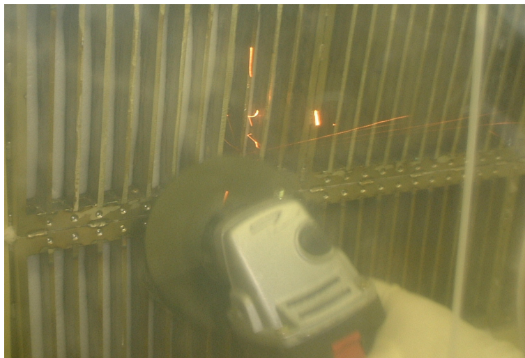
図 22 仕切り板切断
