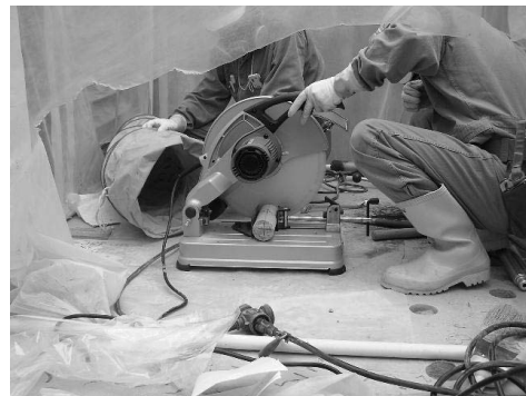
(4) 高速カッターによるコア試料の細断
