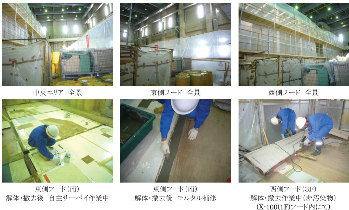
Photo. 4.2-9 廃止措置経過(転換試験室)
