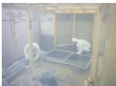
粉体試験用フード 解体・撤去作業中
