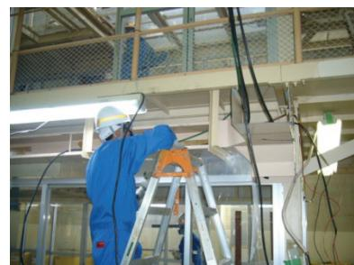
電線ダクト撤去作業中
