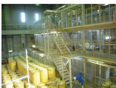
東側フード、中央階段 解体・撤去作業中
