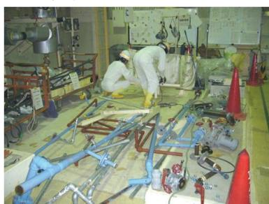
撤去配管の細断
