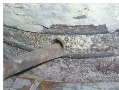
R-R303電気炉計装配管の破損
