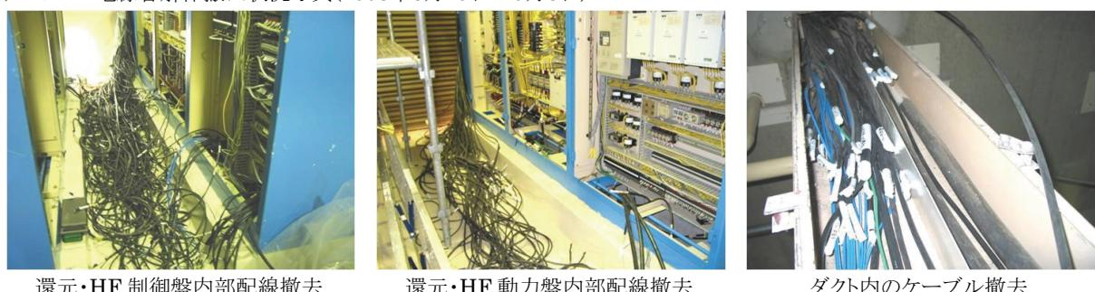
還元・HF 制御盤内部配線撤去
