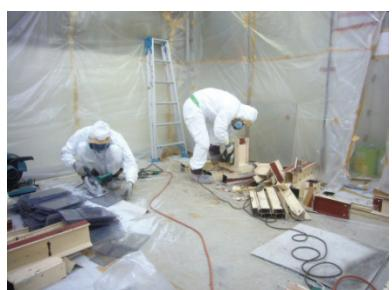
分析基礎試験用フード 解体・撤去作業中
