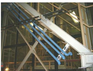
冷却水配管切断・撤去
