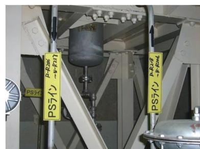
各種配管識別表示取付け
