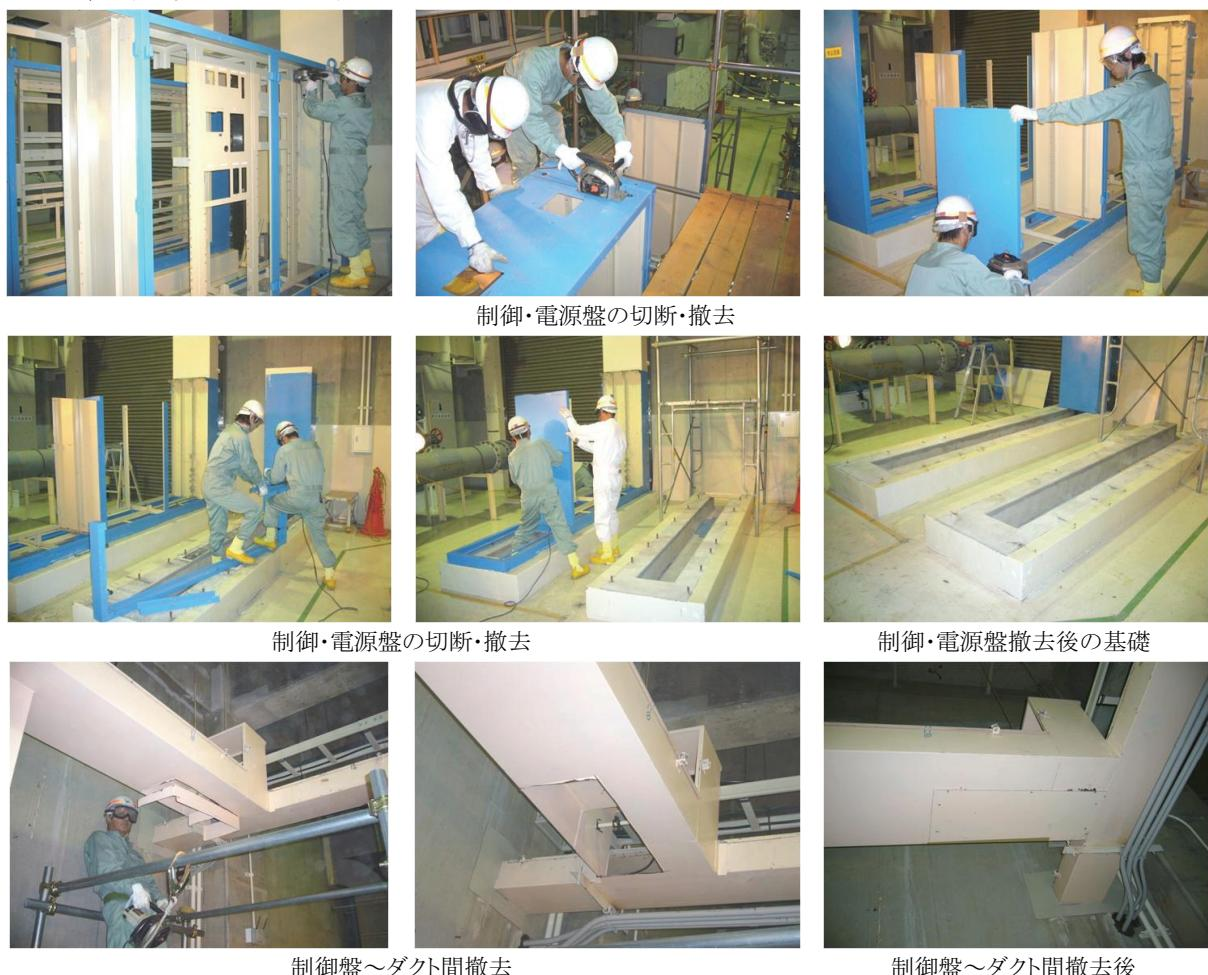
制御・電源盤の切断・撤去
