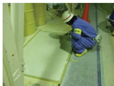
1月20日 原料供給機設備制御盤基礎解体後埋め戻し跡耐酸塗装
