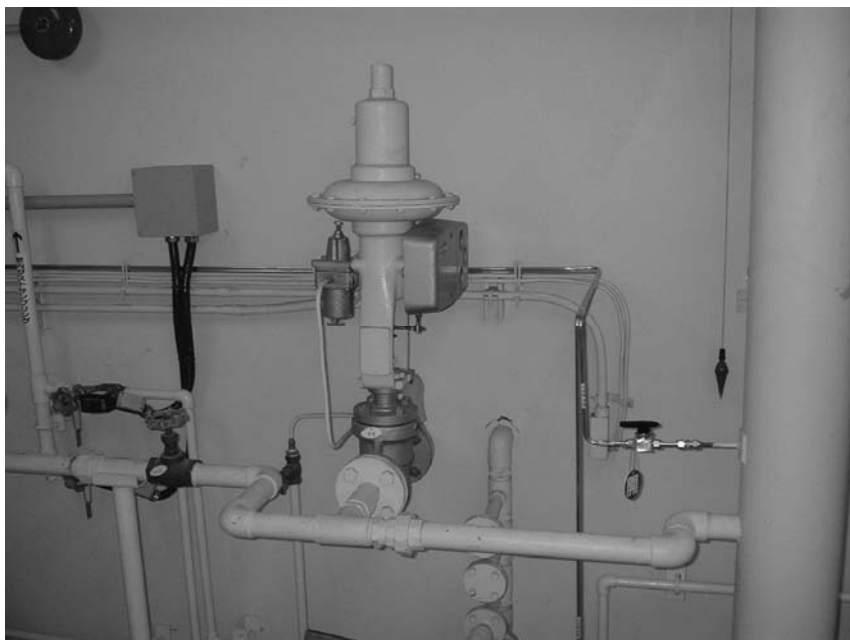
写真2 排気自動制御弁 (V-5 窒素系)
