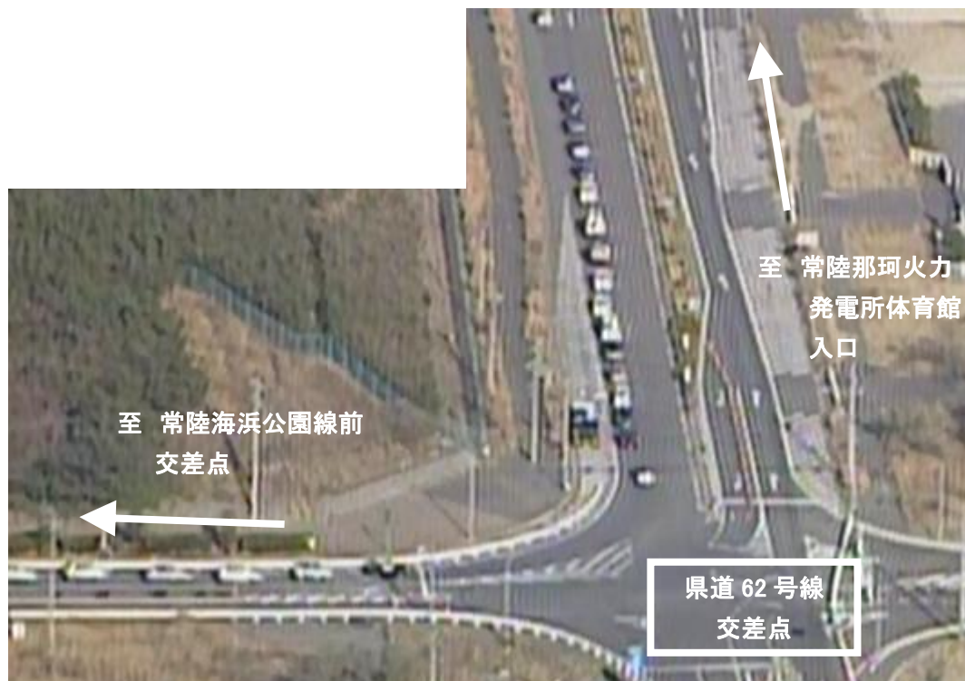
写真 2.9 県道 62 号線交差点から続く車列（左下）と 常陸那珂火力発電所体育館より続く車列（右上）
