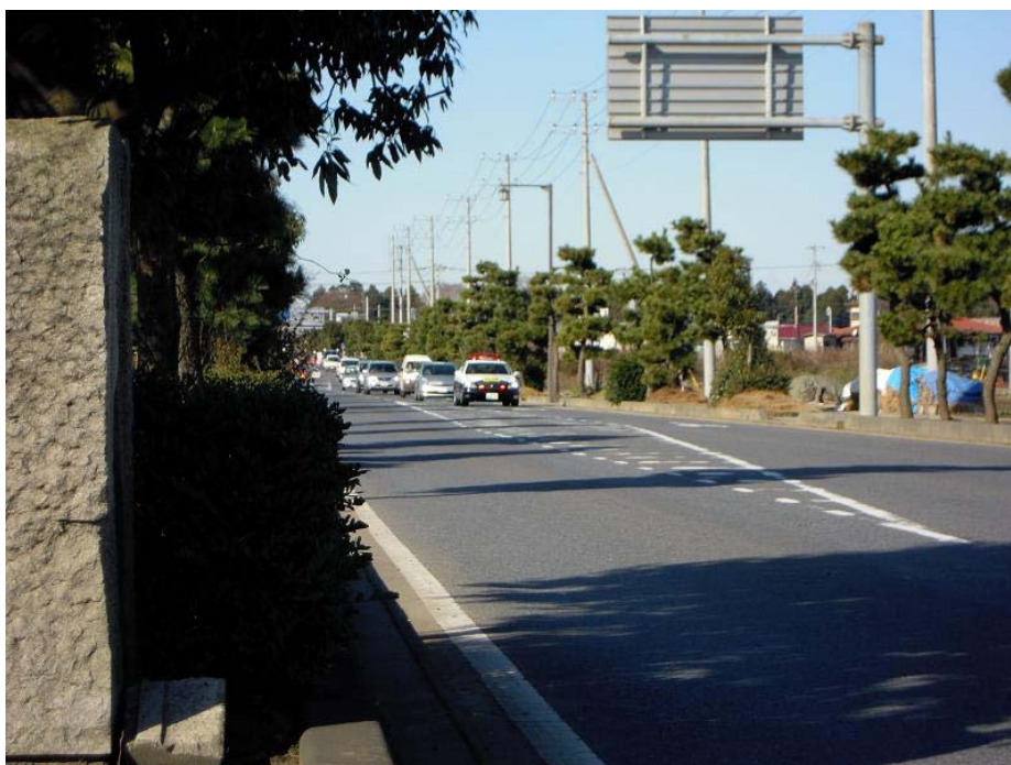
写真 2.5 常陸海浜公園線前交差点に接近する避難車両の先導車 (10 時 14 分頃、長砂交差点の方向を撮影)
