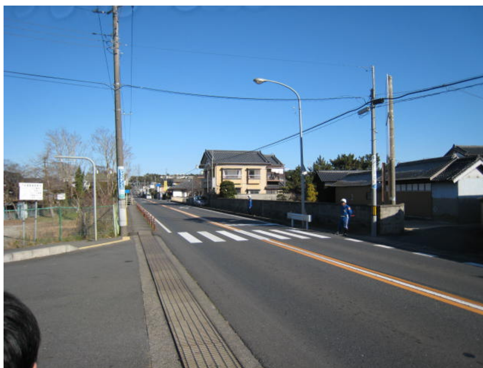
写真 2.2 村松コミュニティーセンター前交差点付近の道路状況 (10 時 10 分頃、原子力科学研究所の方向を撮影)
