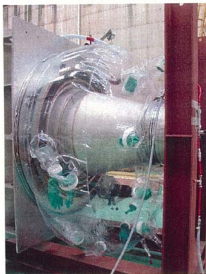
【MK-III冷却系改造工事におけるビンルバック使用例】 (1次冷却系配管切断に係るモックアップ試験時)
