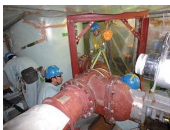
復水器冷却水(海水)配管の解体作業の様子
