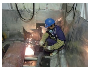
復水器冷却水(海水)配管の解体作業の様子
