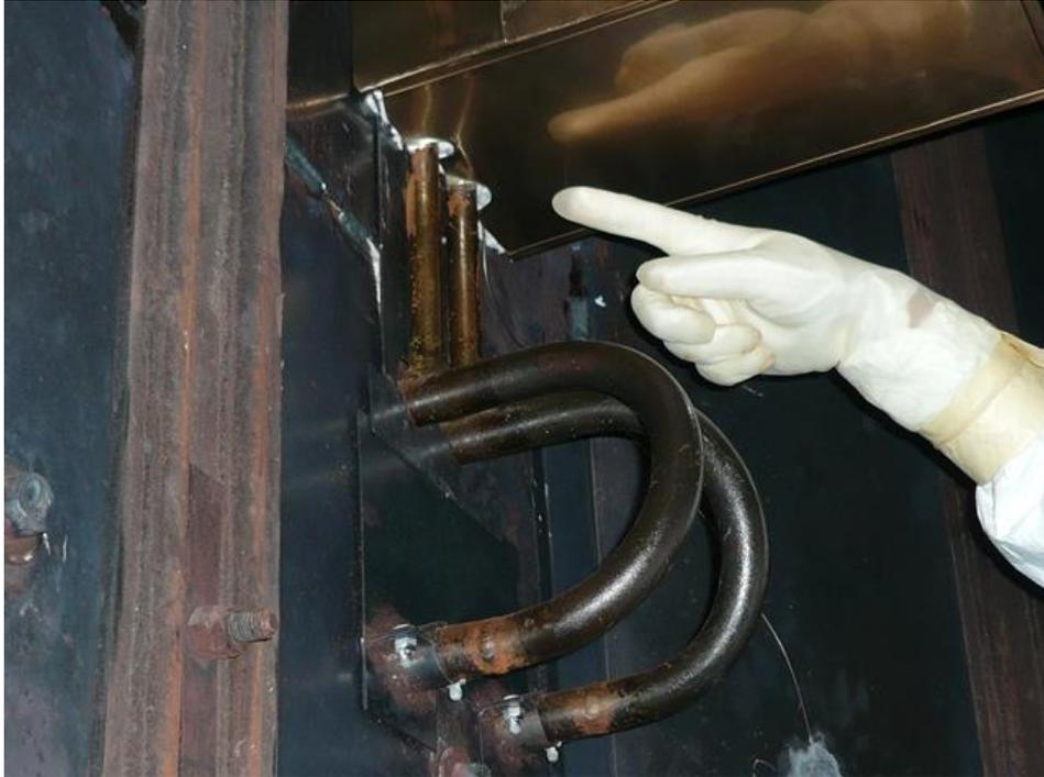
Fig.2.8 スタビライザ近傍の水冷管パネル
