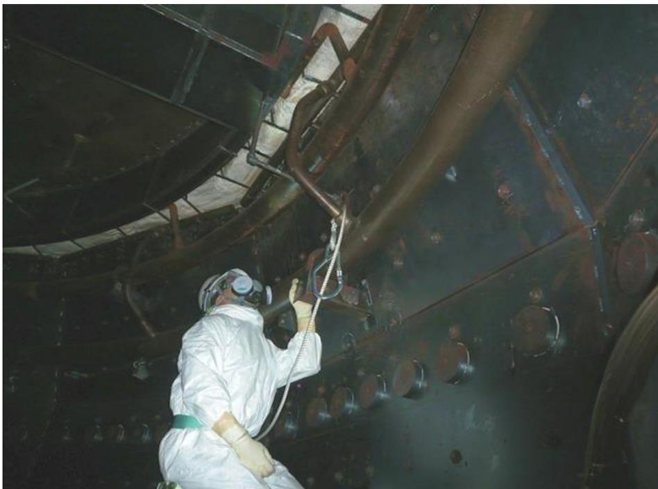
Fig.2.9 炉容器冷却設備側部パネル出口リングヘッド
