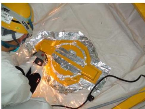
図 3.4.4-1 ストッパー溶接部の切削
