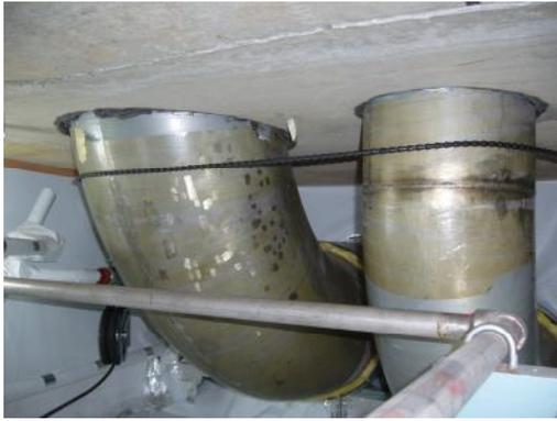
図 4.2.2-9 冷却配管とワイヤーソー
