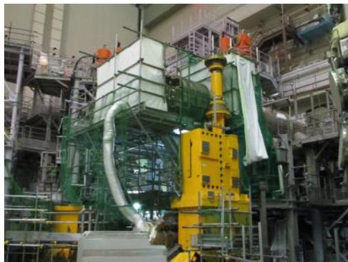
図 4.7.4-10 C系統マニホールドの吊出し
