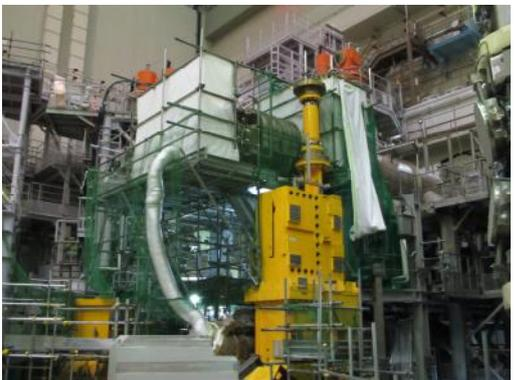
図 4.7.4-8 マニホールドの切断用養生
