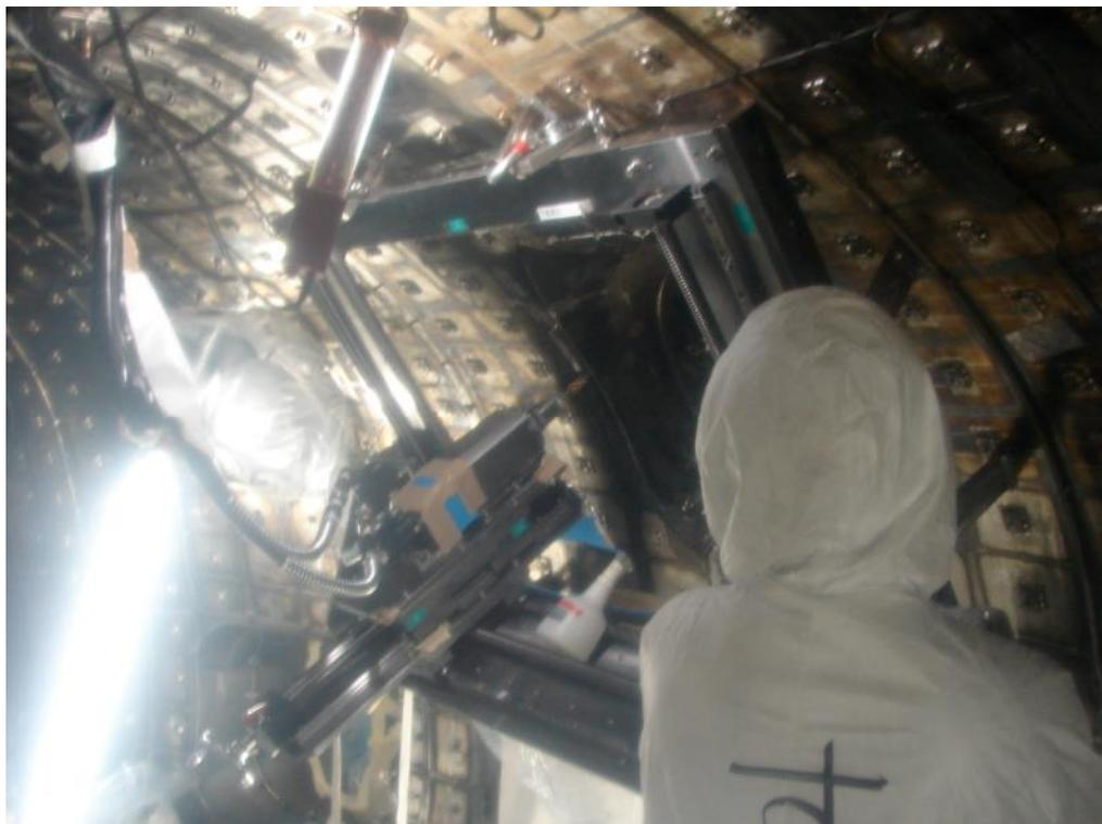
図 3.3.4.1-4 ポートボックス切断機を用いた斜めポートの切削状況
