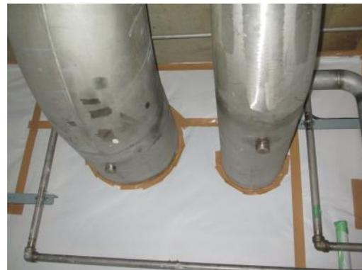
図 4.2.2-6 TF コイル冷却配管解体前
