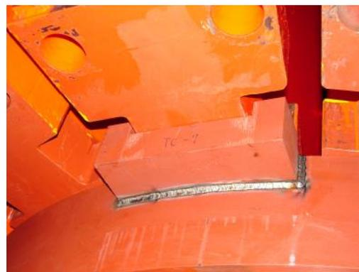
図 3.5.3-16 TFC 下部先端支持脚ストップ
