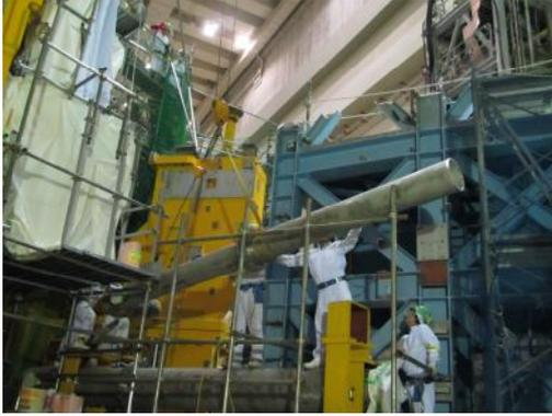
図 4.2.2-3 TF コイルの冷却配管
