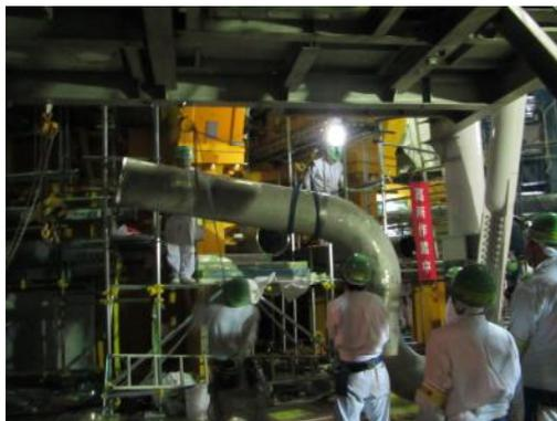
図 4.2.2-2 TF コイル冷却配管(吊り出し)
