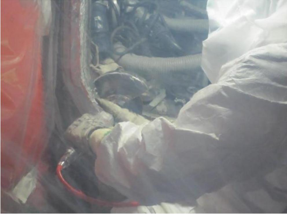
図 3.3.4.1-1 ディスクグラインダ-を用いたベローズ切断
