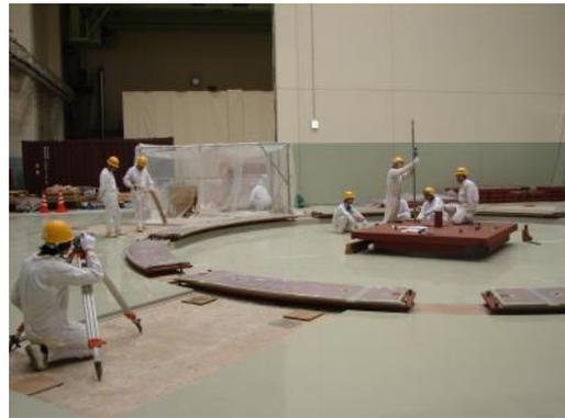
図 3.5.3-8 中心部受け板のレベル測定
