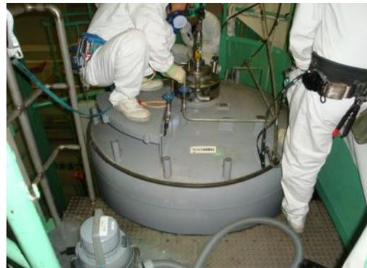
図 4.1.3-10 デュワタンク切断部品
