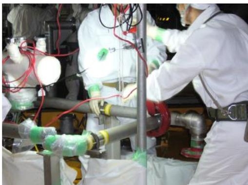
図 4.9.4-1 真空配管解体(上架台)
