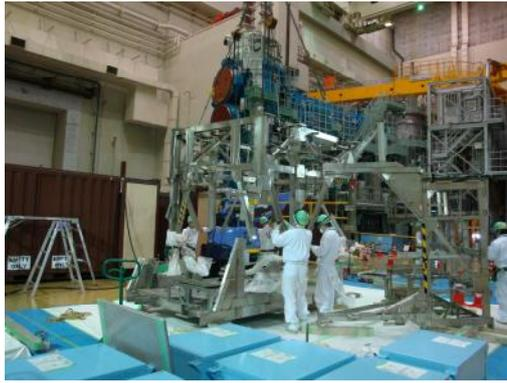
図 4.1.3-5 機器架台の切断
