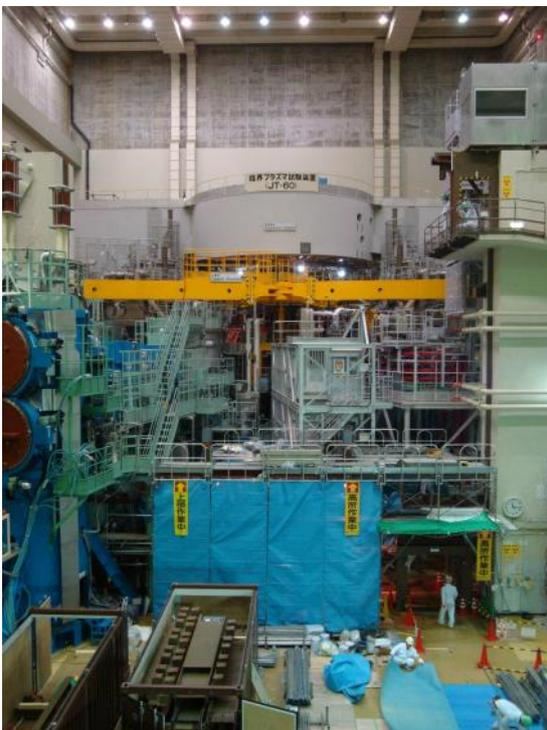
図 4.12.3-4 Y3 遮蔽壁約半分解体後
