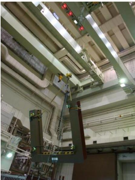
図 4.12.3-10 1階遮蔽扉（枠吊出し）
