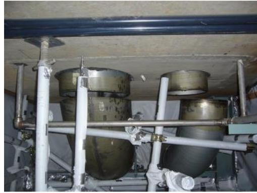
図 4.2.2-10 冷却配管切断後
