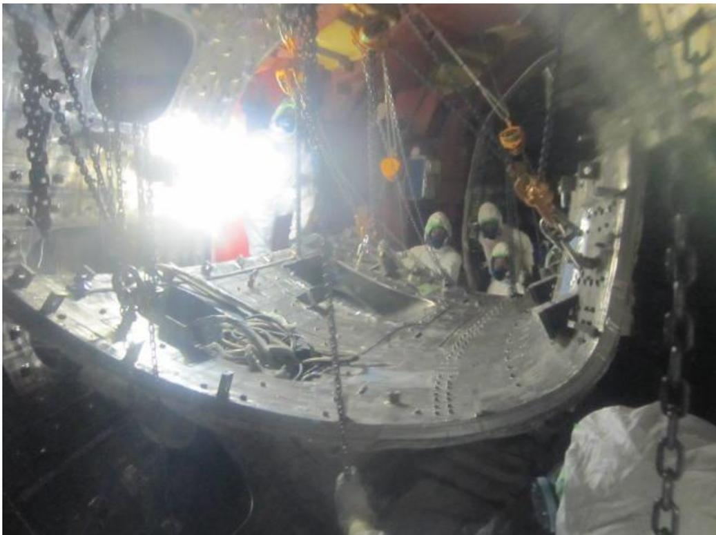
图 3.3.4.1-8 下部切断片引き込み作業
