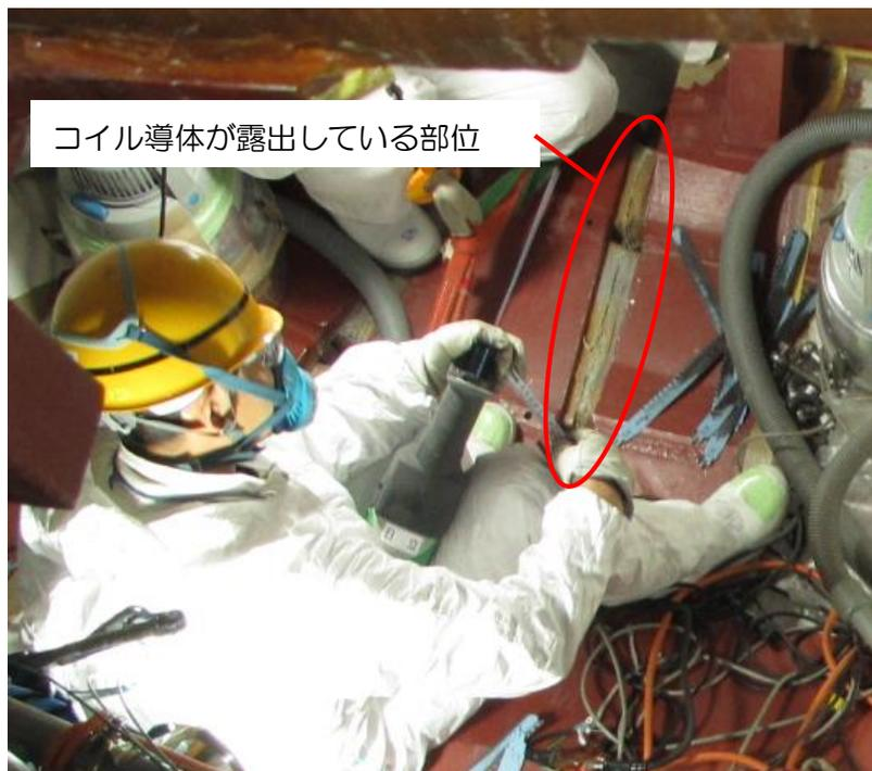
図 3.2.4.1-1 D コイル切断箇所
