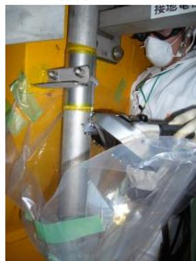
図 4.9.4-2 パンドリでの真空配管解体
