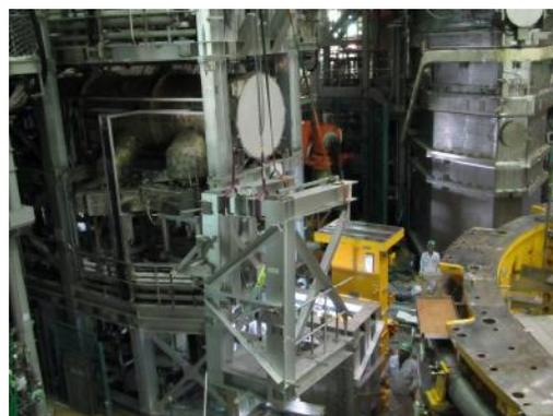
図 4.7.4-12 真空排気設備架台吊出し
