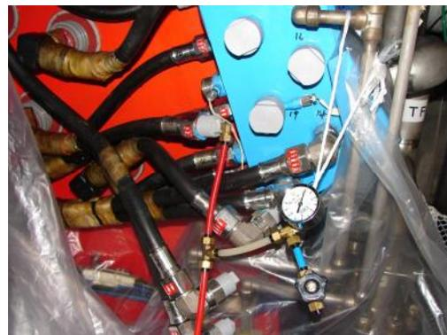
図 4.2.3-2 TF コイル水抜き(圧空供給治具)
