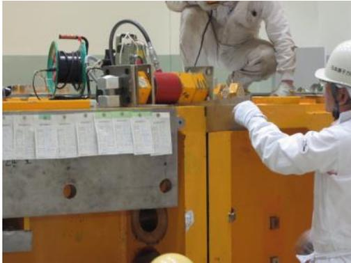
図 3.5.4-5 上架台の据付 3(絶縁板の挿入)
