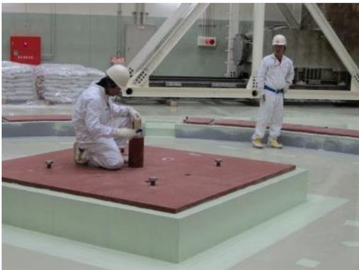
図 3.5.3-7 中心部受け板のレベル測定
