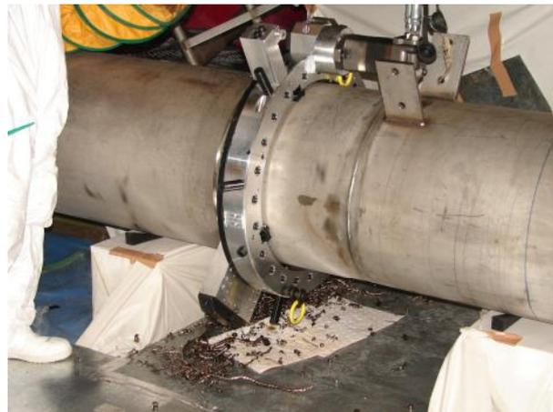
(3) パイプ自動切断開先加工機による配管支持柱切断
