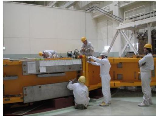
図 3.5.4-4 上架台の据付 2(絶縁板の挿入)
