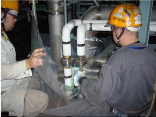
図 4.7.4-3 冷却水配管フランジの切離し作業
