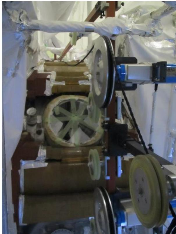
図 3.3.4.1-10 ダイヤモンドワイヤーソー設置状況
