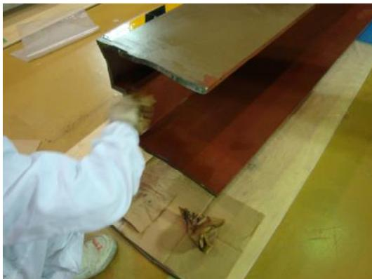
図 4.12.3-9 1階遮蔽扉（枠の切断後）
