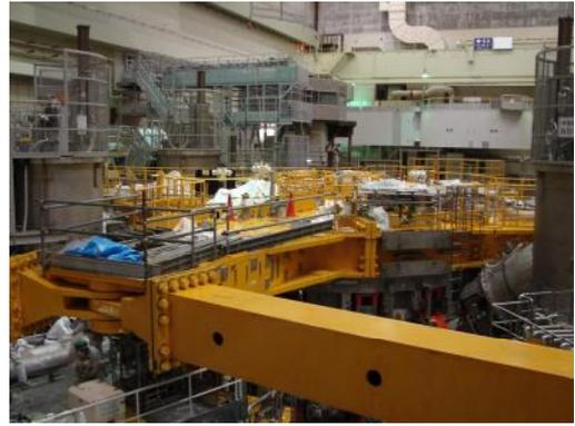
図 4.1.3-6 機器架台の撤去後(上架台)
