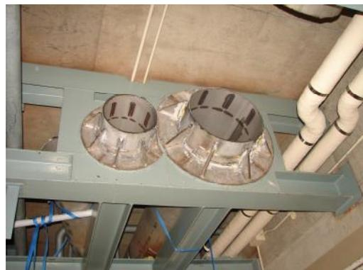
図 4.2.2-12 TFC 冷却配管切断後
