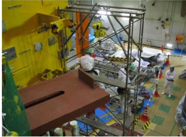
(1)PIG 電源室解体配管の吊り上げ用仮設ヤグラ
