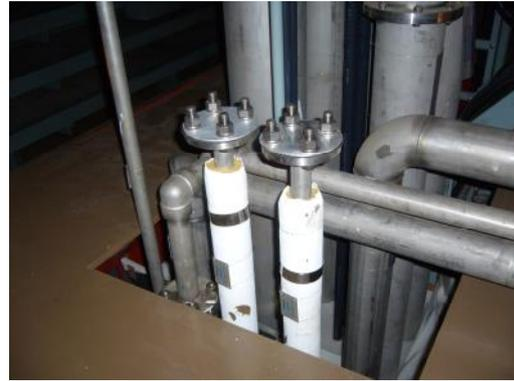
図 4.7.4-4 冷却水配管に閉止板取付け後
