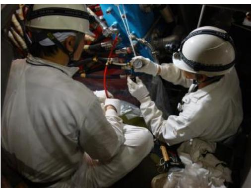
図 4.2.3-1 TF コイル水抜き(圧空使用)
