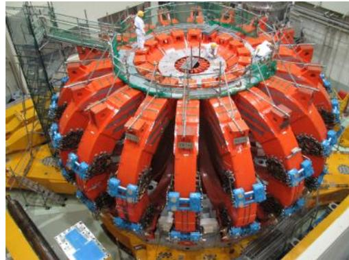
図 3.5.4-18 TF コイル 18 個の設置完了
