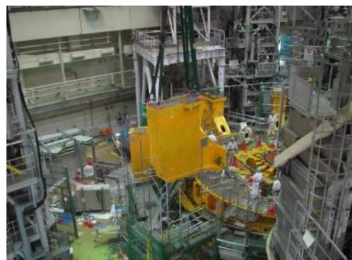
図 3.4.4-12 支持柱の吊出し作業
