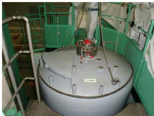
図 4.1.3-11 デュワタンク切断作業後
