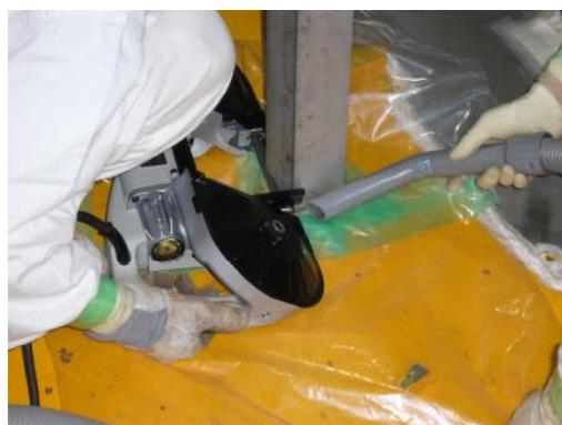
図 4.9.4-4 真空配管サポート解体
