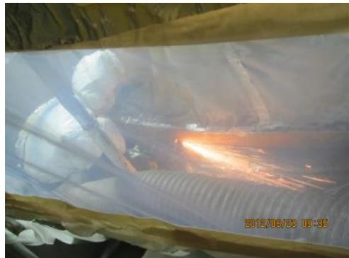
図 3.4.4-10 基礎架台外側補強溶接部
