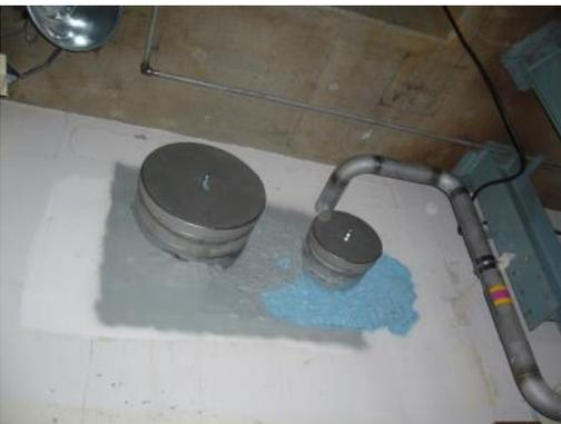
図 4.2.2-7 TF コイル冷却配管解体後
