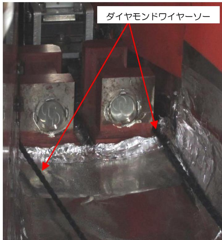
図 3.2.4.2-2 ダイヤモンドワイヤーソーによるストッパー切断
