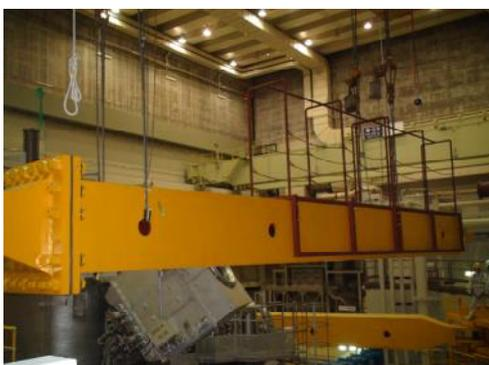
図 3.4.4-3 星形トラス - $\Delta$ (ST-2)の吊出し作業
