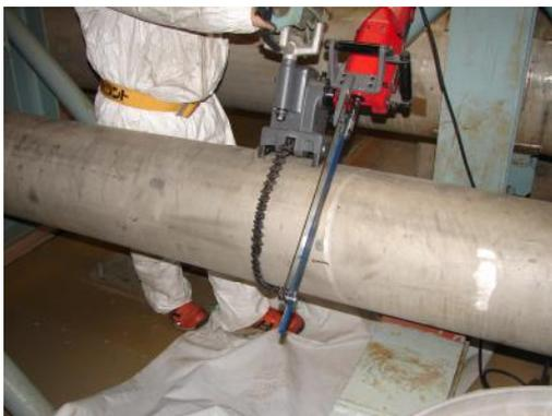
図 4.2.2-11 パイプソーによる配管切断
