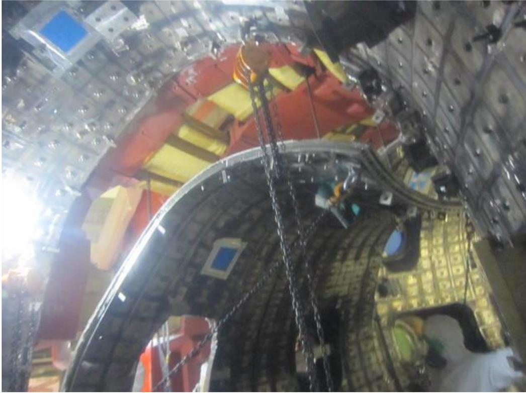
图 3.3.4.1-7 上部切断片引き込み作業
