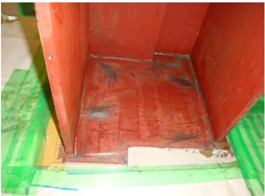
図 4.12.3-8 1階遮蔽扉（枠の切断）
