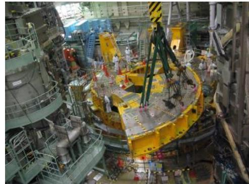
図 3.4.4-8 下架台の吊出し作業
