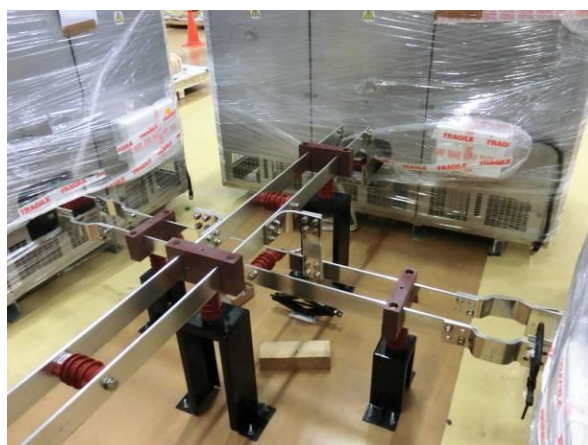
図 23 放電抵抗器用ブスバーの固定・接続
