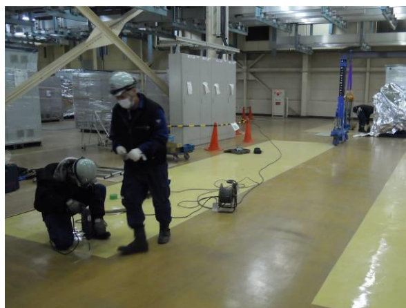
図 19 機器固定用アンカーボルト打設
