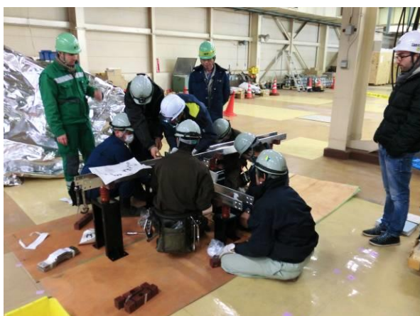
図 22 放電抵抗器用ブスバーの組立
