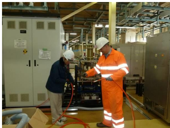
図 25 冷却水ホースの接続
