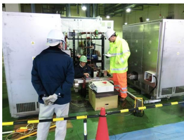
図 27 絶縁抵抗測定（QPC 主回路一括）
