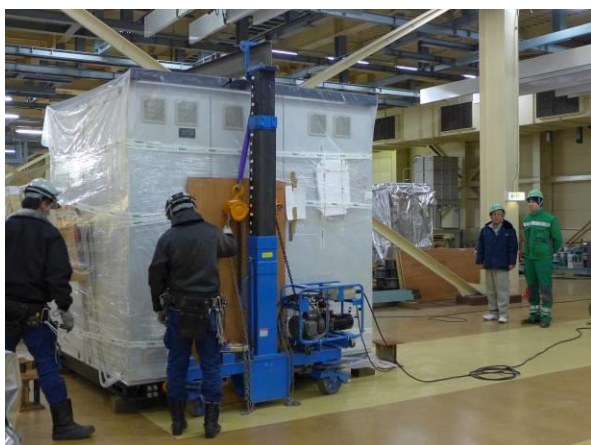
図 20 据付け位置への QPC 機器移動作業
