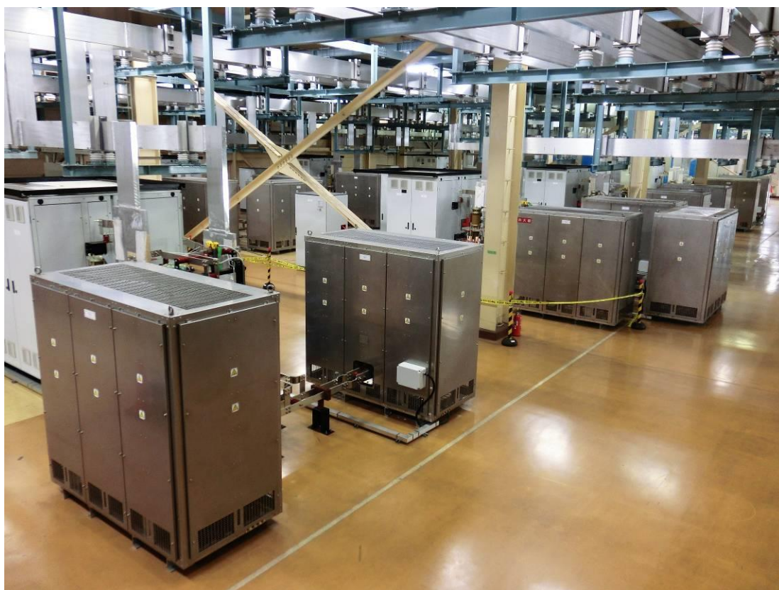
図 33 現地作業完了後の QPC (JT-60 整流器棟 2F)
