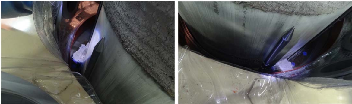
炉心上部機構据付面のナトリウム付着状況
