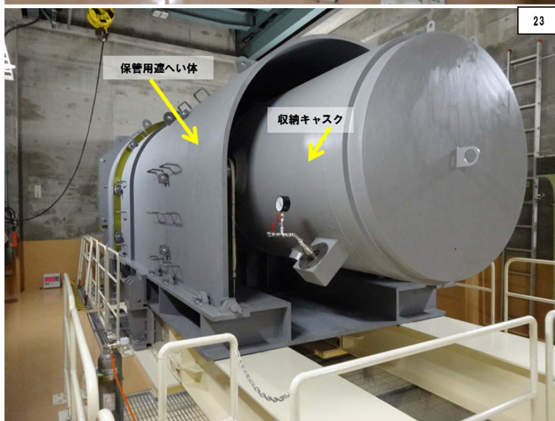
図 5.2.2 旧炉心上部機構引抜作業の状況 (7/7)
