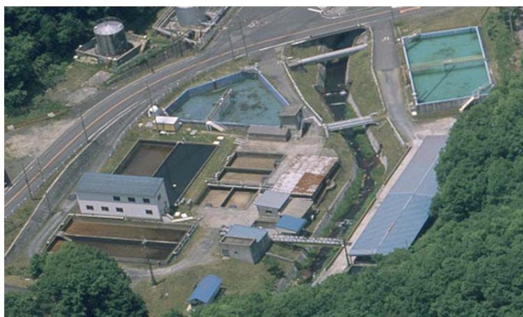
写真-2 坑廃水処理施設の全景
