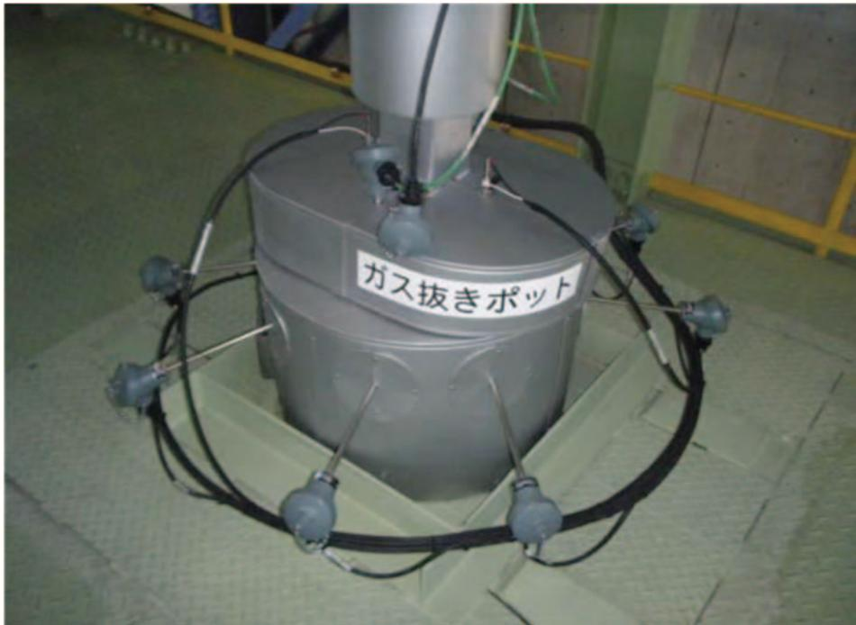
写真 5-27 ガス抜きポット外装板施工後
