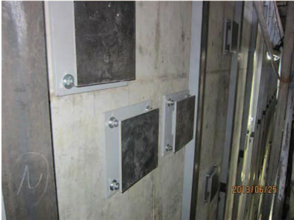
写真 5-49 ダンプタンクピット後打ち金物施工
