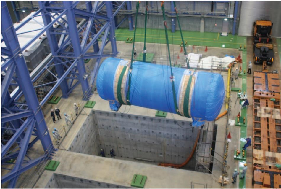
写真 5-5 天井クレーンによるダンプタンクの吊上げ作業
