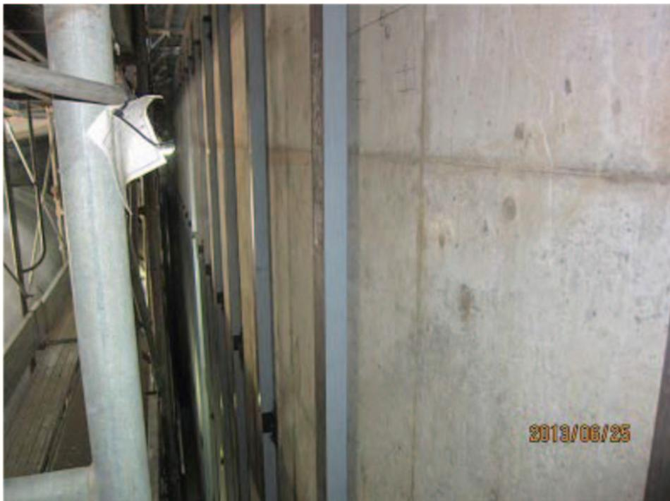
写真 5-50 ダンプタンクピット内下地材取付
