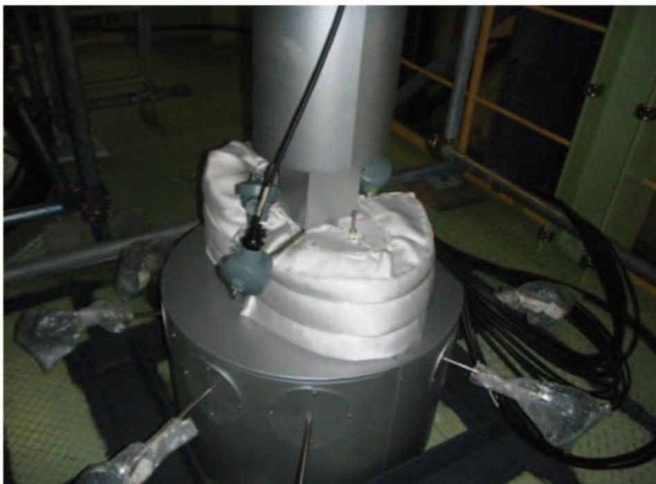
写真 5-26 ガス抜きポット液位計フランジのパッケージ保温状態
