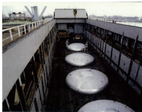
写真 4-2 ダンプタンク鏡板
