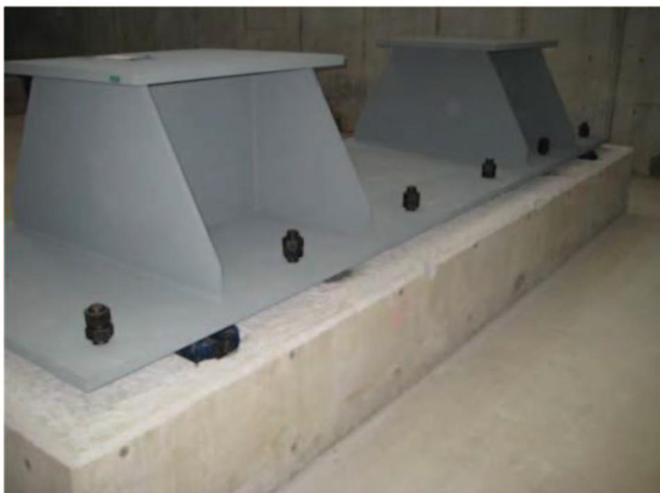
写真 5-4 固定側架台据付
