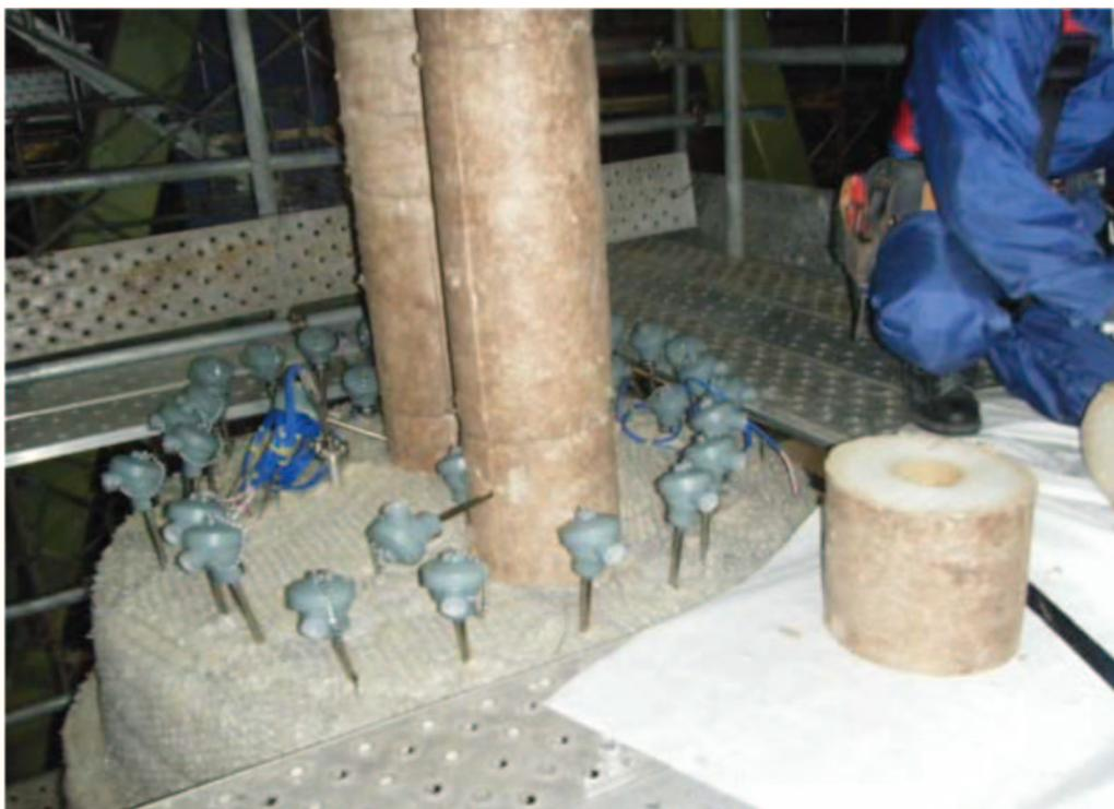
写真 5-16 コールドトラップ本体保温施工後
