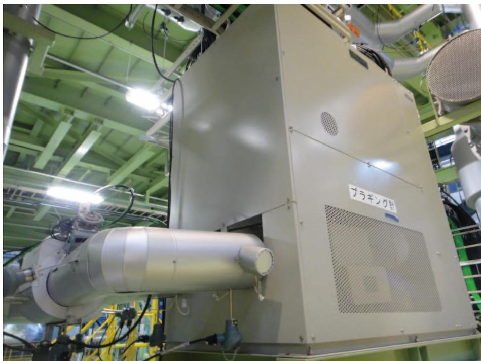
写真 5-30 プラギング計外装板取付施工後
