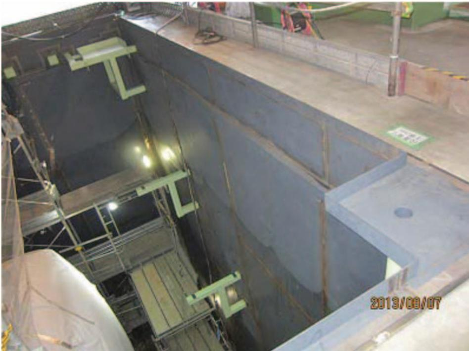
写真 5-52 ダンプタンクピット内ライナー施工完了
