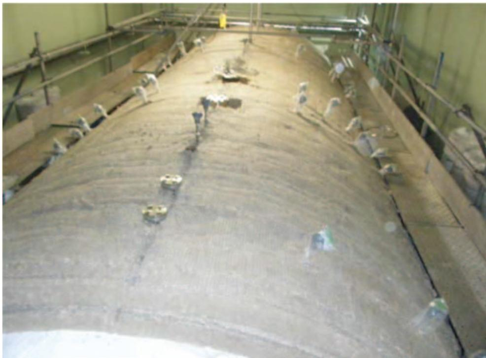
写真 5-11 ダンプタンク保温施工状態 (ダンプタンク 1)
