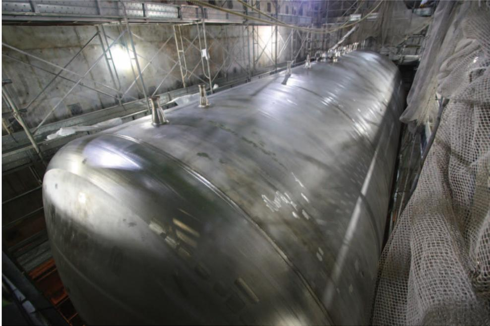
写真 5-9 ダンプタンク 1 据付状態 (養生シート取外後)
