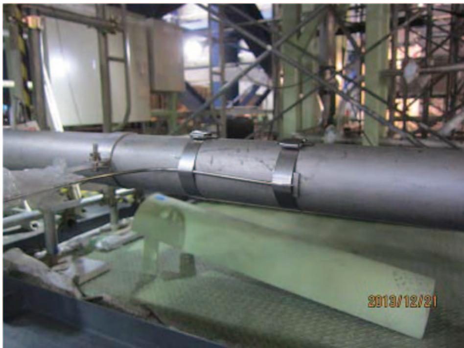
写真 5-41 ナトリウム配管への熱電対取付状態
