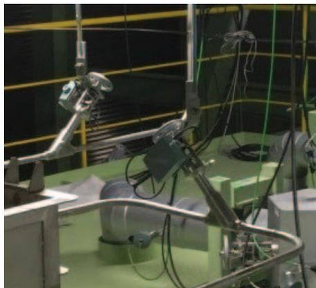
写真 5-34 ナトリウム弁保温施工前の状態
