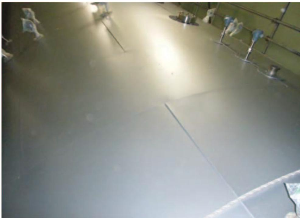
写真 5-12 ダンプタンク外装板施工状態 (ダンプタンク 1)
