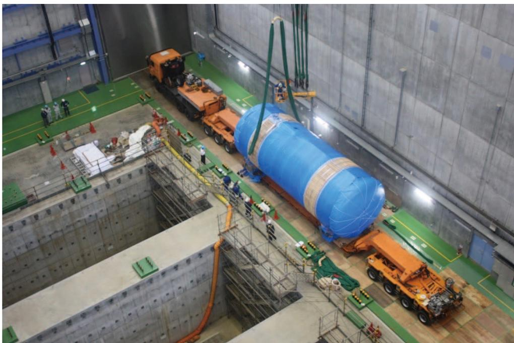
写真 4-83 建屋内ダンプタンク搬入完了
