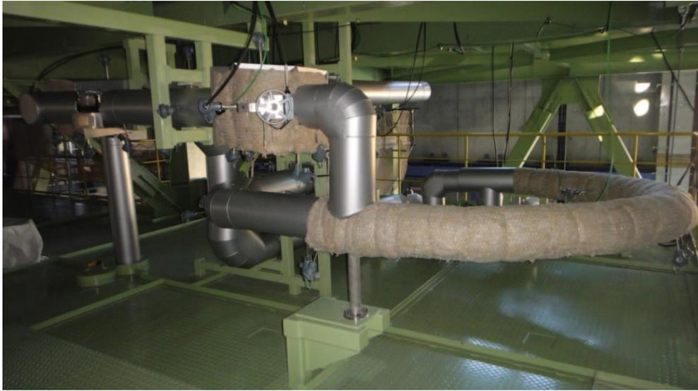
写真 5-19 エコノマイザ保温施工後
