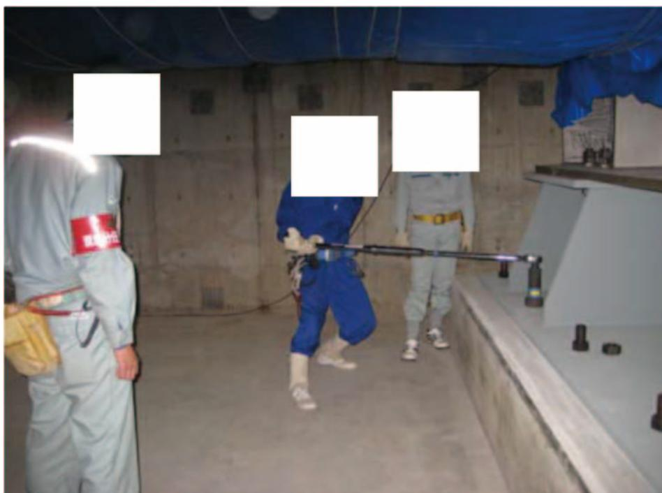
写真 5-8 ダンプタンク基礎ボルト、固定ボルトの締結作業
