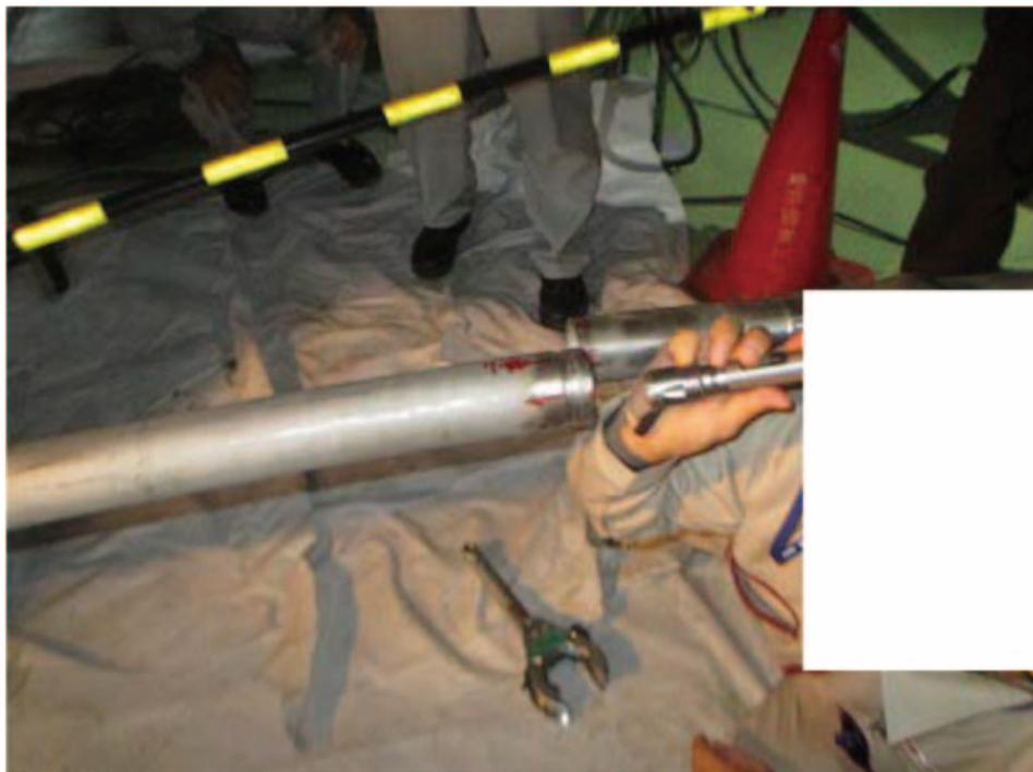
写真 5-39 配管内異物混入確認状況
