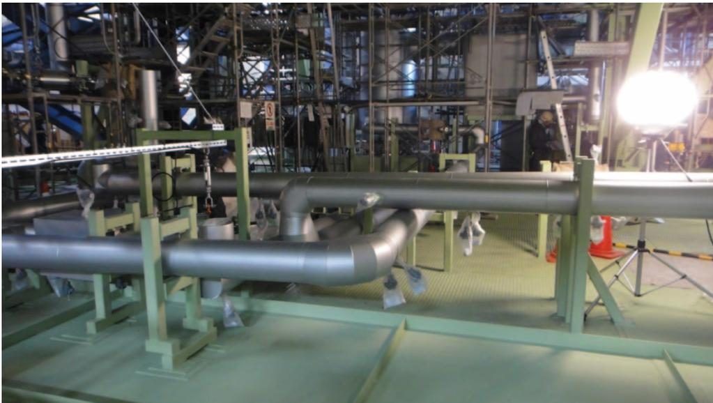
写真 5-44 ナトリウム配管外装板施工後
