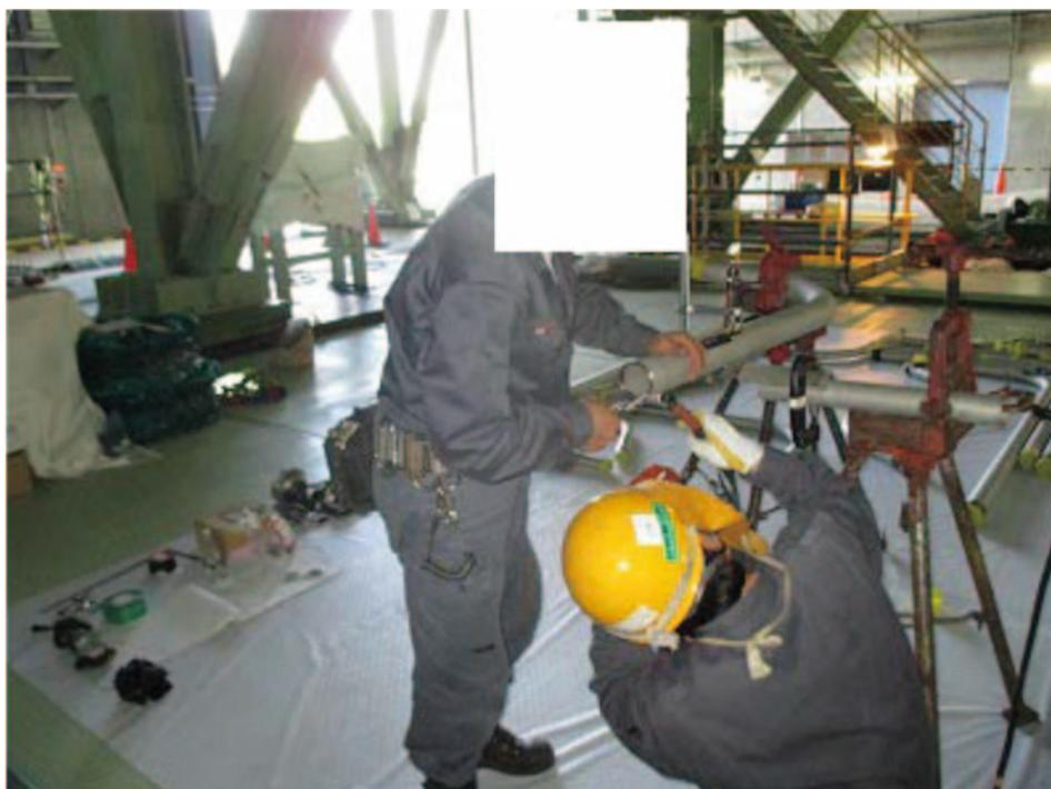
写真 5-36 ナトリウム配管仮付け溶接作業
