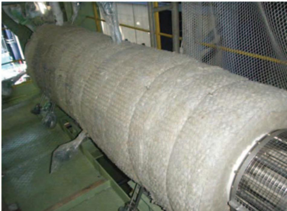
写真 5-22 戻り加熱器保温施工後
