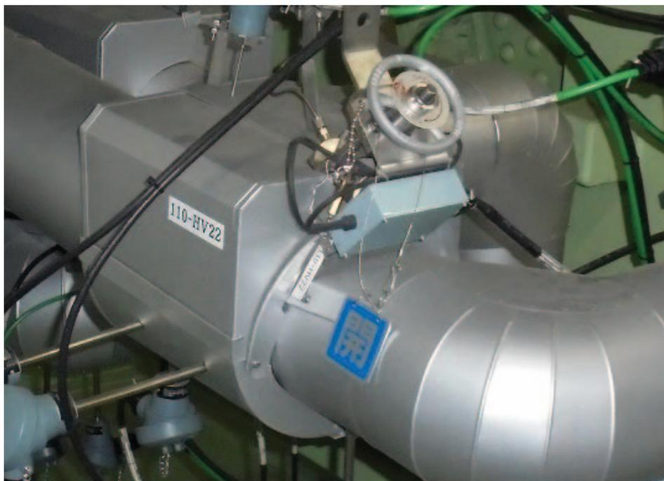
写真 5-35 ナトリウム弁外装板施工後
