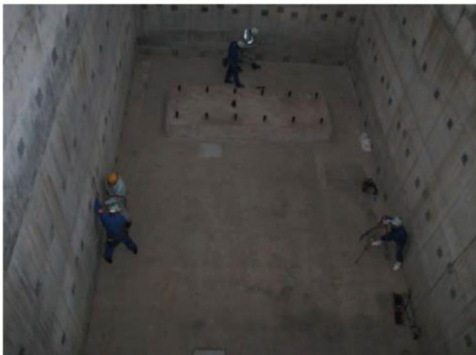
写真 5-1 ダンプタンク据付前タンク据付基準芯罫書き作業
