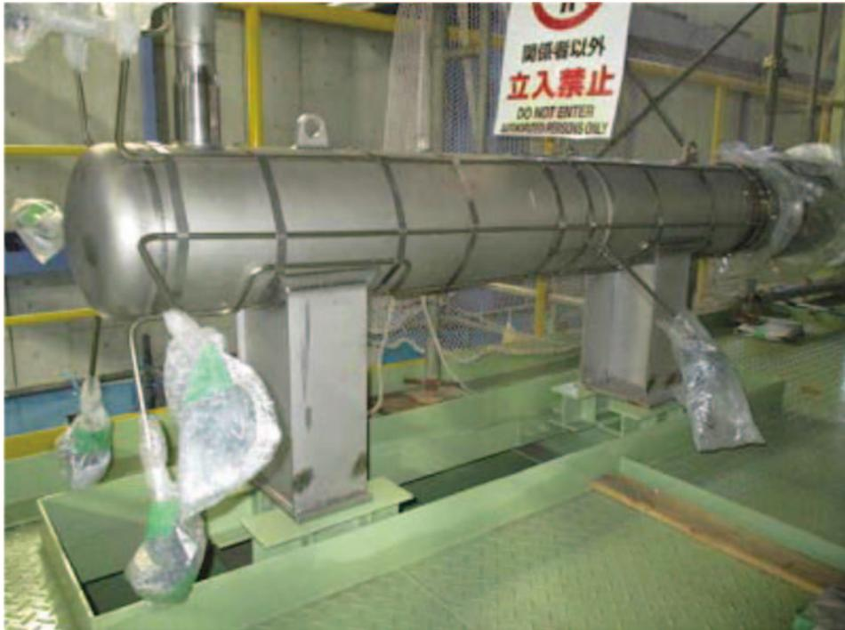
写真 5-21 戻り加熱器据付状態
