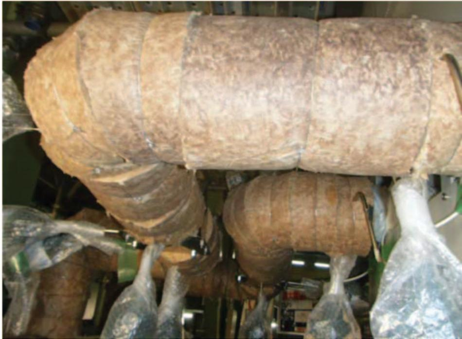
写真 5-43 ナトリウム配管保温施工
