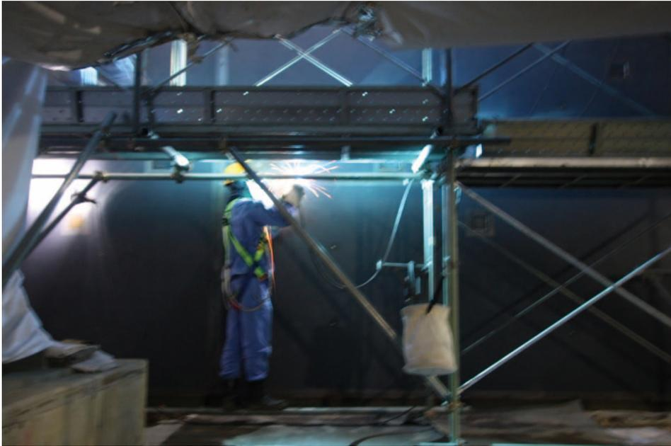
写真 5-51 ダンプタンクピットライナー溶接作業
