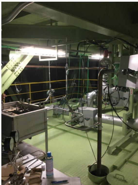
写真 5-46 ナトリウムサンプリング装置配管接続後（保温施工前）
