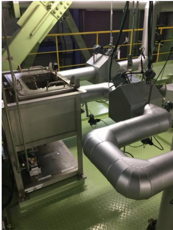
写真 5-47 ナトリウムサンプリング装置据付状態（保温施工後）
