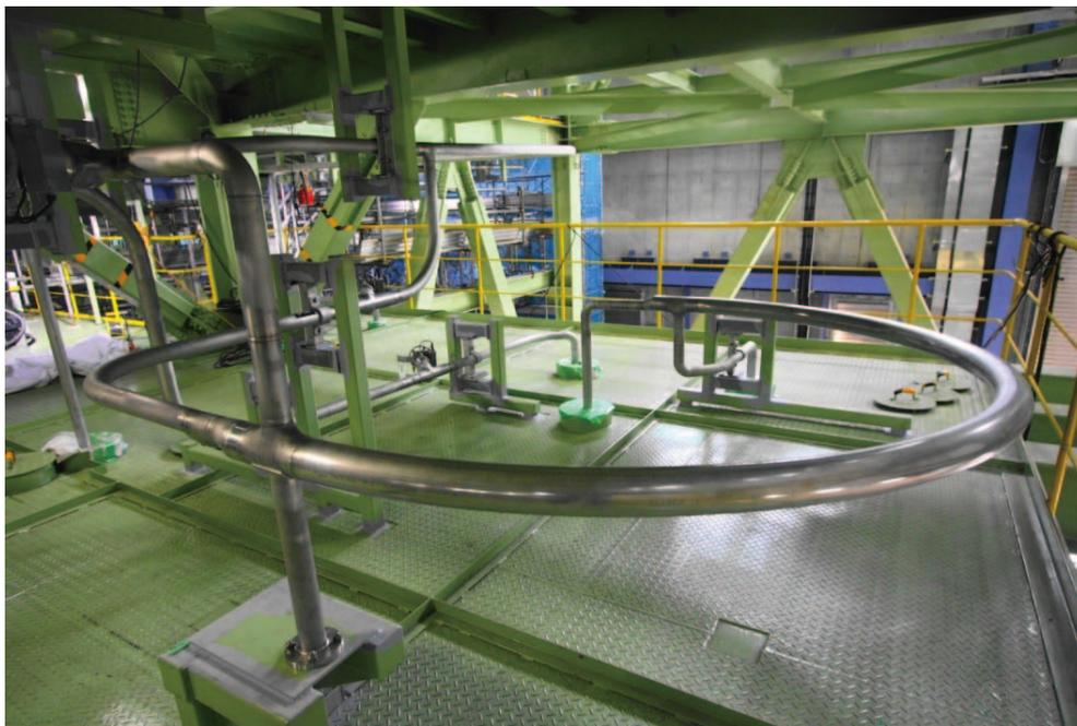
写真 5-18 エコノマイザ据付け状態
