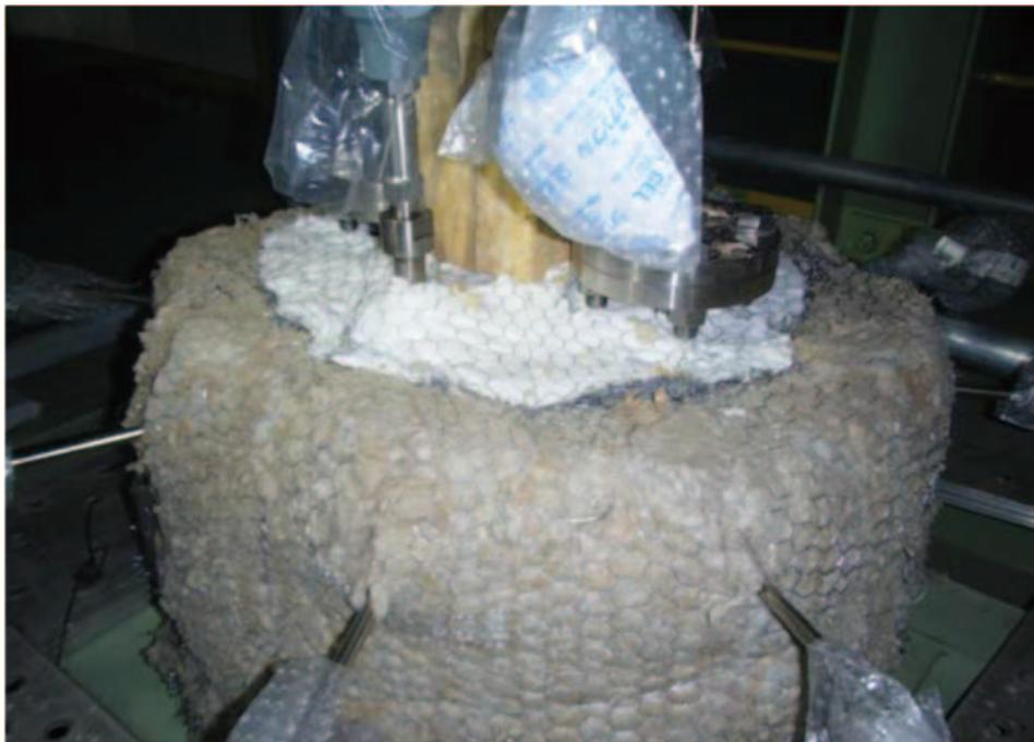
写真 5-25 ガス抜きポット保温施工後
