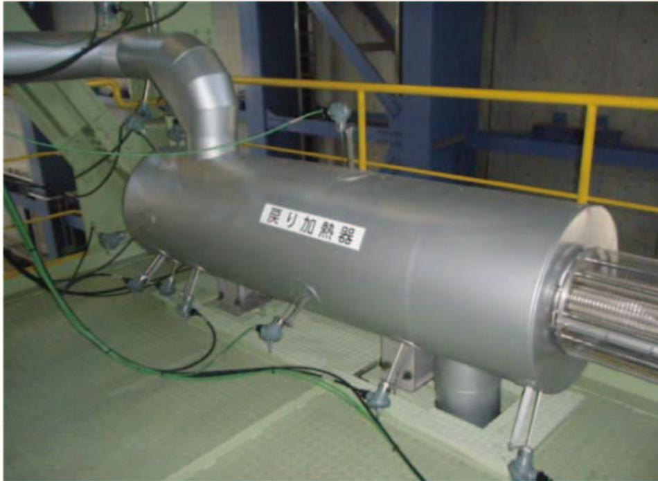
写真 5-23 戻り加熱器外装板施工後
