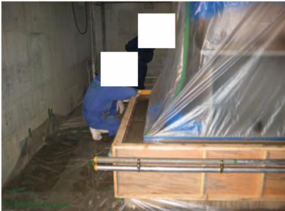
写真 5-6 ダンプタンク基礎部のグラウト施工作业
