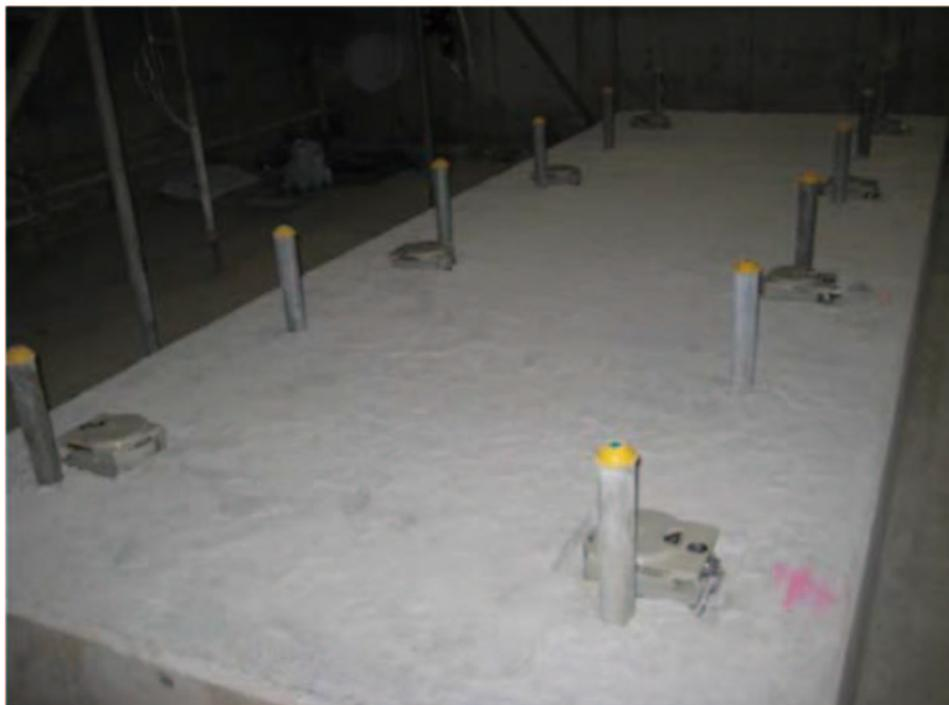
写真 5-3 基礎台部への高さ調整用レベリングブロック配置状況
