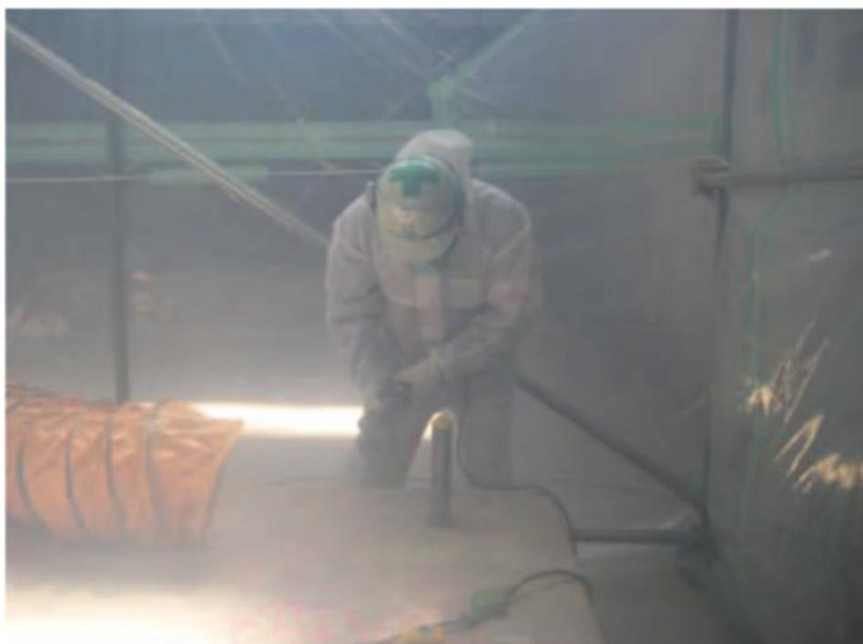
写真 5-2 ダンプタンク基礎台チップング作業
