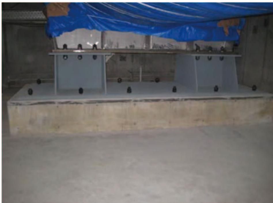
写真 5-7 ダンプタンク基礎部グラウト施工後の型枠取り外し状態
