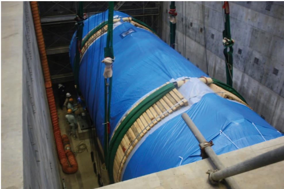
写真 5-10 ダンプタンク 2 据付状況 (養生状態)
