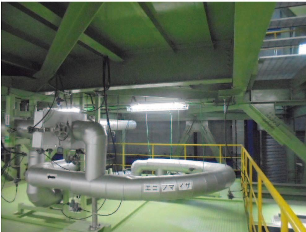
写真 5-20 エコノマイザ外装板施工後
