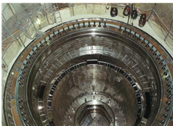
写真7-2 内筒据付後の炉内状況
