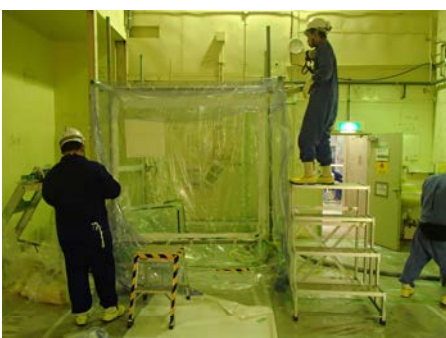
はつり作業グリーンハウス設置
