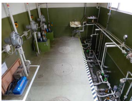
廃液貯槽建家内（撤去前）
