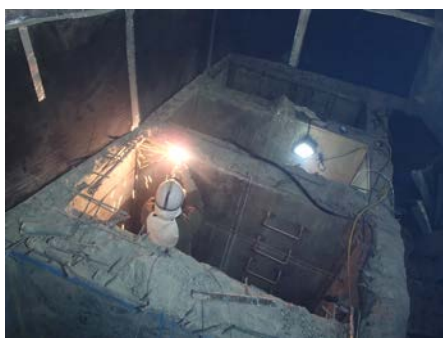
廃液貯槽解体 1
