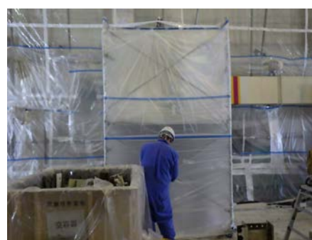
排気ダクト解体撤去 1
