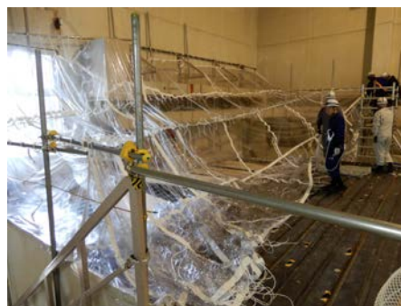
グリーンハウス設置 4 (115,116 号室付近)
