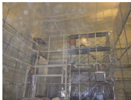
管理区域区画撤去後
