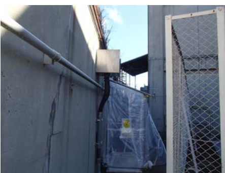
廃液貯槽排気管撤去
