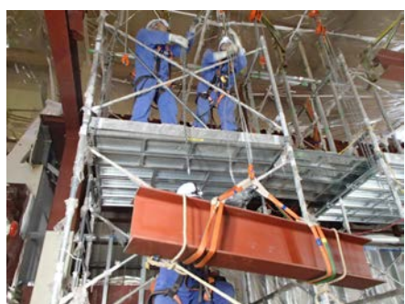
管理区域区画梁・支柱解体 2
