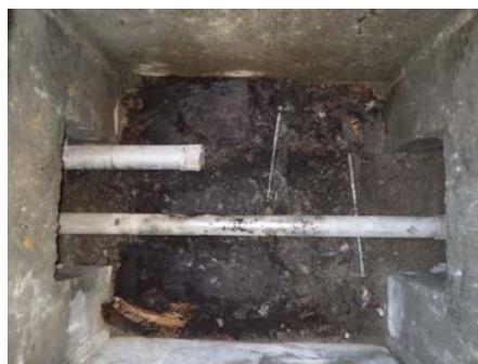
廃液貯槽建家へ配管引込（経路途中）
