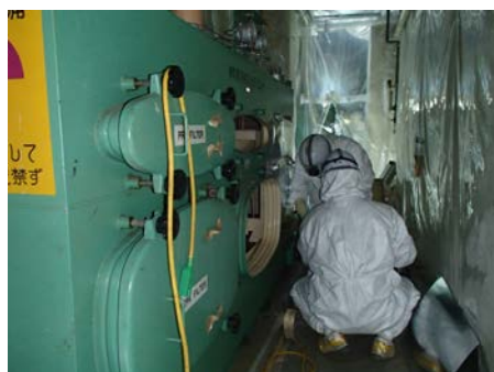
排気フィルタ解体 2
