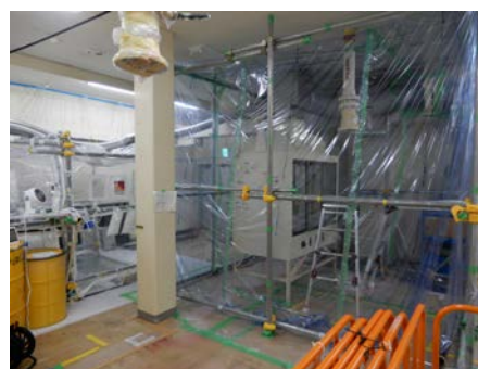
グリーンハウス設置
