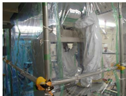
フード本体解体 1
