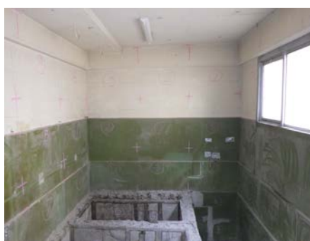
廃液貯槽建家内（撤去後）
