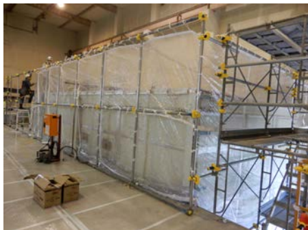
グリーンハウス設置 1 (117,118 号室付近)
