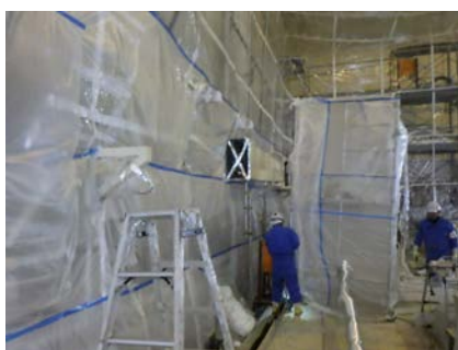
排気ダクト解体撤去 2
