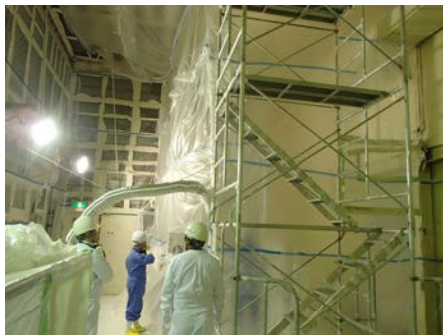
管理区域内壁材解体 1
