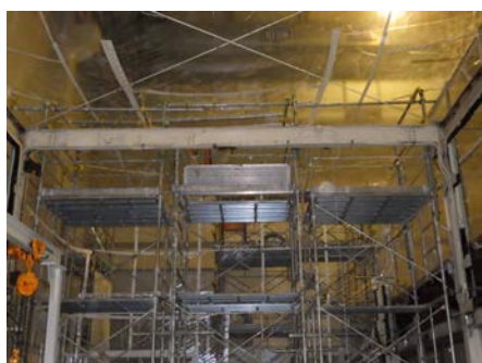
解体用ローリングタワー設置
