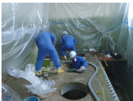
廃液貯槽天面コンクリート撤去 1
