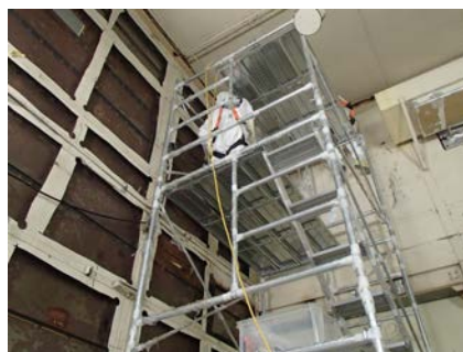
管理区域内壁材解体 2
