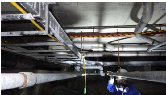
地下ピット内
