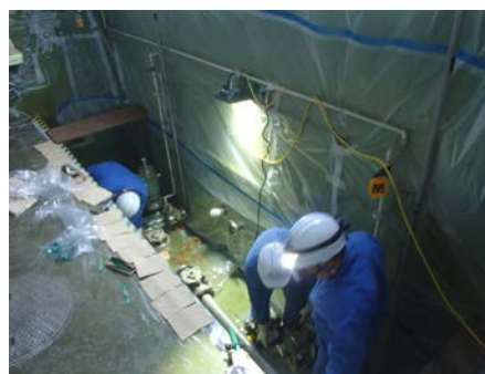
建家内配管解体
