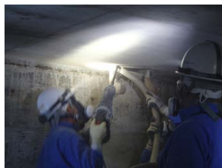
埋設箇所掘削
