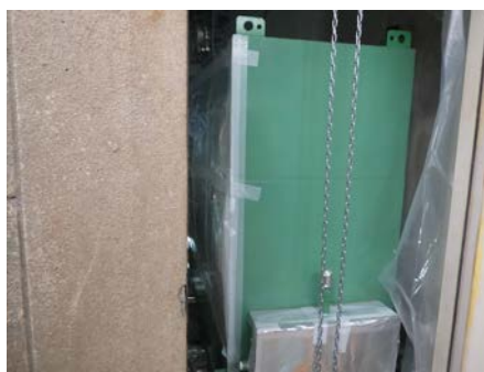
排気フィルタ撤去
