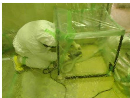
はつり作業 (グリーンハウス内に小型の養生を設置)
