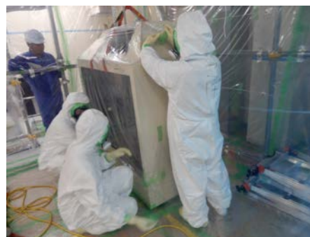
フード本体解体 3
