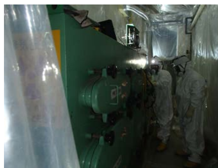
排気フィルタ解体 1
