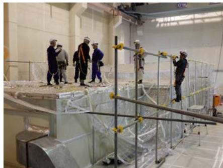
グリーンハウス設置 2 (117,118 号室付近)
