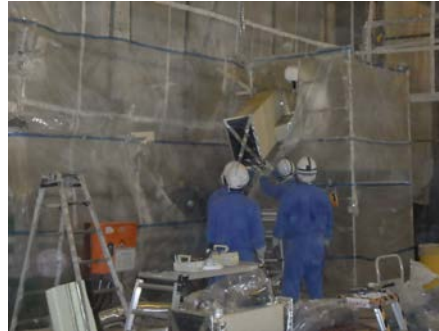
排気ダクト解体撤去 3
