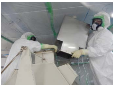
排気ダクト分離
