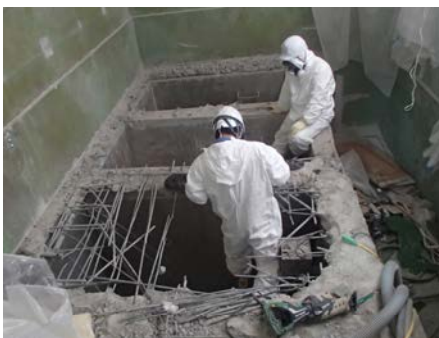
廃液貯槽天面コンクリート撤去 2
