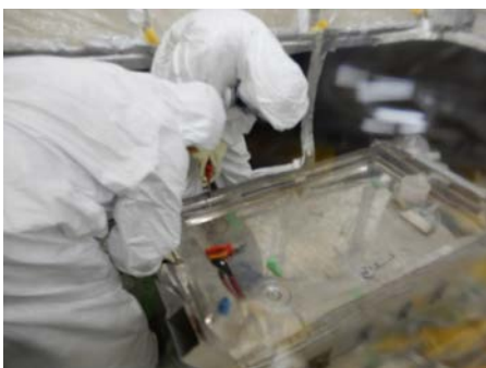
フード本体解体 4
