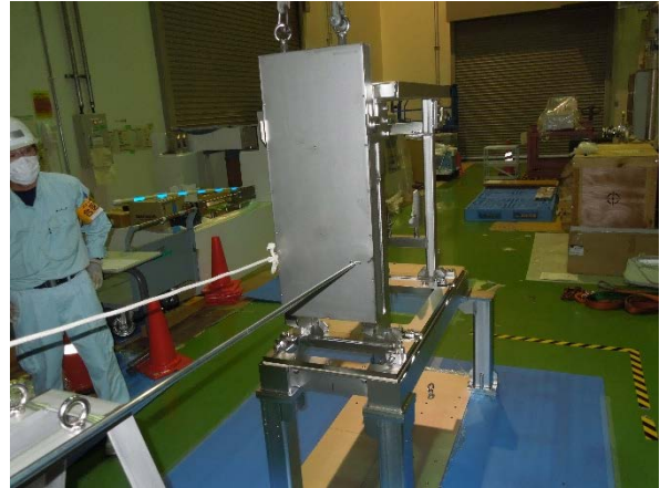
図 4.4-2 新架台ユニットへの遮蔽体設置
