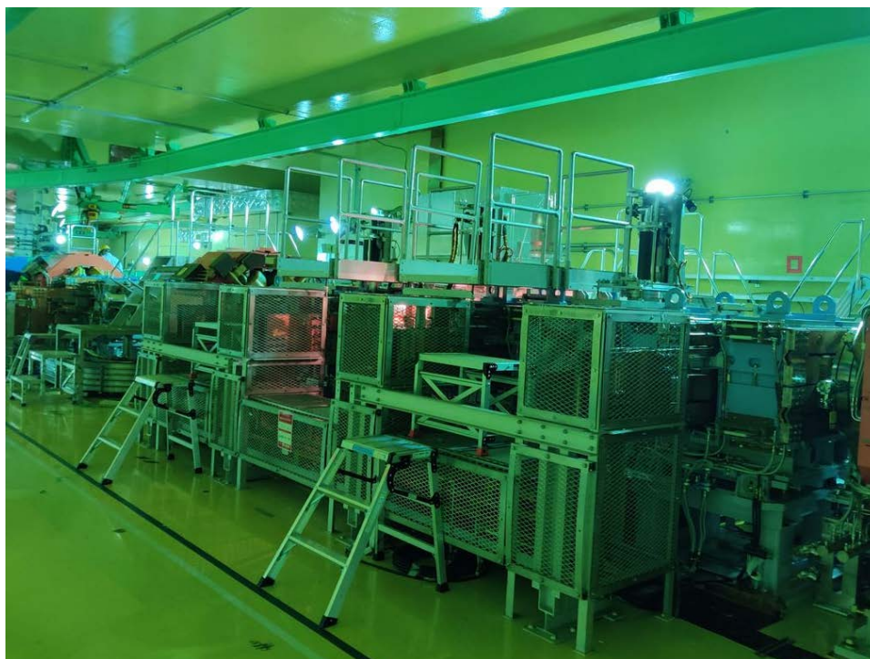
図 4.2-5 作業台設置作業終了後の入射部の様子
