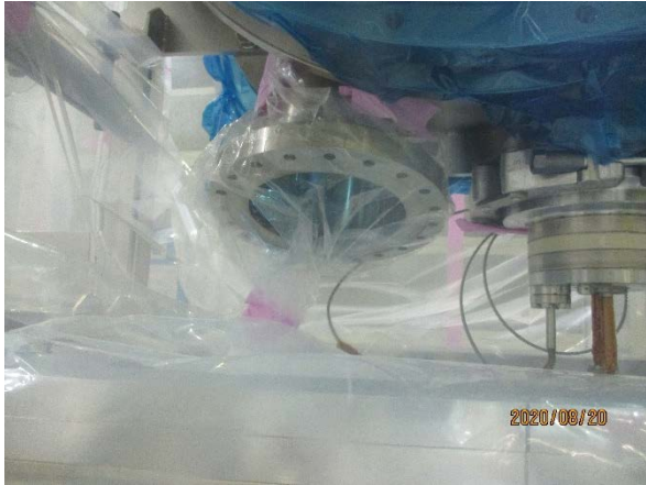
図 4.4-21 W1 真空窓の取外し
