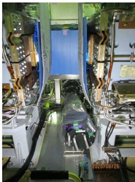
図 4.4-36 観測系ダクトの設置
