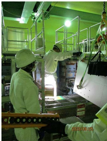
図 4.4-33 ベースプレートの吊り込み
