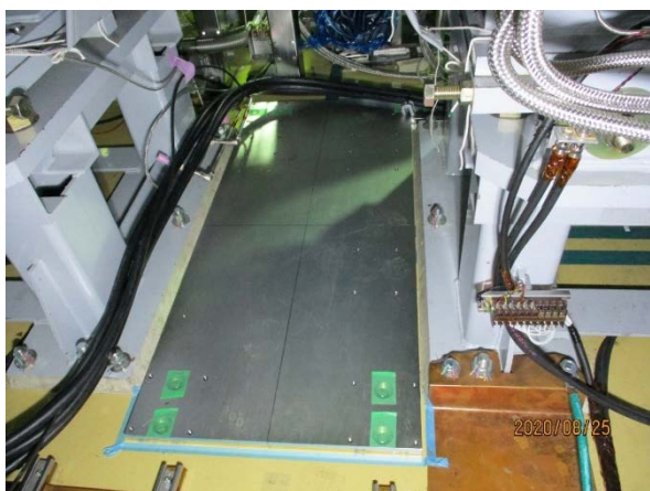
図 4.4-35 ベースプレート設置完了後
