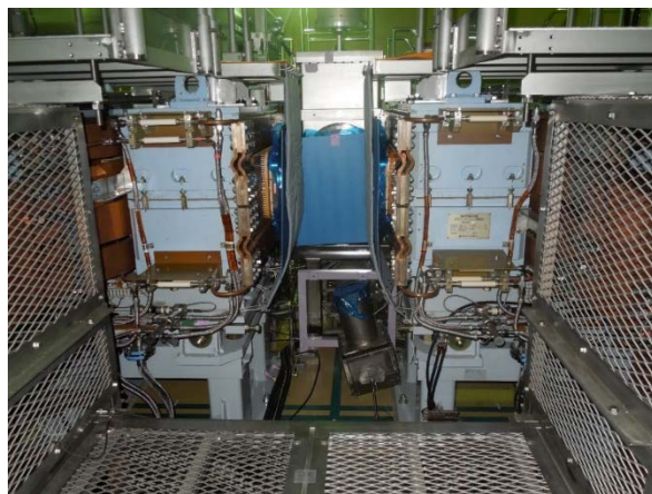
図 4.4-14 架台ユニット取外し中の入射部
