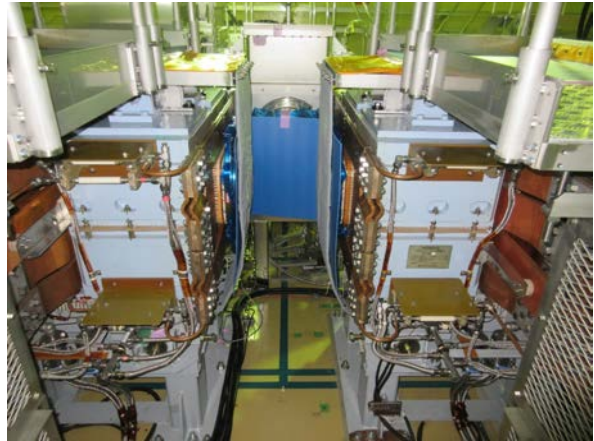
図 6.2-2 ビームライン開口部に設置した鉛マット（灰色）
