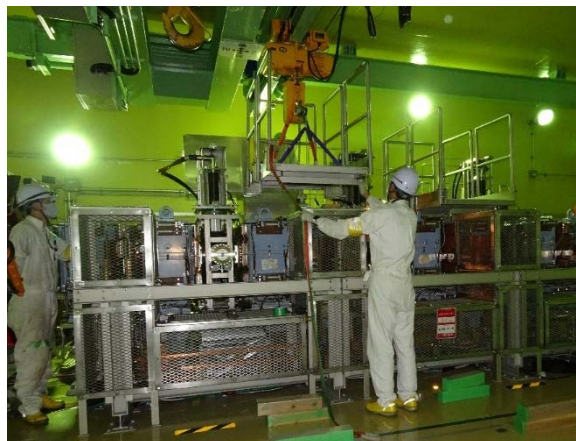
図 4.2-4 作業台設置作業の様子
