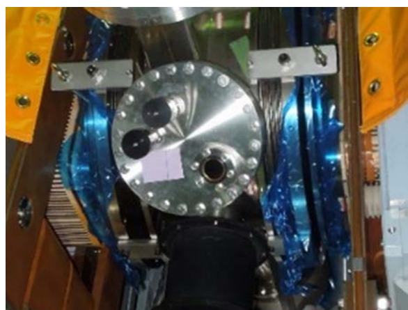
図 4.4-10 接続ベローズの切り離し
