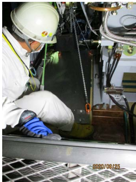
図 4.4-34 ベースプレートの設置
