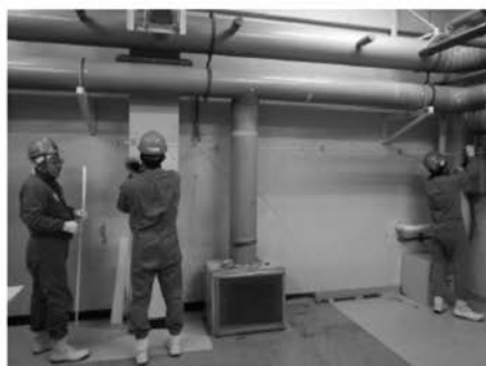
写真-4 作業状況 汚染検査準備作業 マーキング
