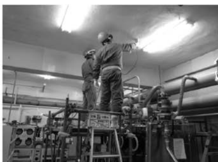
写真-11 作業状況 汚染検査 ダイレクト法汚染検査
