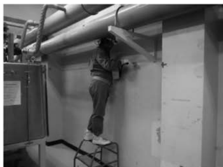
写真-10 作業状況 汚染検査 ダイレクト法汚染検査
