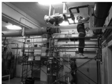
写真-8 作業状況 汚染検査 ダイレクト法汚染検査
