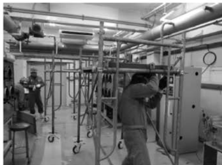
写真-2 作業状況 枠組み足場組立
