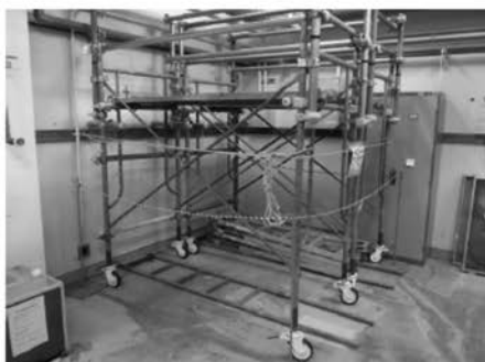
写真-3 作業状況 枠組み足場組立(不使用時仮置き)
