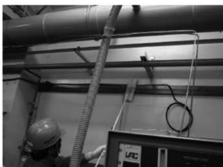
写真-5 作業状況 汚染検査 スミヤ法汚染検査
