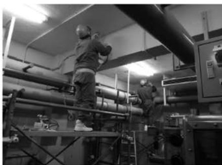
写真-9 作業状況 汚染検査 ダイレクト法汚染検査
