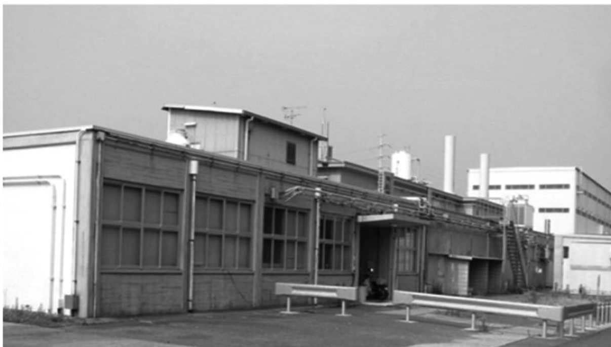
Photo 1 プルトニウム研究1棟外観写真
