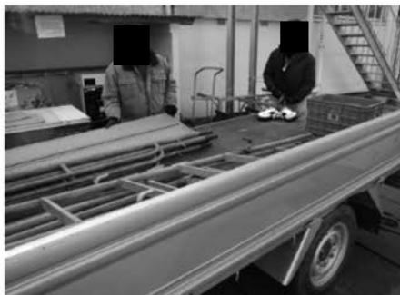
写真-1 作業状況 資機材搬入
