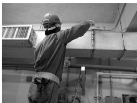
写真-6 作業状況 汚染検査 スミヤ法汚染検査
