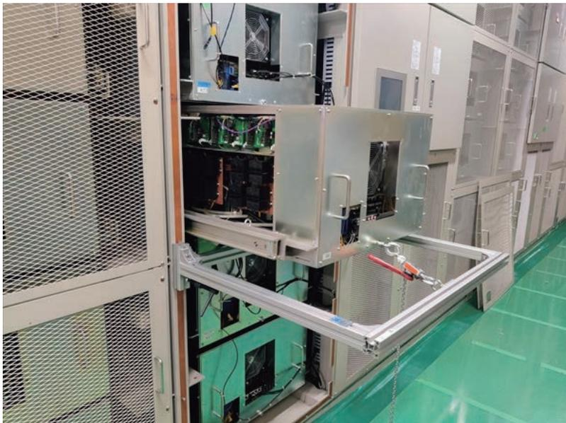
図 20-2：新しい治具（治具 1）での上下ユニット初動引き出し後
