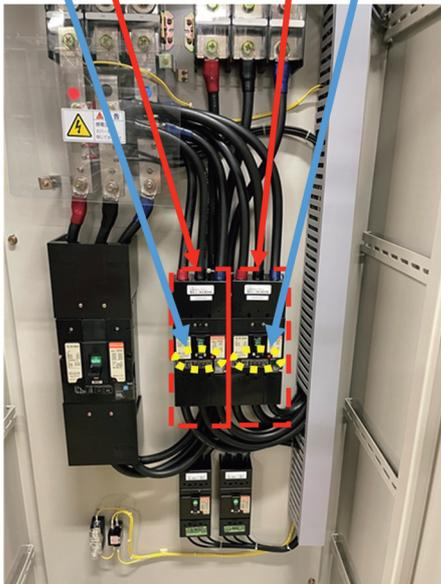
図 9-8-1 分電盤 (B1F-EMG-2 : AC400V) 内の各電源ブレーカーの位置
