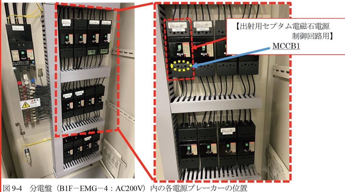
図9-4 分電盤 (B1F-EMG-4 : AC200V) 内の各電源ブレーカーの位置
