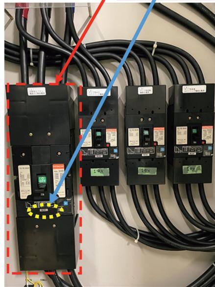
図 9-8-2 分電盤 (B1F-IMG-2 : AC400V) 内の各電源ブレーカーの位置
