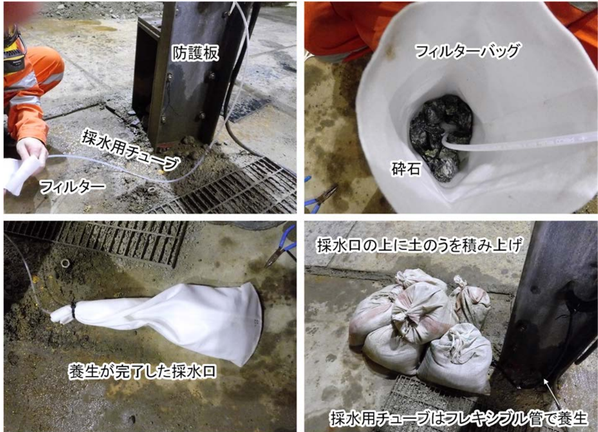
図 4-10 埋め戻し面に設置した採水口の養生風景
