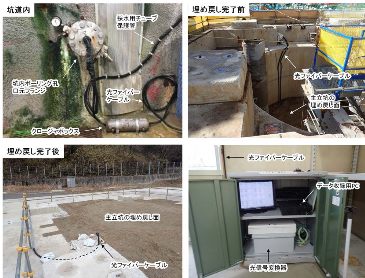
図 4-4 光ファイバケーブルの坑道内の配置と埋め戻し後の風景
