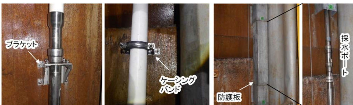
図 4-9 立坑壁面に設置した採水用配管とその固定具
