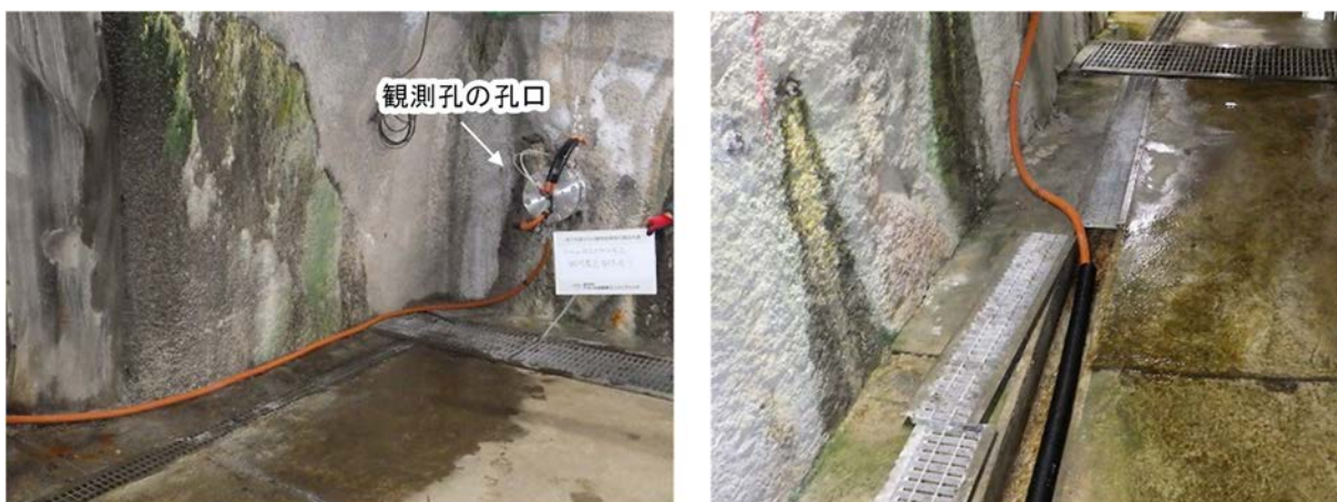
図 4-8 養生した採水用チューブの設置箇所例
