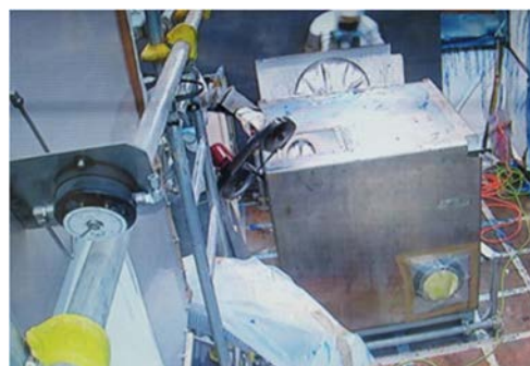
(8) H-11 の解体①
