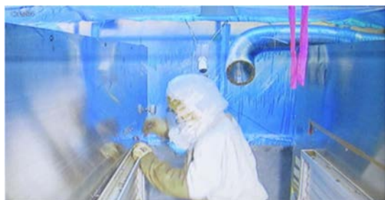
(1) H-19 の解体撤去①（フード天井部）
