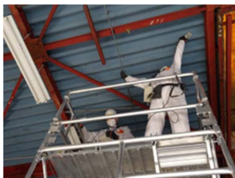
(3) 天井の汚染検査①
