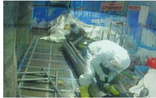
(2) 配管類の細断作業②
