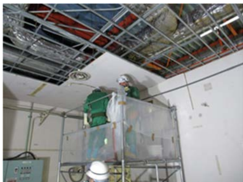
(1) 給気ダクトの撤去作業①
