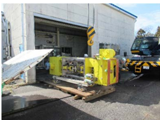
(5) 施設からの搬出作業①
