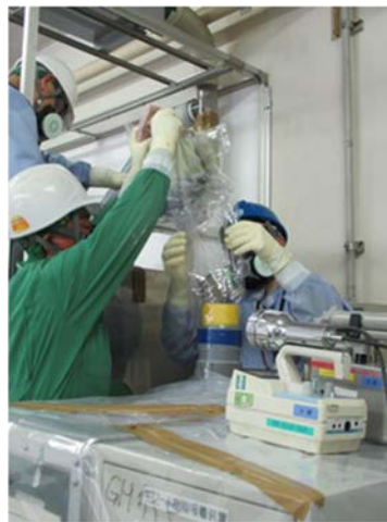
(2) 排気ダクトの養生②
