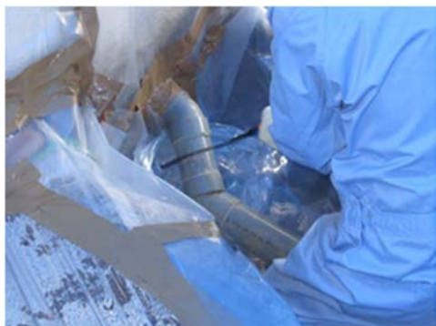
(1) 塩ビ配管の切断①
