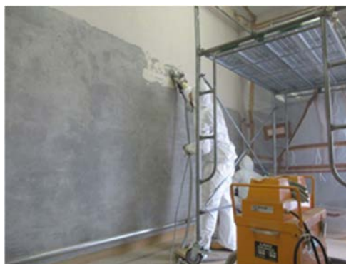
(2) 壁の塗料等の除去作業②
