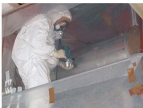
(3) 給気ダクトの撤去作業③
