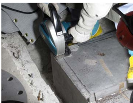
(5) 屋内ピットの切断作業①
