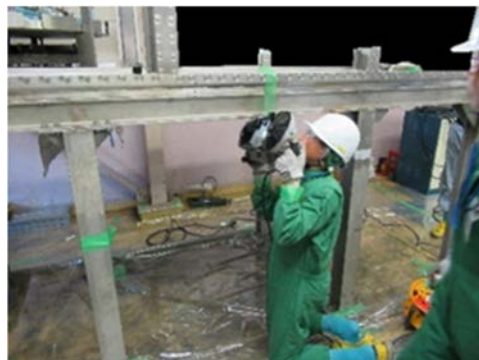
(4) 架台の切断作業
