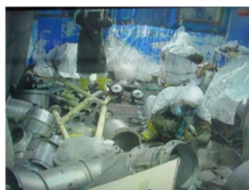
(4) 配管類の細断作業④
