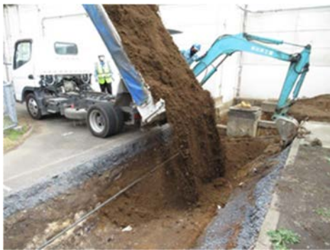
(1) 現状復帰作業①
