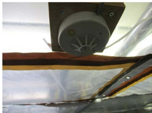
(6) 自動火災報知機の設置
