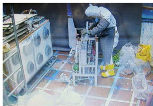
(2) 一次冷水ユニットの解体①
