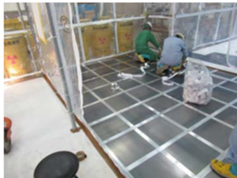
(2) GH 床材（鋼板）の設置
