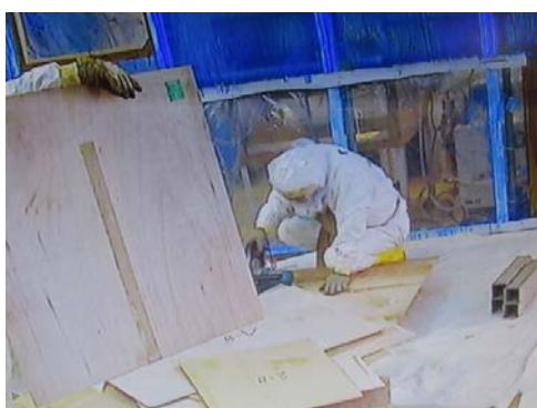
(3) 床材（ベニヤ板）の撤去
