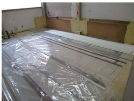
(1) GH 床材（酢ビシート）の設置
