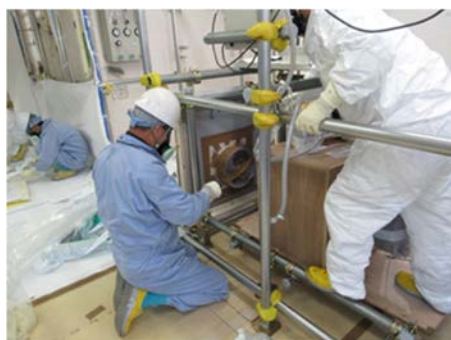
(5) GH 排気ダクトの撤去
