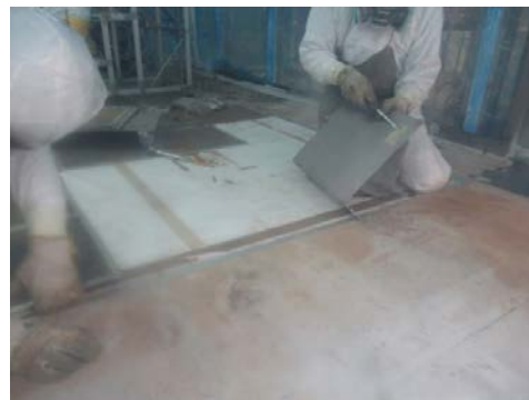
(2) 床材（鋼板）の撤去
