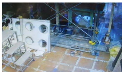
(4) H-24 の解体②（パネル外し）
