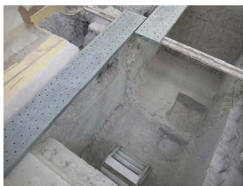
(5) SUS 製屋内ピット除去後
