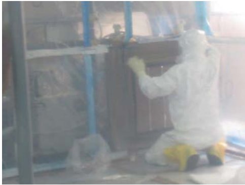
(1) SUS 製デミスタフィルタの撤去
