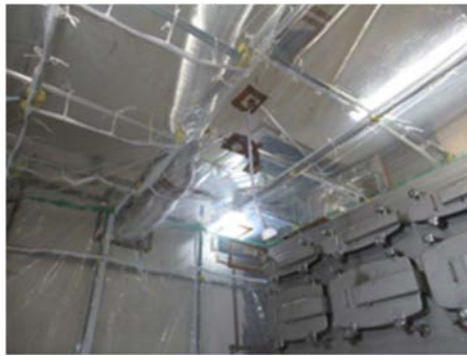
(4) 自動火災報知機、ダスト吸引取り付け
