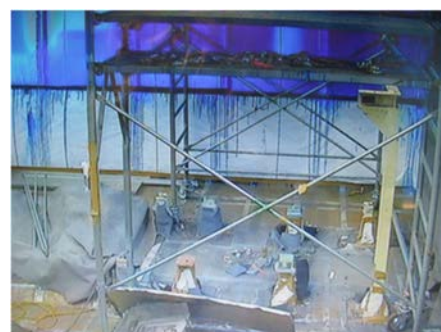
(6) H-24 の解体⑫ (電気炉本体)
