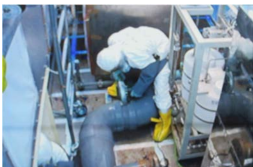
(1) 塩ビダクトの細断
