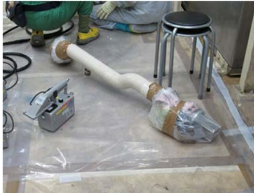
(4) 取り外した真空配管
