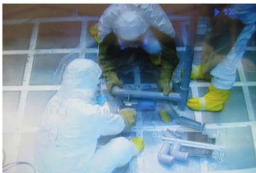
(3) 塩ビ配管の細断①
