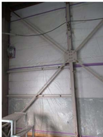
(1) 壁の汚染検査④
