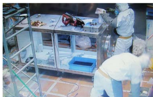
(6) H-8 の解体①
