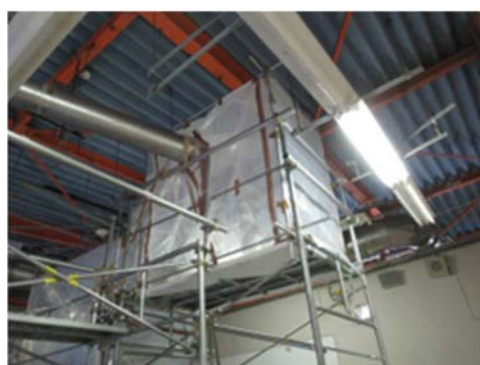
(2) 排気ダクトの撤去作業②
