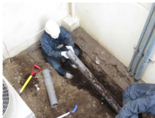
(4) 一般廃水配管の撤去
