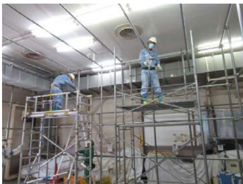
(5) GH 骨組みの撤去
