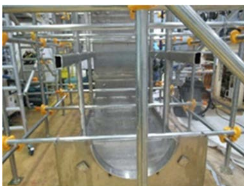
(5) 缶体切断後の状況
