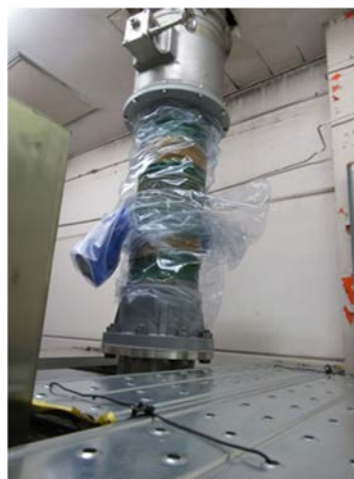
(4) 排気ダクトの養生
