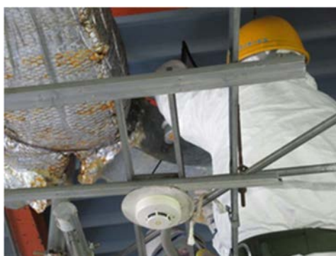
(3) 給気ダクトの撤去作業③
