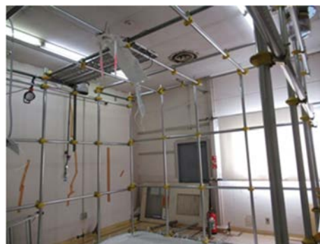
(6) GH 骨組みの撤去
