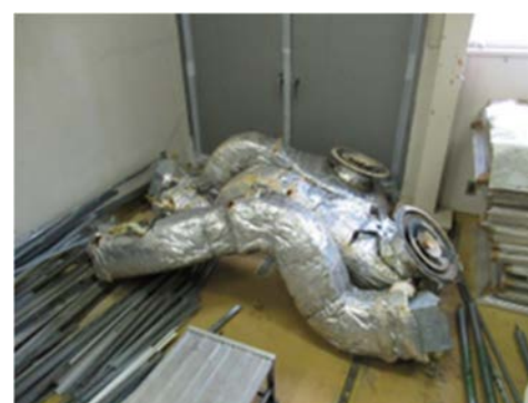
(4) 切断した給気ダクト(例)
