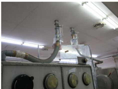
(1) H-8,H-11 排気ダクトの養生
