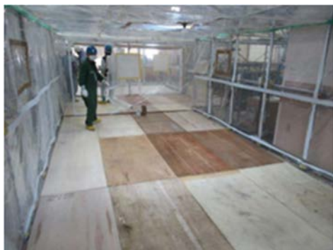
(1) GH 床材（ベニヤ板）の設置
