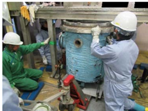
(2) 小型焼結炉の撤去作業①
