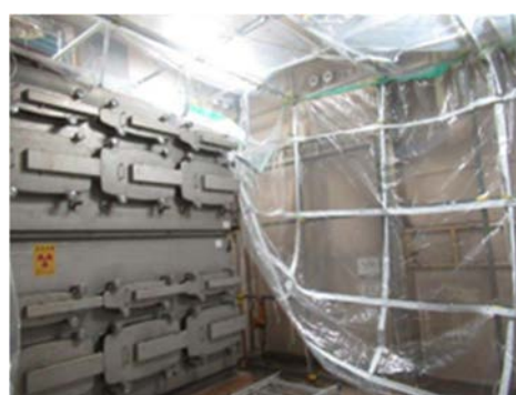
(4) GH テントの取り付け② (R-5 室側)
