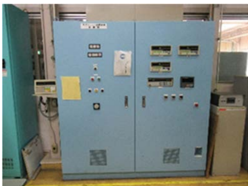
(1) 解体撤去前の制御盤及び操作盤①
