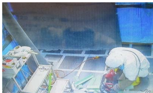
(2) H-20 の解体撤去④（フード架台）
