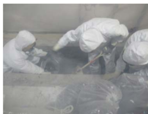
(4) 埋設配管の撤去作業②
