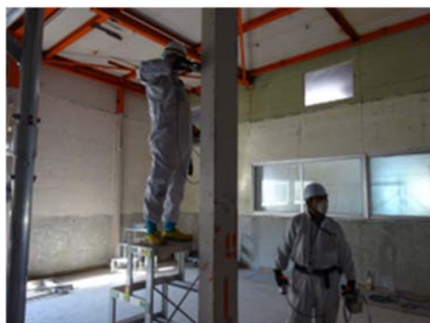
(5) 柱の汚染検査
