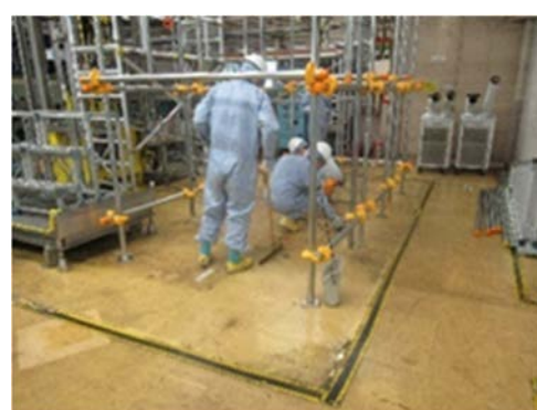
(6) 缶体全体の撤去後
