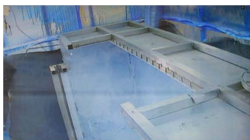
(7) H-20 の解体撤去①（フード天井部）
