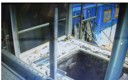
(7) H-24 の解体⑤（電気炉）
