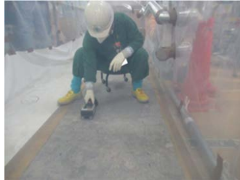
(2) 埋設配管の撤去作業② (金属探知器による調査)
