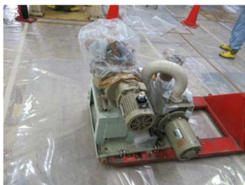
(5) 取り外した真空ポンプ
