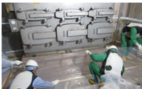
(5) GH 床材 (酢ビシート) の設置
