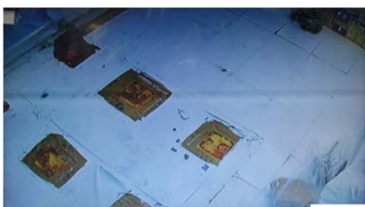
(3) H-24 の解体⑰ (フード架台)
