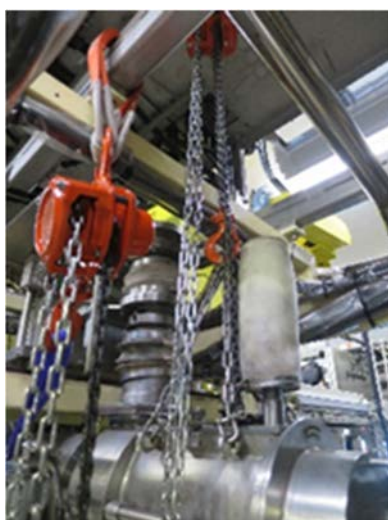
(5) 内装機器の取外し作業
