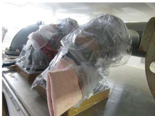
(1) 排気ダクトの養生
