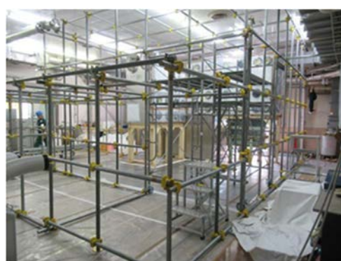
(6) GH 骨組みの設置
