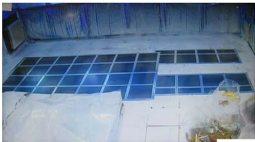
(5) H-24 の解体⑲ (フード架台)
