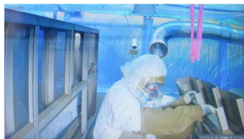
(2) H-19 の解体撤去②（フード前面）
