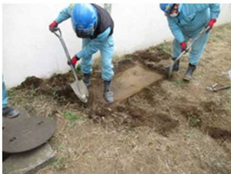
(1) 屋外埋設配管の掘り出し作業①
