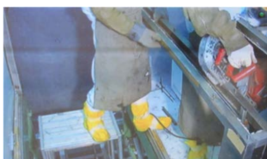
(3) H-19 の解体撤去③（フード天井部）
