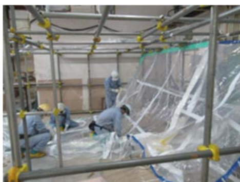
(3) GH テントの取り付け① (R-6 室側)
