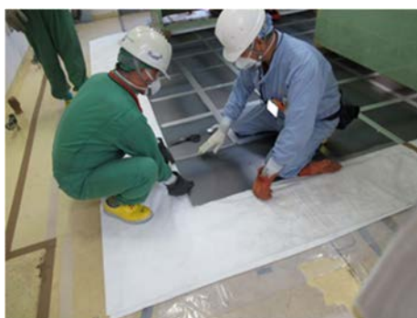
(3) GH 床材（ターポリンシート・鋼板） の設置
