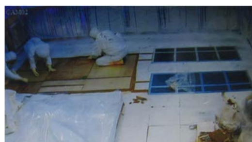
(4) H-24 の解体⑱ (フード架台)
