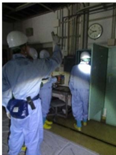
(2) 配線の切離し作業
