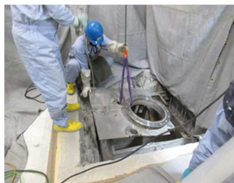
(6) 屋内ピット天井の除去
