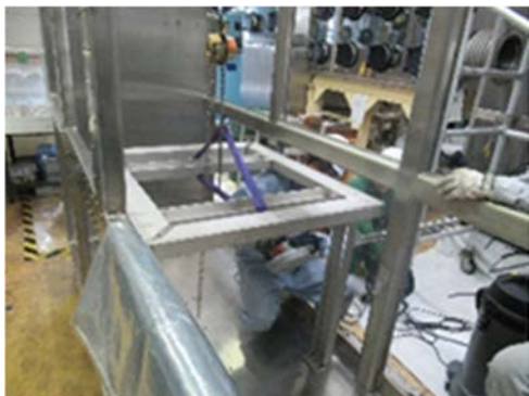
(1) 内装機器の筐体の解体
