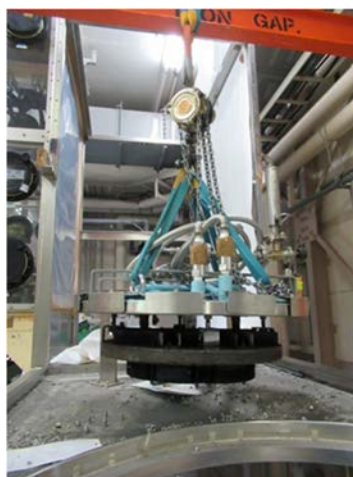
(4) 焼結炉蓋の取出し
