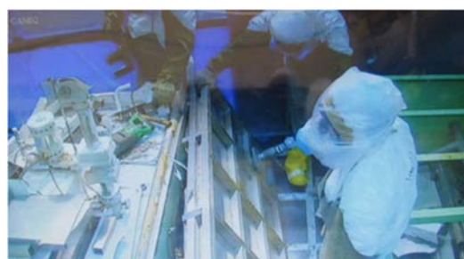
(4) H-19 の解体撤去④（フード床面）
