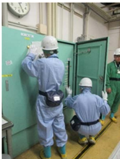
(1) 設備電源切離し前の確認
