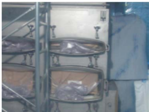
(1) HEPA フィルタの抜き取り①
