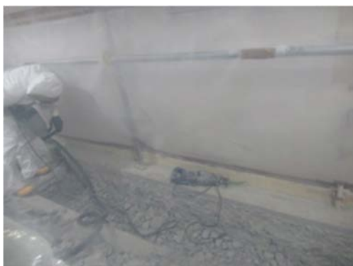
(3) 埋設配管の撤去作業①
