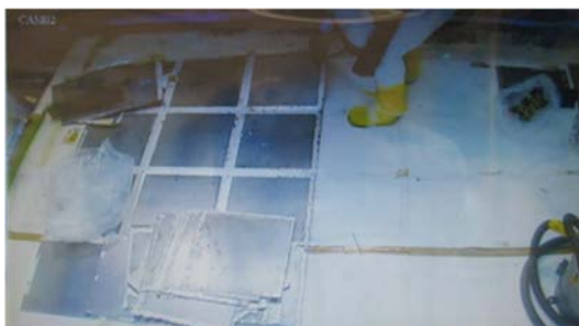
(1) 床材（鋼板）の撤去①
