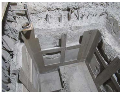
(1) 屋内ピットの切断作業②
