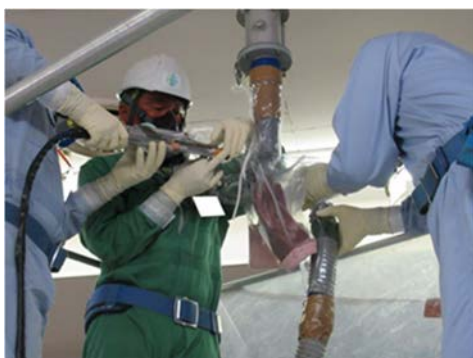
(3) H-8 排気ダクトの切離し
