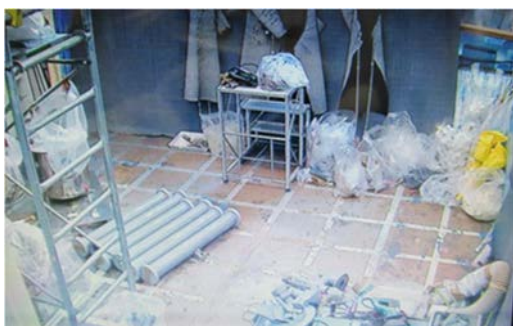
(5) 廃液処理設備の解体②
