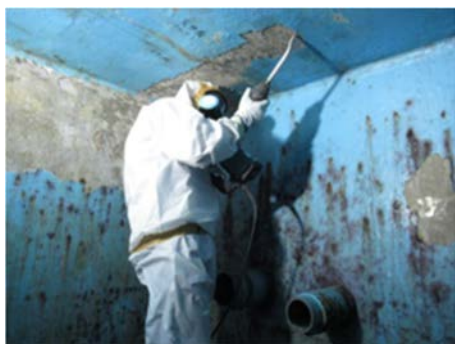
(1) 壁面のハツリ作業①
