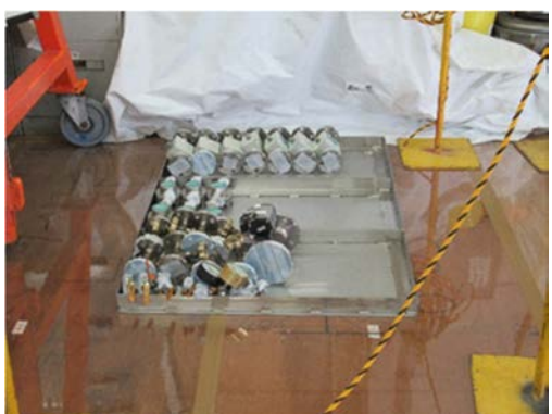
(5) 二次冷却水配管フランジ
