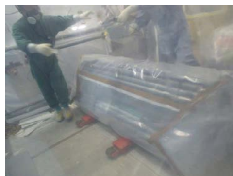
(6) GH 内足場の撤去②（搬出作業）
