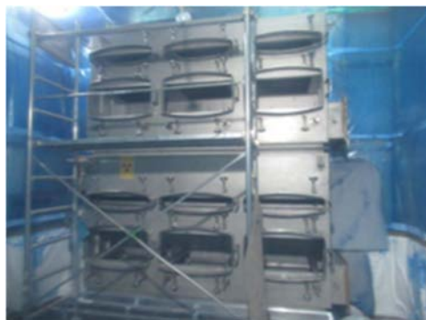
(2) HEPA フィルタの抜き取り②
