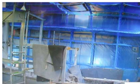
(8) H-24 の解体⑥（缶体）
