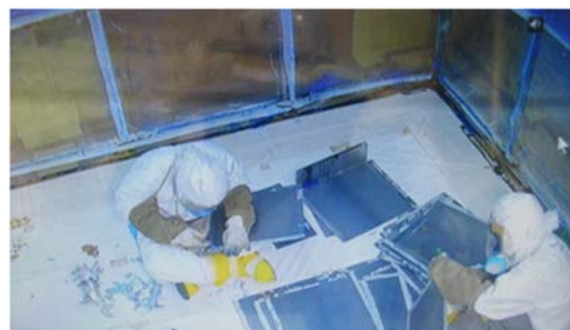
(2) 床材（鋼板）の撤去②（分別作業）
