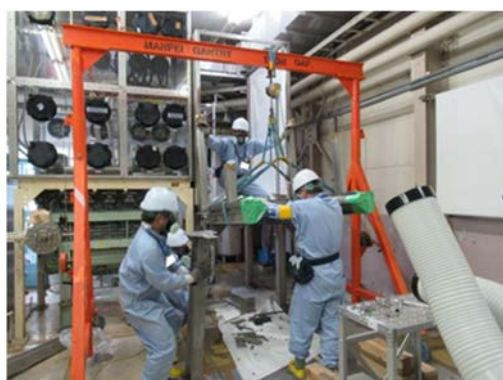
(5) H-24 フード（コールド）の撤去
