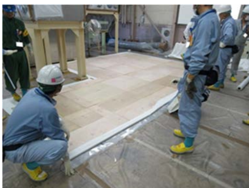
(3) GH 床材（ベニヤ板）の設置
