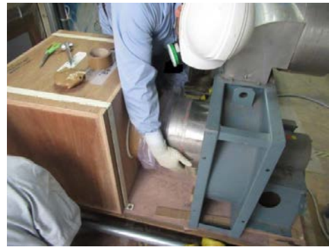
(2) 排気ダクトの撤去
