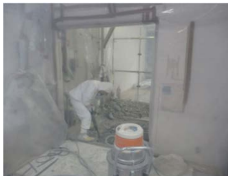
(2) コンクリートの除去作業②
