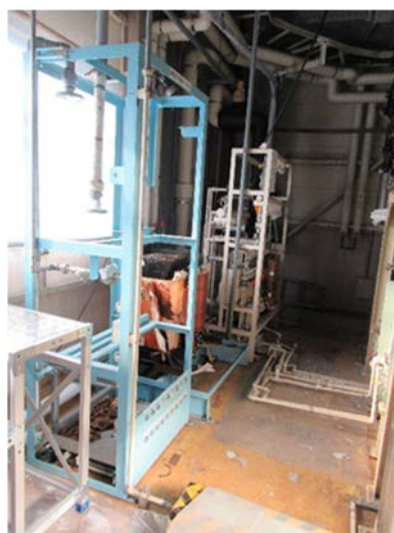
(6) 二次冷却水配管撤去後
