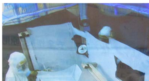
(8) H-20 の解体撤去②（フード背面）
