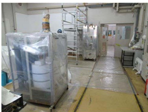
(3) 廃液処理設備の移動
