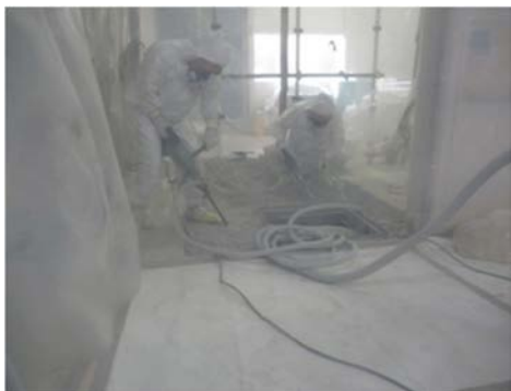
(1) コンクリートの除去作業①
