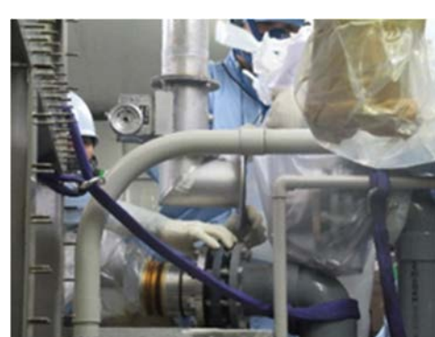
(4) 排気配管の切離し作業②
