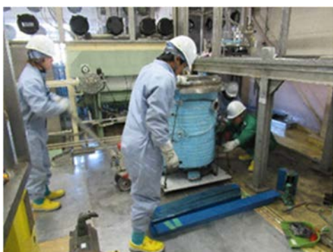
(3) 小型焼結炉の撤去作業②
