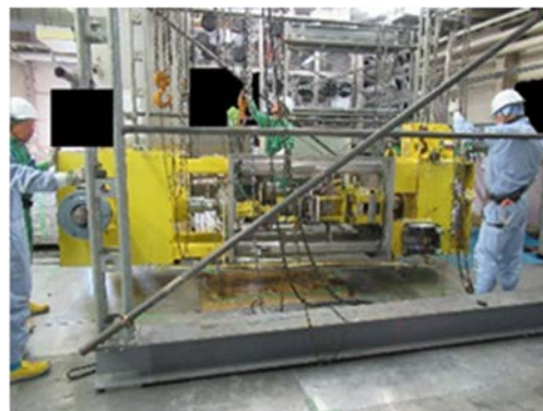
(4) 成型機の撤去作業②
