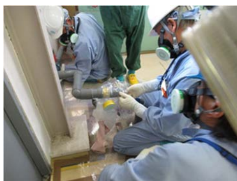
(6) 廃水系配管の分離
