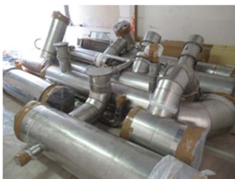
(5) 撤去した給気ダクト (例)
