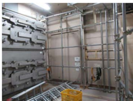
(2) GH 骨組みの設置② (R-5 室側)
