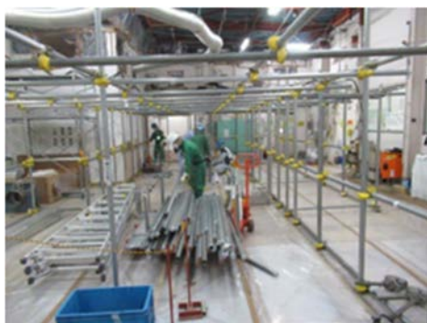
(1) GH 骨組みの設置① (R-6 室側)
