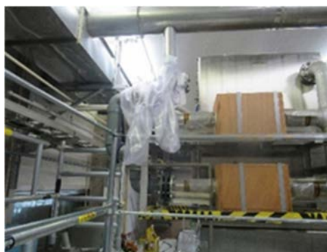
(2) 切離し部へのビニルバッグの装着
