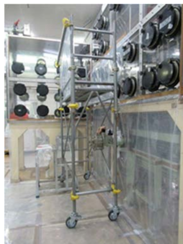
(2) GH 床材（酢ビシート）の設置
