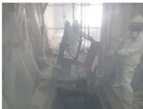
(3) 屋内ピットの吊り上げ作業
