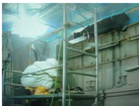
(6) フィルタユニットの解体②
