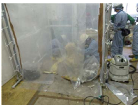
(5) 給気ダクトの切断作業①
