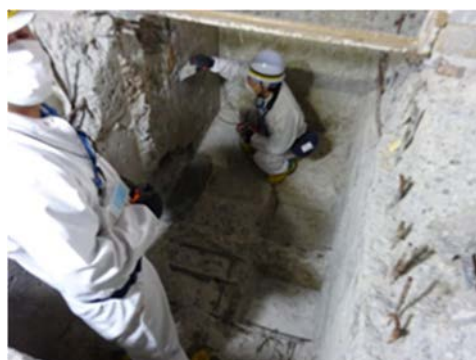
(6) ピット内の汚染検査
