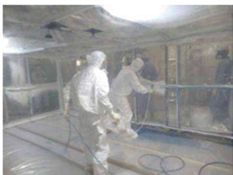
(5) 汚染飛散防止用ペイントの塗布
