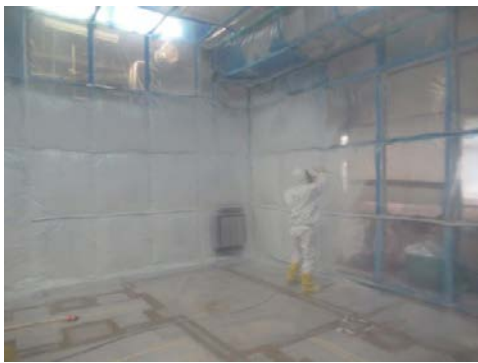
(3) GH 内汚染固定用ペイント吹付
