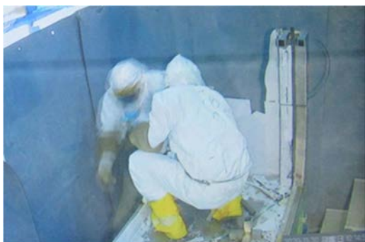
(1) H-20 の解体撤去③（フード側面）
