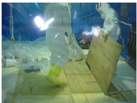
(3) 床材（ベニヤ板）の撤去
