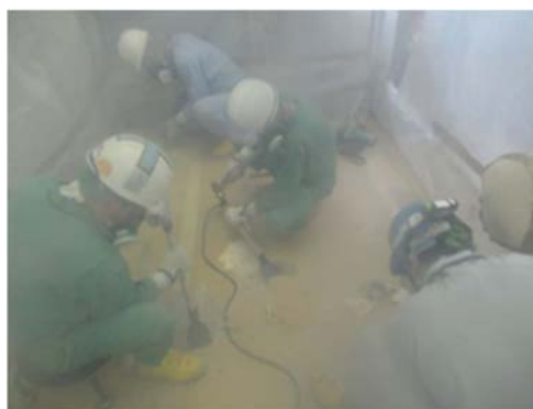
(4) 床の塗料等の除去作業①
