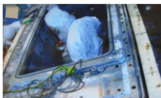
(4) H-24 の解体⑩ (電気炉本体)
