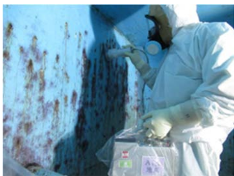
(3) 屋外排水受槽内部の汚染検査②
