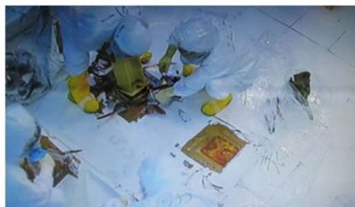
(2) H-24 の解体⑯ (フード架台)
