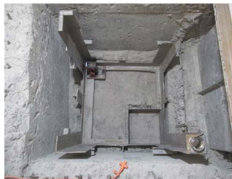
(2) 屋内ピットの切断作業③
