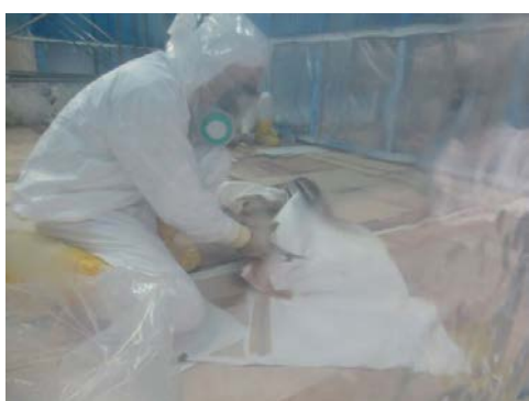
(5) 床材（ターポリンシート）の撤去②
