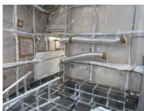
(6) GH 排気ダクトの取り付け④ (R-6 室側)
