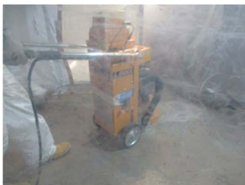
(5) 床の塗料等の除去作業②
