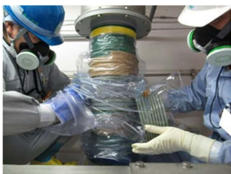
(5) 排気ダクト分離作業
