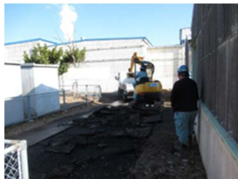
(2) 屋外埋設配管の掘り出し作業②
