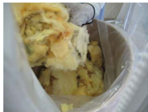
(6) 給気ダクトの切断作業②
