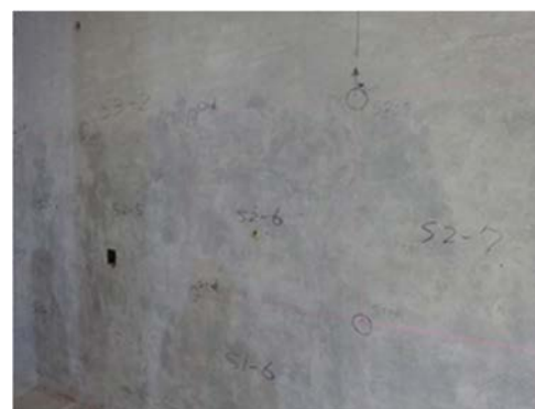
(4) 壁の汚染検査①
