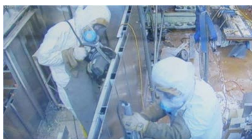
(7) H-24 の解体⑬ (フード缶体)
