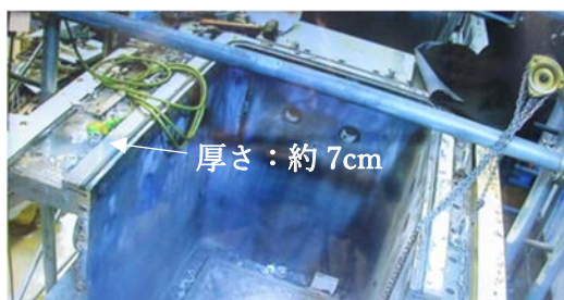
(5) H-24 の解体⑪ (電気炉本体)
