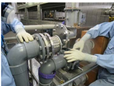
(5) 閉止用フランジの取付
