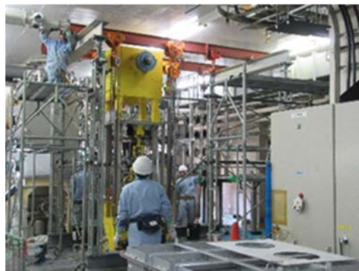
(2) 撤去前の準備作業
