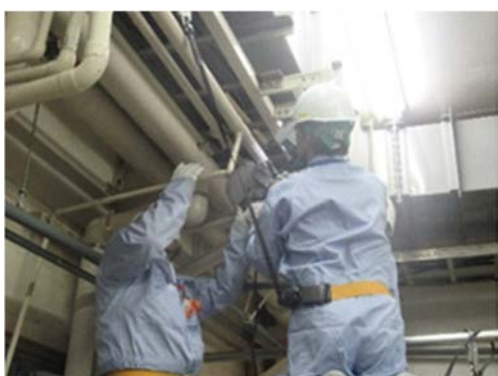
(5) ユーティリティ配管の切断作業
