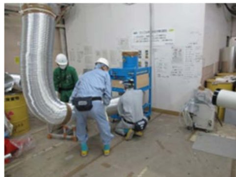
(2) 仮設排気装置の設置②
