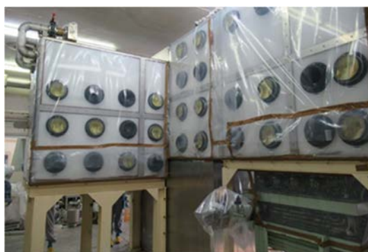
(6) フードの養生
