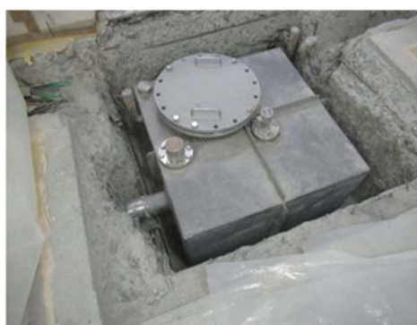
(4) コンクリート除去作業④
