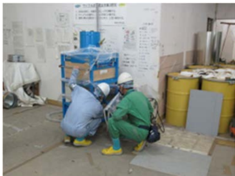
(1) 仮設排気装置の設置①
