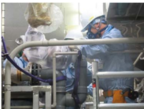
(3) 排気配管の切離し作業①
