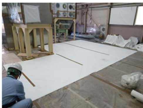
(4) GH 床材（ターポリンシート）の設置
