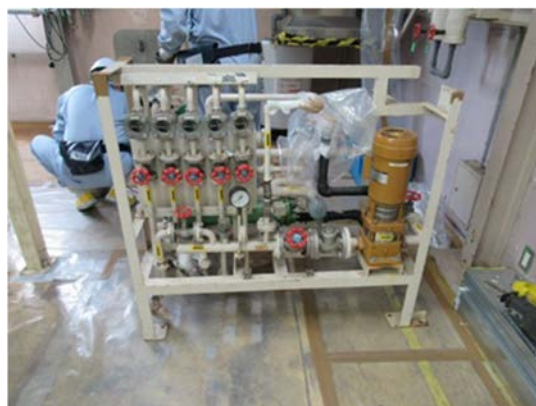
(2) 取り外した冷却水ユニット
