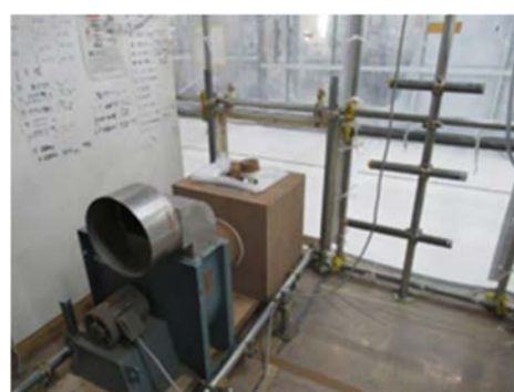
(4) GH 排気ダクトの取り付け②
