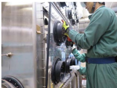
(1) アクリルパネル取外し作業
