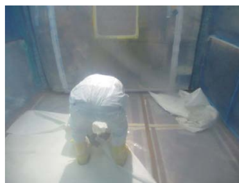
(4) 床材（ターポリンシート）の撤去①
