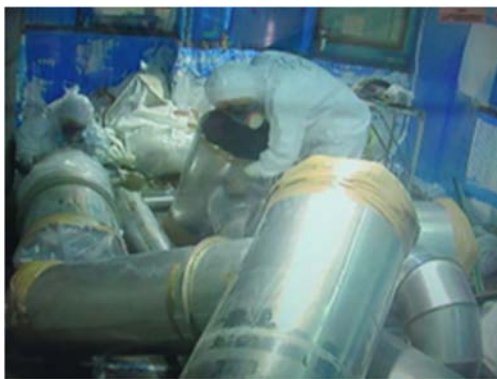
(3) 配管類の細断作業③
