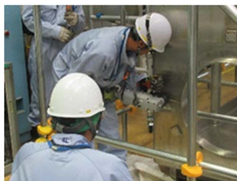
(4) 缶体の切断作業②
