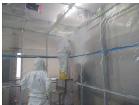
(3) GH 内汚染固定用ペイント固定
