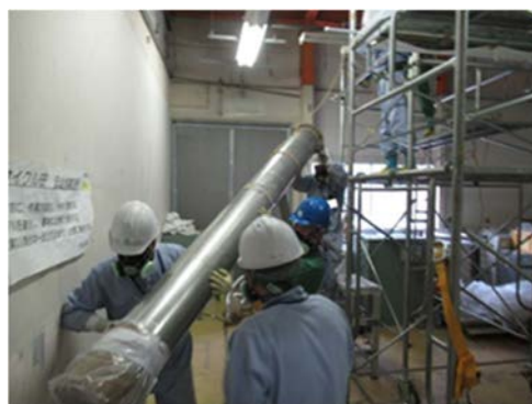
(4) 給気ダクトの撤去作業④
