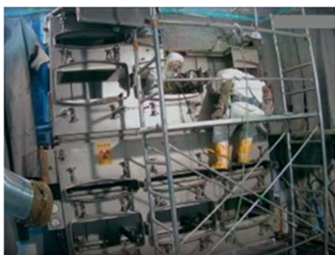
(5) フィルタユニットの解体①
