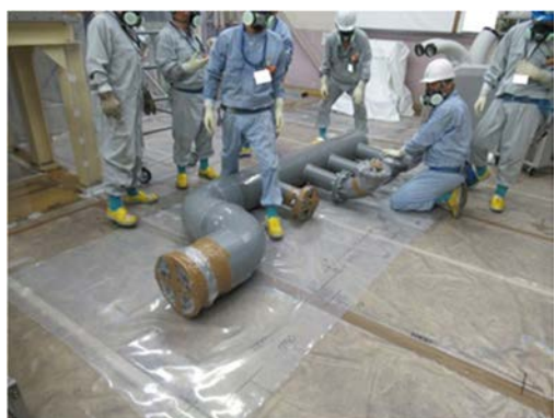
(3) 排気ダクト撤去
