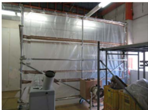
(1) 壁の塗料等の除去作業①
