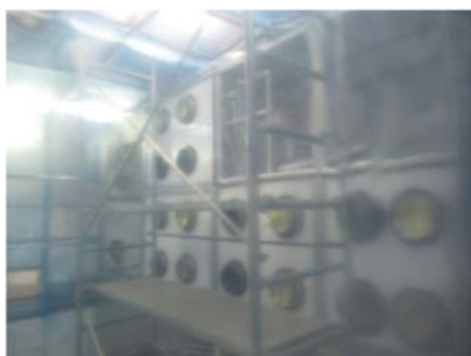
(3) H-24 の解体①（足場設置）
