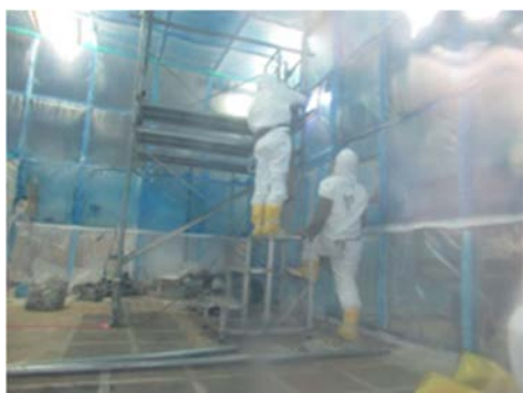
(1) GH 内足場の撤去①
