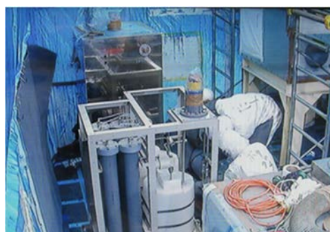
(4) 廃液処理設備の解体①
