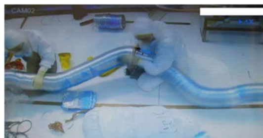
(6) 排気用蛇腹管の撤去
