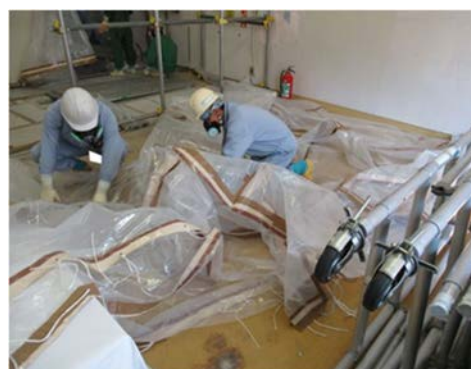
(6) 簡易 GH の撤去作業
