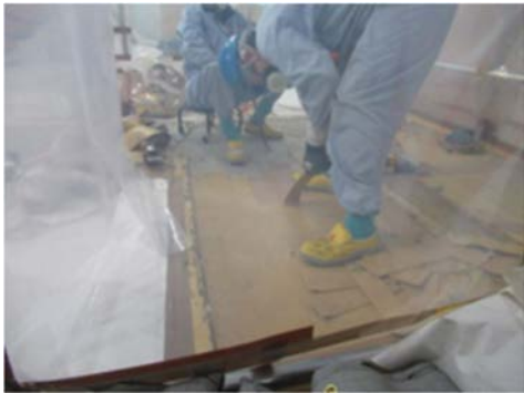
(1) 埋設配管の撤去作業①
