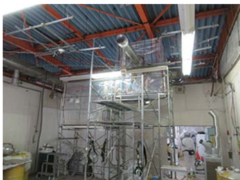
(1) 排気ダクトの撤去作業①
