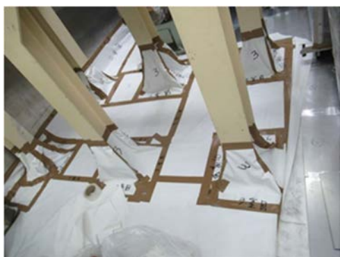
(2) H-24 架台部分の養生
