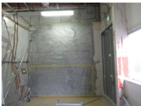
(3) 壁の塗料等の除去作業③
