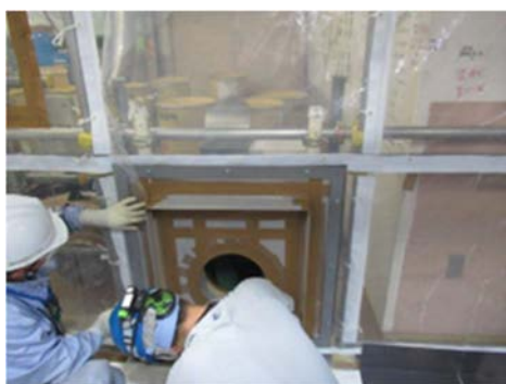
(3) GH 排気ダクトの取り付け①
