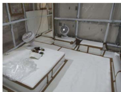
(6) GH 床材 (ターポリンシート 1 重目) の設置
