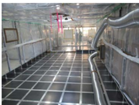
(5) GH 排気ダクトの取り付け③ (R-5 室側)
