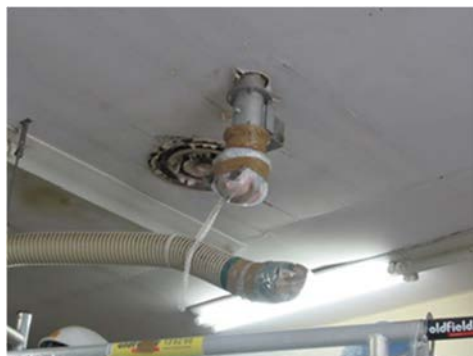
(2) H-8 排気ダクトの切離し
