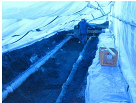
(2) 塩ビ配管の切断②
