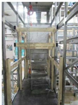
(2) 筐体の切断・撤去
