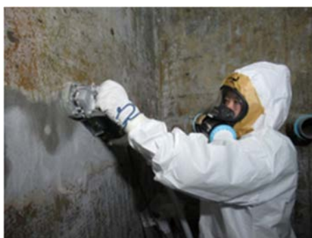
(5) 壁面のハツリ作業⑤
