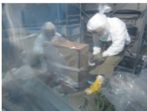
(3) HEPA フィルタの梱包作業
