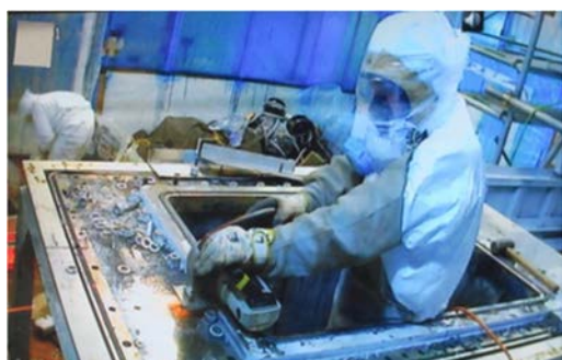
(3) H-24 の解体⑨ (電気炉本体)
