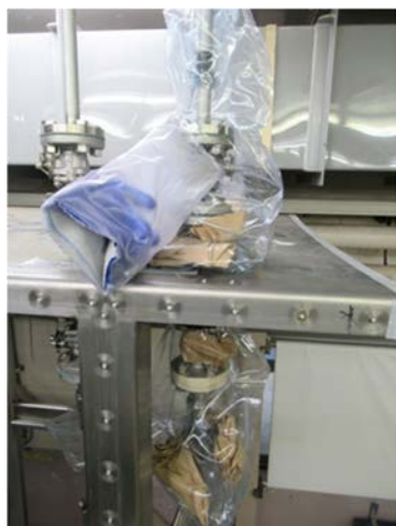
(1) 一次冷却水配管の取外し
