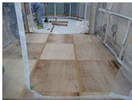
(2) GH 床材（ベニヤ板）の設置
