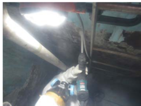
(4) 壁面のハツリ作業④
