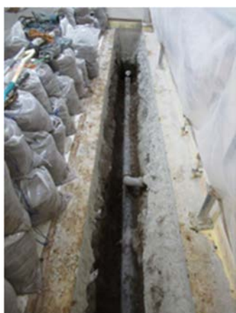
(5) 埋設配管の撤去作業③
