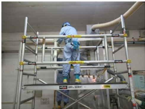
(1) 排気ダクトの養生①
