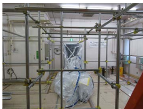
(4) GH 骨組みの設置
