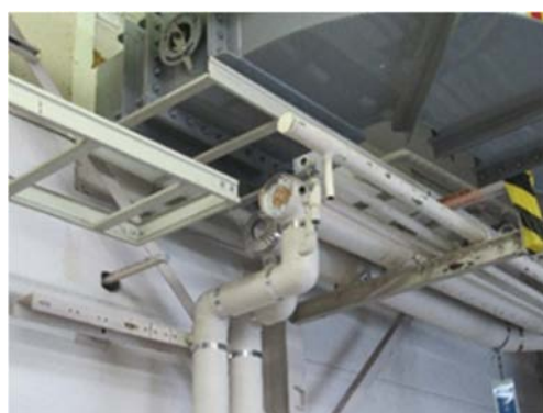
(6) ユーティリティ配管の切断後
