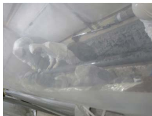
(6) 埋設配管の撤去作業④
