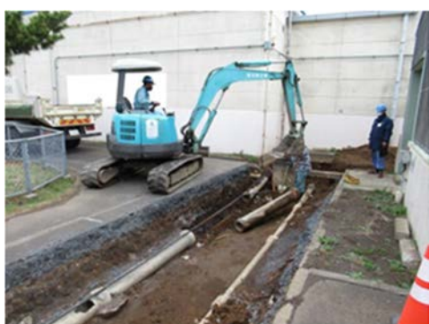
(5) 二重配管（二重目）の撤去①
