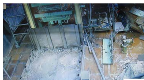
(8) H-24 の解体⑭ (フード缶体)
