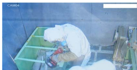
(6) H-19 の解体撤去⑥（フード架台）
