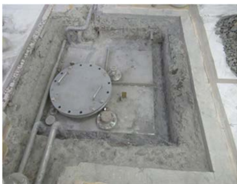
(3) コンクリート除去作業③
