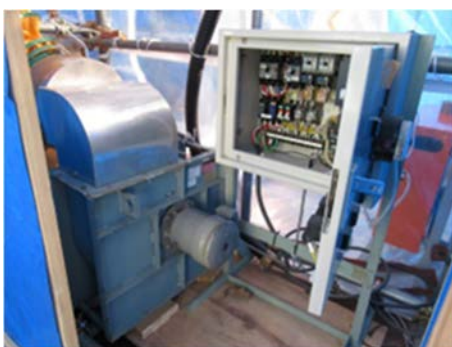
(6) 簡易 GH の設置⑥ (排気設備の設置)
