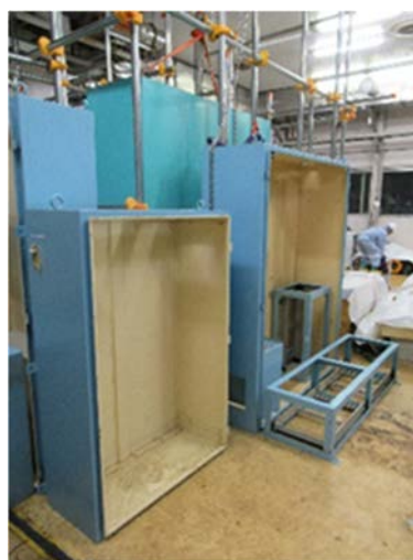
(4) 解体撤去作業②
