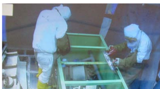
(5) H-19 の解体撤去⑤（フード架台）
