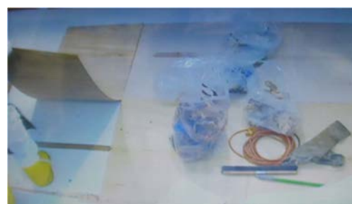
(4) 床材（ベニヤ板）の撤去①
