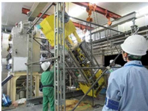
(3) 成型機の撤去作業①
