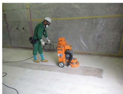
(6) 床の塗料等の除去作業③
