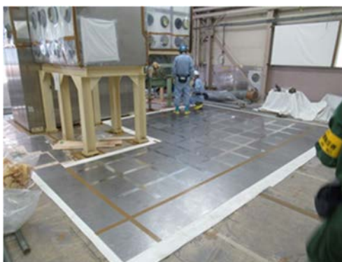
(5) GH 床材（鋼板）の設置
