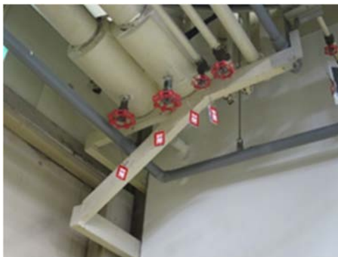
(4) ユーティリティ配管の閉止措置
