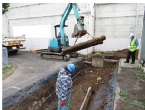
(6) 二重配管（二重目）の撤去②
