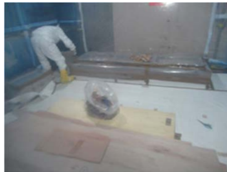
(2) 床材（ターポリンシート二重目） の撤去
