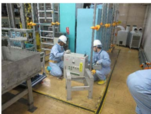
(3) 解体撤去作業①
