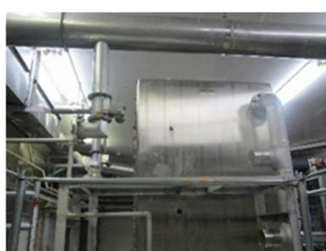
(6) 排気配管撤去後
