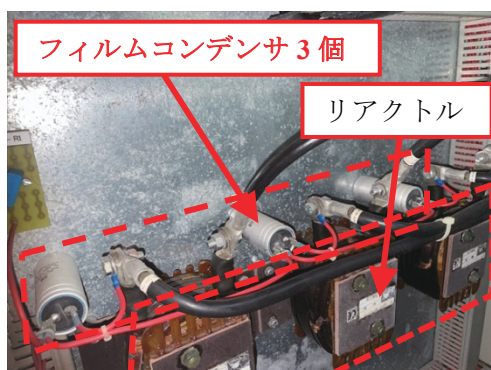
図 34 : LC フィルター回路
