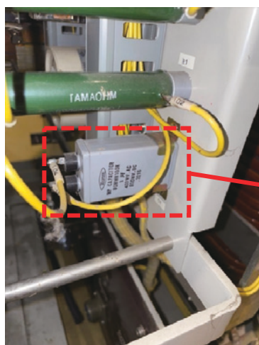
図 57 : RC フィルター回路
