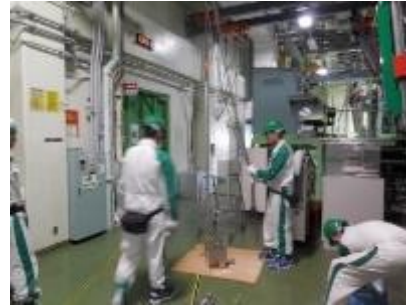
セル外での遠隔操作性の確認
