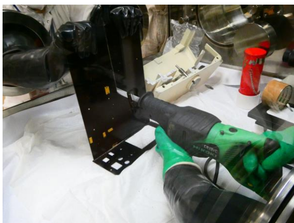
既存設備の解体作業
