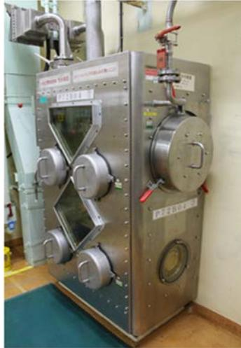
Photo 1.1 スラッジの保管場所に使用しているグローブボックス外観図
