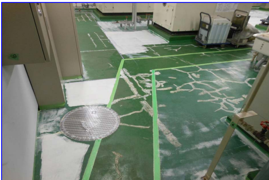
Fig. 1.5.2 機械室床の樹脂モルタル補修の状況
