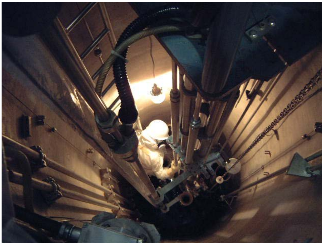
炉心タンク内作業
