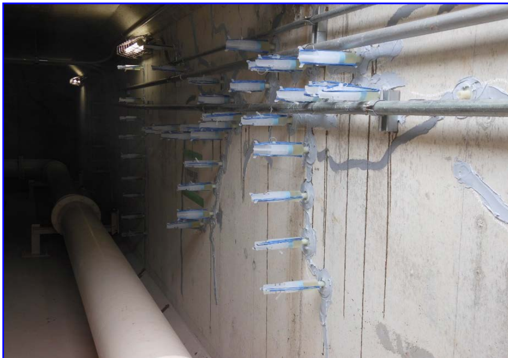
Fig. 1.5.3 共同溝 B のエポキシ注入の状況
