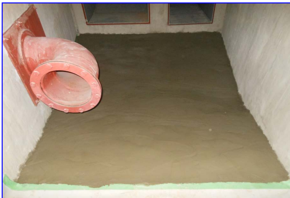
Fig. 1.5.4 排気風洞の樹脂モルタル補修の状況
