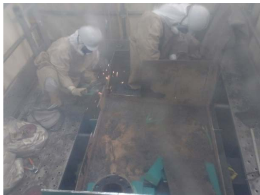
反応槽解体撤去 (1) (簡易ハウスV作業エリア)
