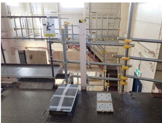
原液フィルタ及び空気加熱器撤去後
