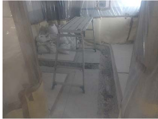
埋設配管撤去後 (埋め戻し前)
