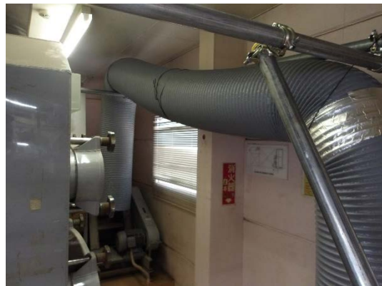
二次側 (排気) ダクトの設置 (1) (排気機械場)
