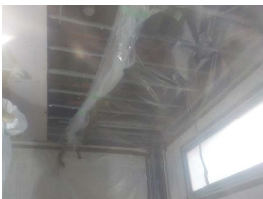
天井板撤去後養生 (簡易ハウス内)
