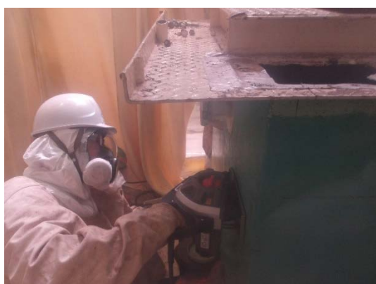
汚泥槽切断撤去（1） （簡易ハウスⅢ作業エリア）
