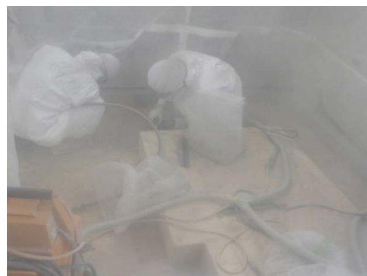
薬注作業場床面研削 (簡易ハウス内)
