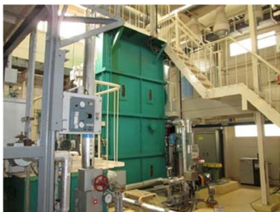
反応槽撤去前
