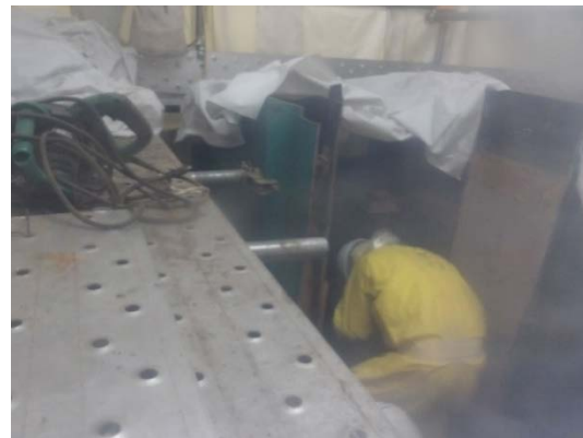
反応槽内スラッジの回収 (簡易ハウスV作業エリア)
