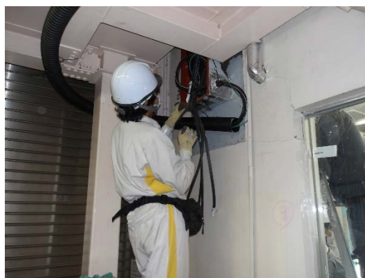
非管理区域からの電線回収
