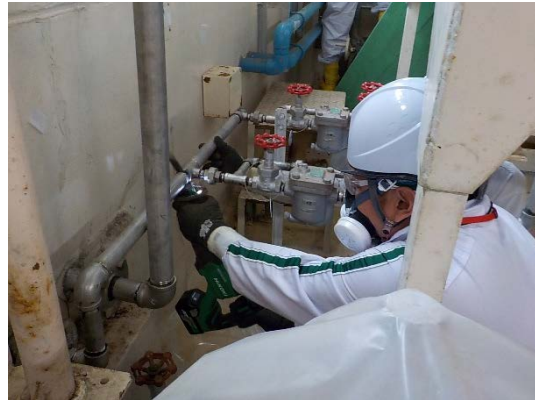
乾燥機付属配管の切断撤去
