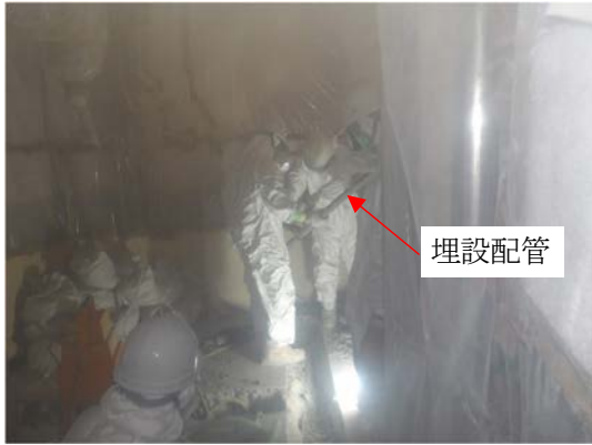
埋設配管の撤去
