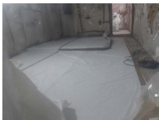
乾燥機室床面養生後 (簡易ハウス内)
