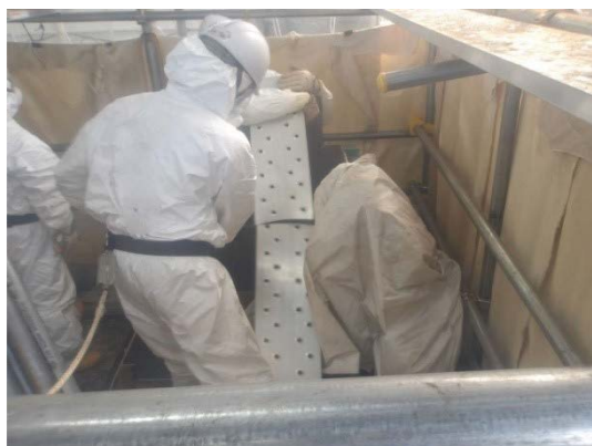
足場の撤去 (簡易ハウスV作業エリア)
