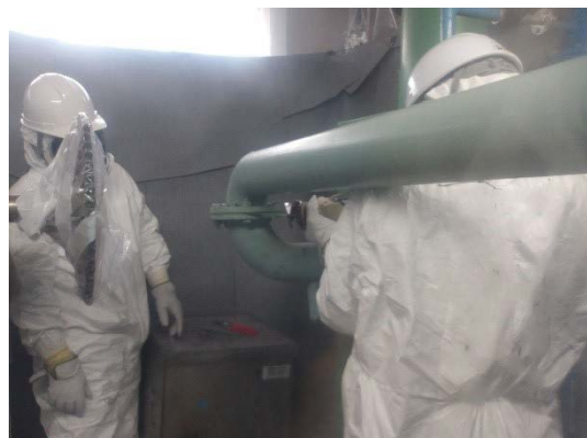
乾燥機付属配管の切断撤去 (1) (簡易ハウスⅡ作業エリア)
