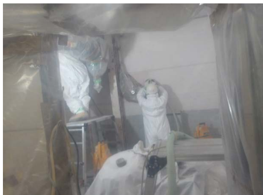
分析室壁面研削 (簡易ハウス内)
