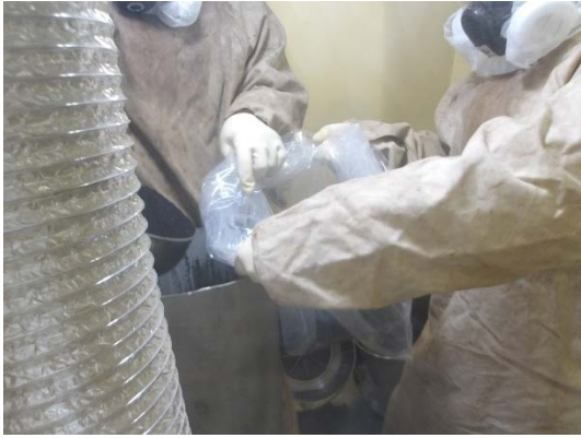
吸着塔内スラッジの回収 (簡易ハウスⅣ作業エリア)
