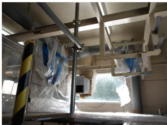
排気ダクトビニルバッグの取付け
