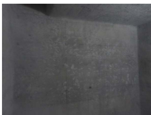
ライニング及び防水モルタル撤去後 (地下ピット内)
