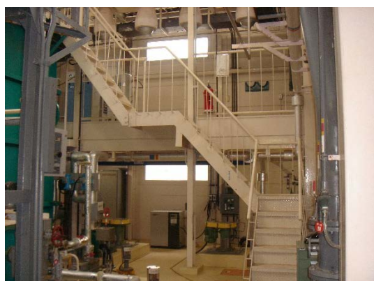
薬注作業場機器類撤去前
