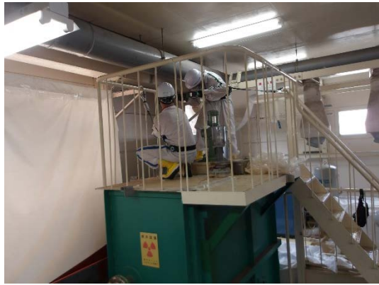
反応槽上部手摺撤去
