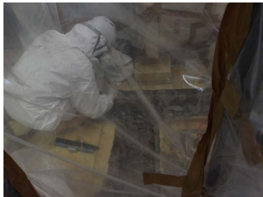
排水トレンチ防水モルタル撤去 (2) (簡易ハウス内)
