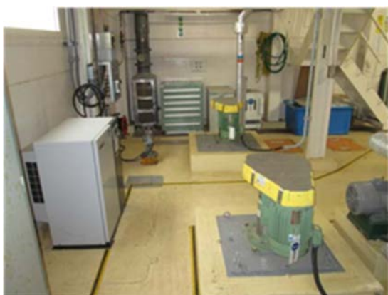
原水槽攪拌機及びコンプレッサ撤去前
