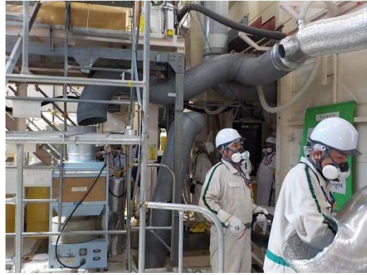
仮設排気装置及びダクトの設置 (廃水処理室 (部屋))
