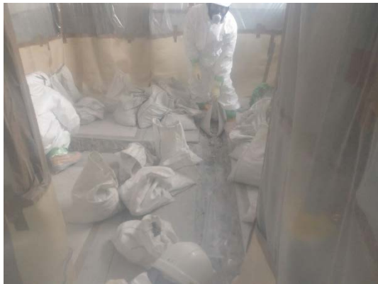
掘削箇所の埋め戻し (コンクリートガラの埋め戻し)
