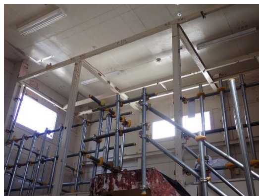
給気ダクト及び電線ラック撤去後 (薬注作業場)
