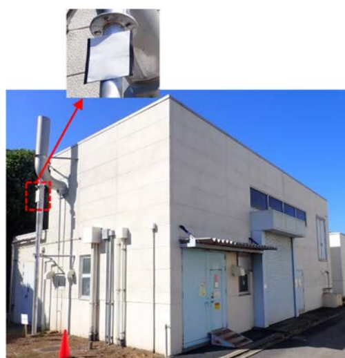
廃水処理室外観（作業後）
