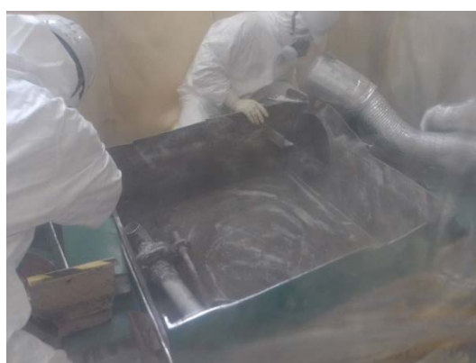
汚泥槽内スラッジの拭き取り （簡易ハウスⅢ作業エリア）
