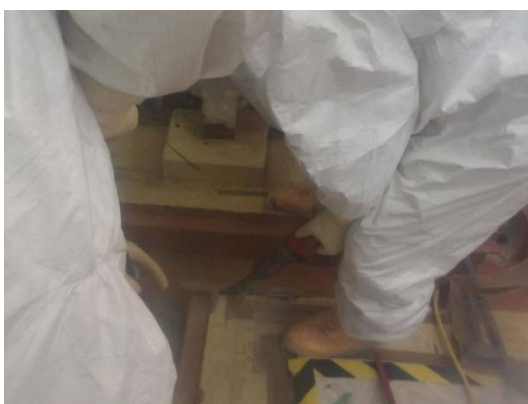
排水トレンチアングル撤去 (簡易ハウス内)
