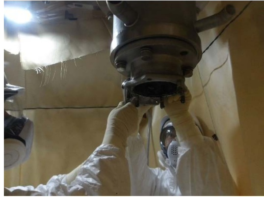
吸着塔切断撤去 (2) (簡易ハウスⅣ作業エリア)
