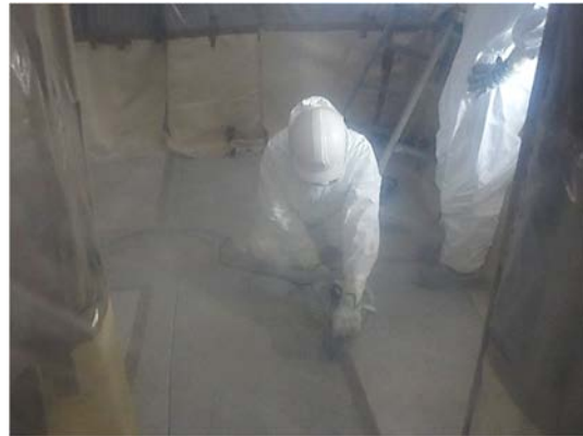
床面の掘削作業 (1) (コンクリートカッターによる切り込み)
