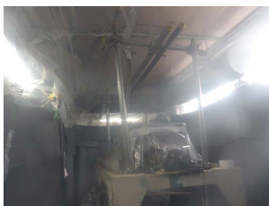
乾燥機本体の解体用門型枠 (簡易ハウスⅡ作業エリア)
