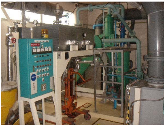
乾燥機撤去前
