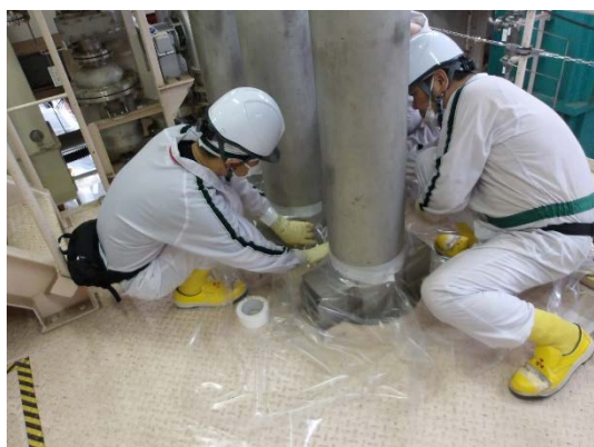
薬注作業場床面養生
