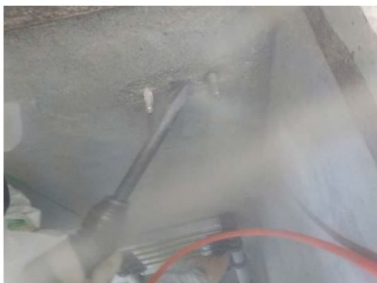
アンカーボルトの撤去 (地下ピット内)
