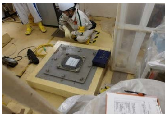
攪拌機撤去後
