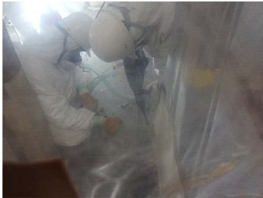
床面の掘削作業 (2) (ブレードによる掘削)
