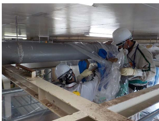
排気ダクトの切断 (2) (ビニルバッグ)
