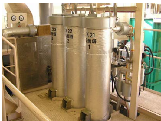
吸着塔撤去前 (2階)
