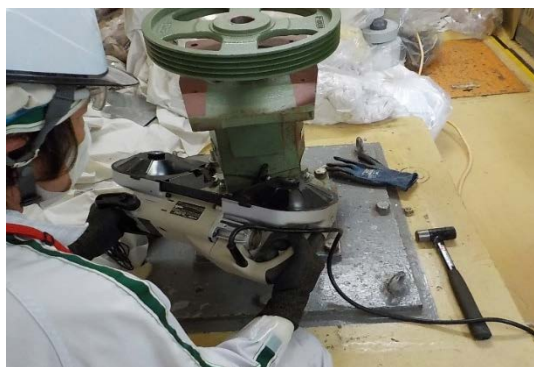
攪拌機の切断撤去
