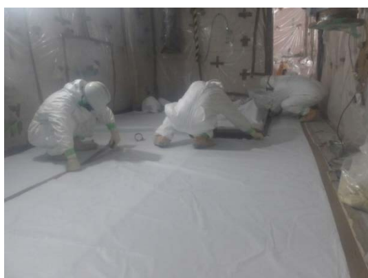
乾燥機室床面養生 (2) (簡易ハウス内)
