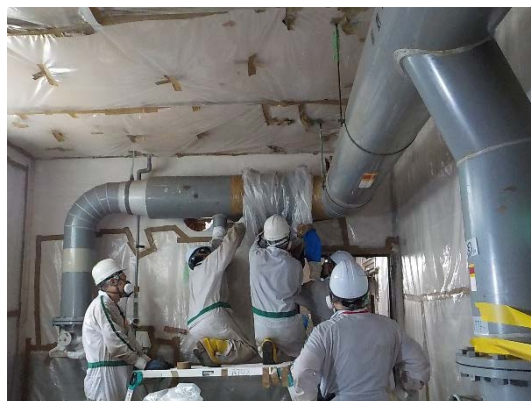
排気ダクトの切断 (1) (ビニルバッグ)
