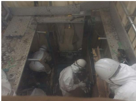
反応槽解体撤去 (2) (簡易ハウスV作業エリア)
