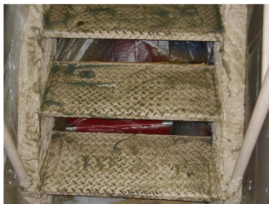
剥離剤の塗布後（時間経過後）
