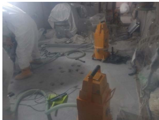
乾燥機室床面アンカーボルト撤去 (簡易ハウス内)
