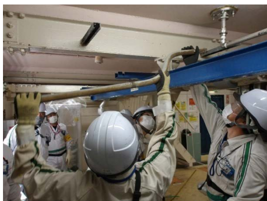
電線管の撤去
