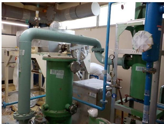
乾燥機付属配管・機器撤去後
