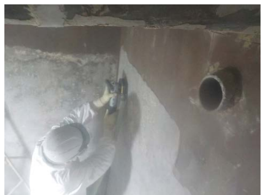
防水モルタルの研削作業 (2) (地下ピット内)
