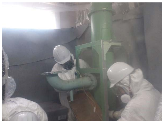
乾燥機付属配管の切断撤去 (2) (簡易ハウスⅡ作業エリア)
