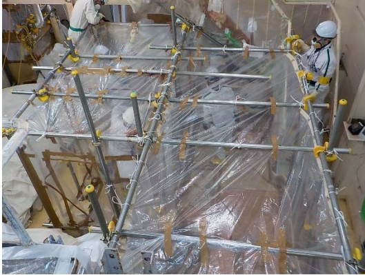
簡易ハウスVIの設置
