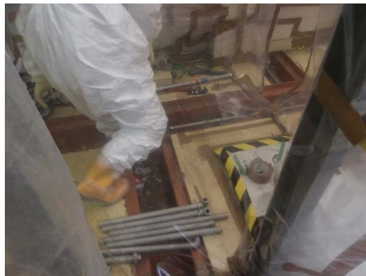
排水トレンチ内配管撤去 (簡易ハウス内)
