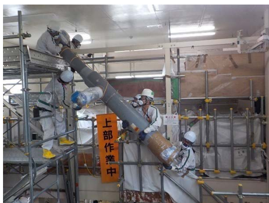
排気ダクトの撤去
