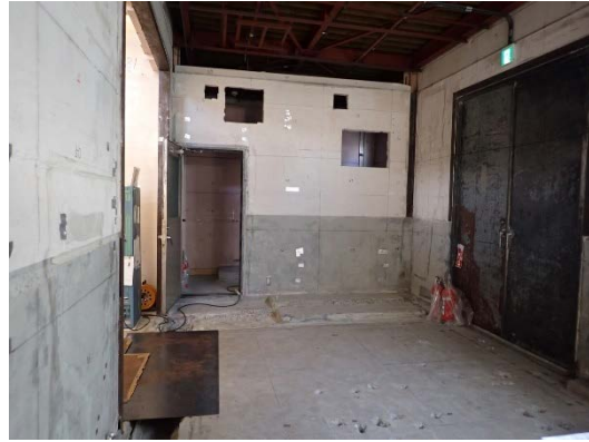
乾燥機室機器類撤去後
