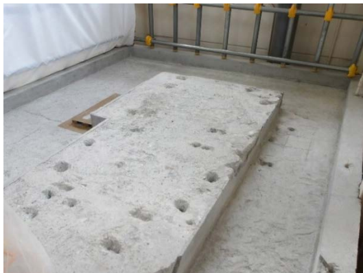
薬注作業場床面研削後
