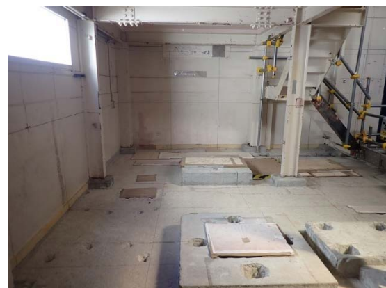
原水槽攪拌機及びコンプレッサ撤去後
