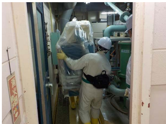
撤去設備機器の移動（乾燥機室へ）
