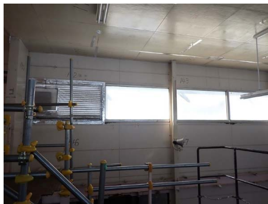
給気ダクト及び排気ダクト撤去後 (2階)
