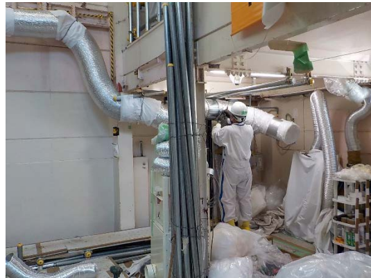
一次側 (吸入) ダクトの設置 (2) (廃水処理室 (部屋))
