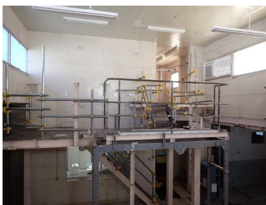
作業架台機器類撤去後
