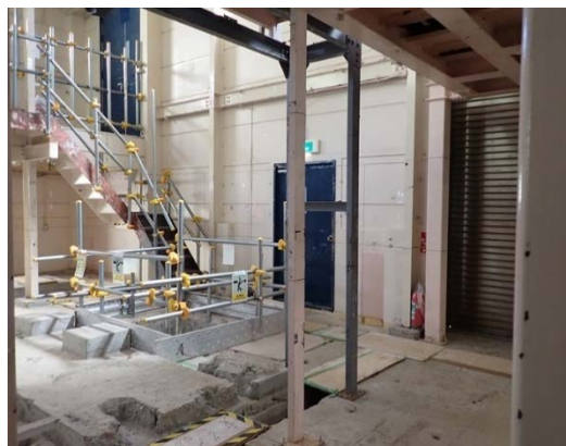
洗浄液受槽及び拔出パネルハウス撤去後
