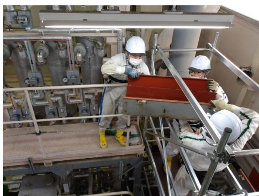
ケーブルラックの撤去
