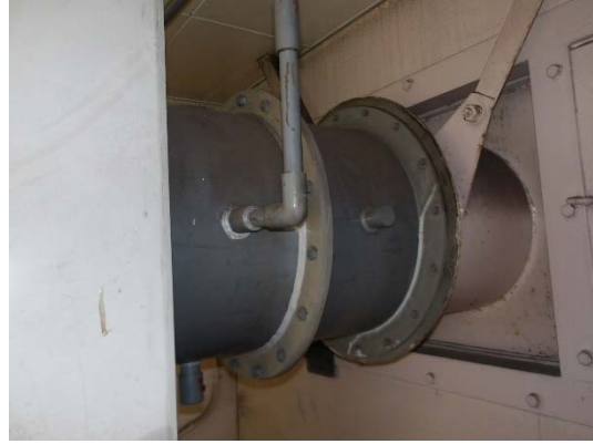
排気筒と既設排気設備の接続部 （排気機械場）
