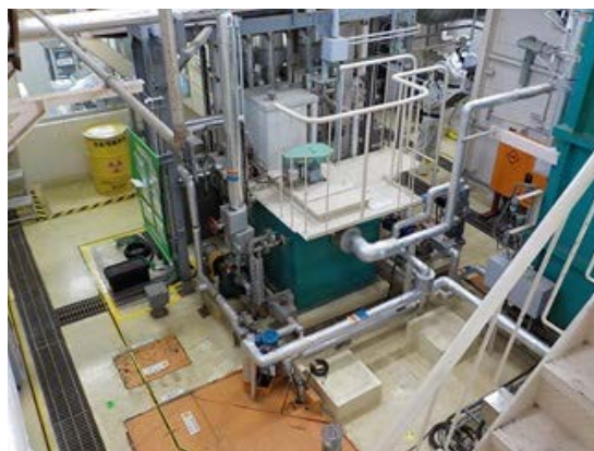
汚泥槽撤去前
