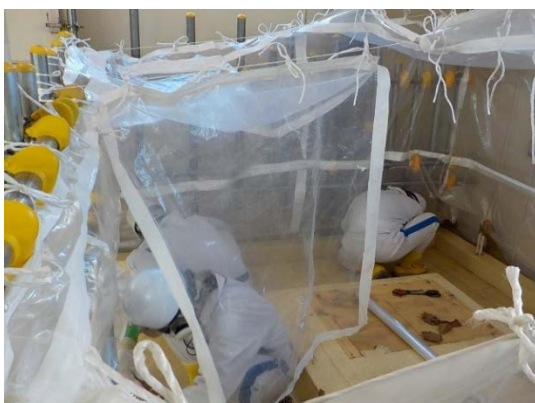
薬注作業場簡易ハウス設置
