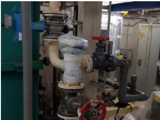
配管切断後の措置（1）
