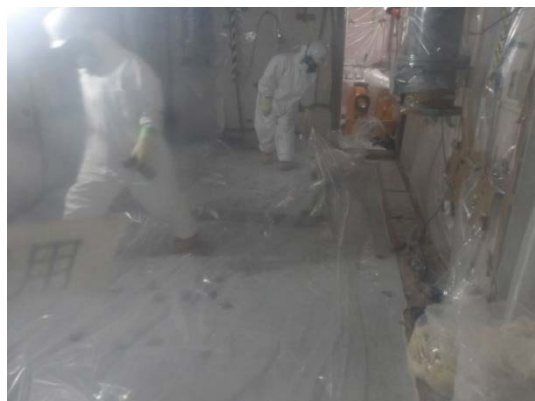
乾燥機室床面養生 (1) (簡易ハウス内)
