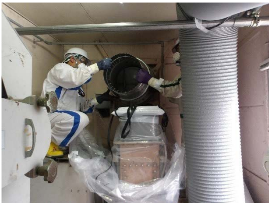
排気筒へのアダプタの取付け（2） （排気機械場）
