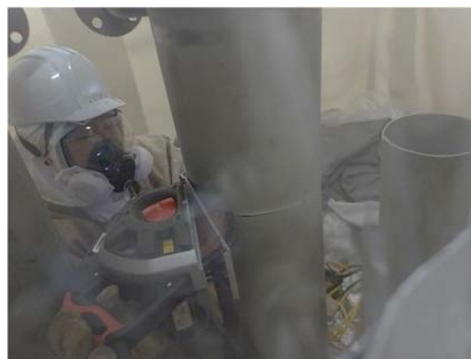
吸着塔切断撤去 (簡易ハウスIV作業エリア)
