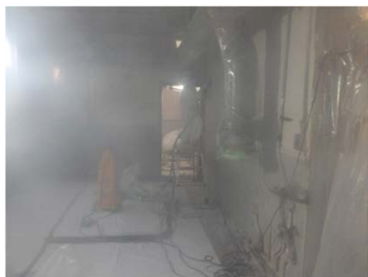
乾燥機室壁面研削 (簡易ハウス内)
