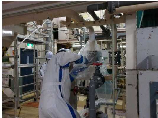
配管の切断（ビニルバッグ）
