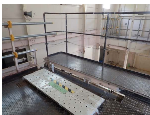
吸着塔撤去後 (2階)
