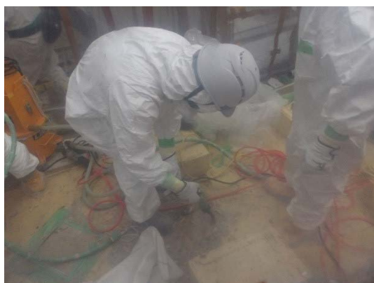
廃水処理室（部屋）床面はつり （簡易ハウス内）
