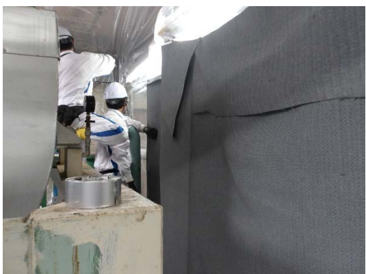
簡易ハウス壁面火気養生
