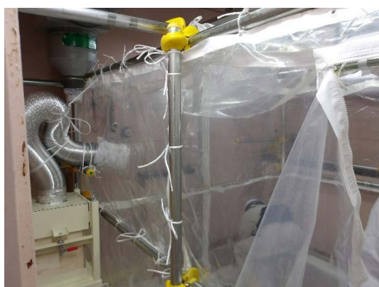
簡易ハウス I の設置
