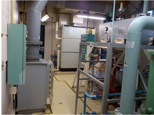
乾燥機室機器類撤去前
