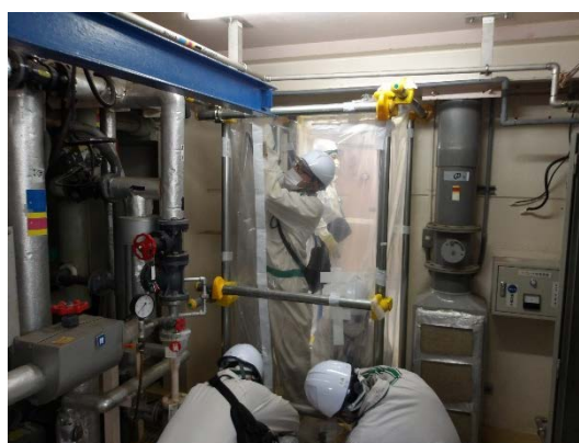
簡易ハウス I の設置
