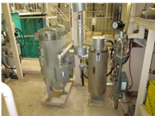
原液フィルタ及び空気加熱器撤去前
