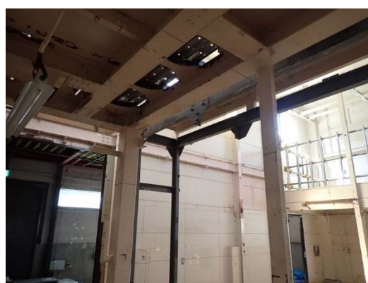
吸着塔撤去後 (1階)
