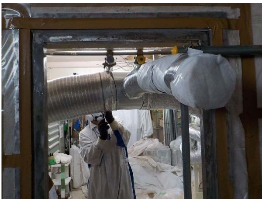
一次側 (吸入) ダクトの設置 (3) (分析室)
