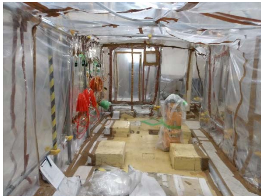
廃水処理室（部屋）床面 研削用簡易ハウス
