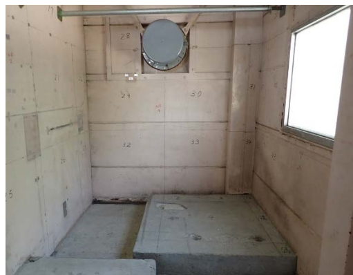
排気機械場撤去後
