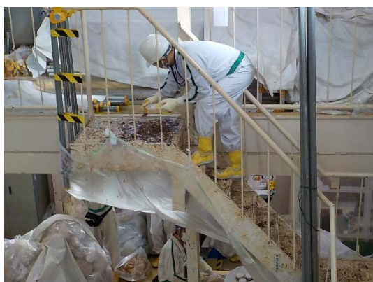
塗膜剥離作業（1） （スクレーパ）
