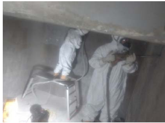
防水モルタルのはつり作業 (地下ピット内)
