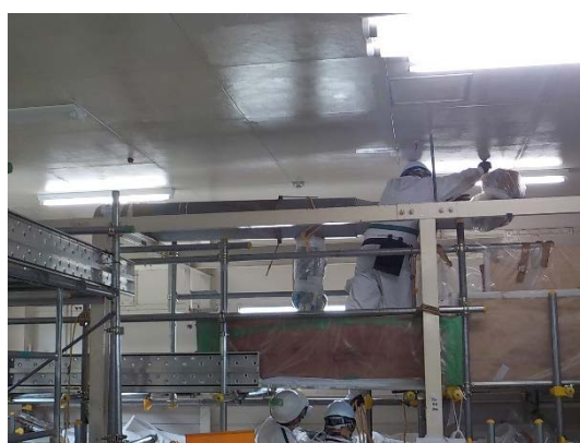
排気ダクト開口部の養生
