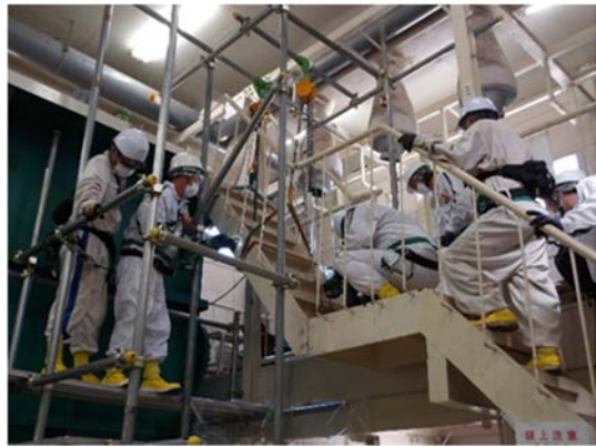
反応槽階段撤去 (1)
