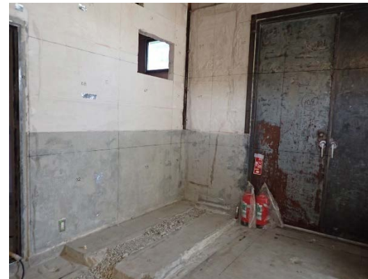
空調機撤去後
