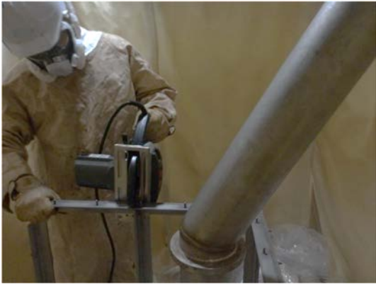
抜出パネルハウス切断撤去 (簡易ハウスⅣ作業エリア)
