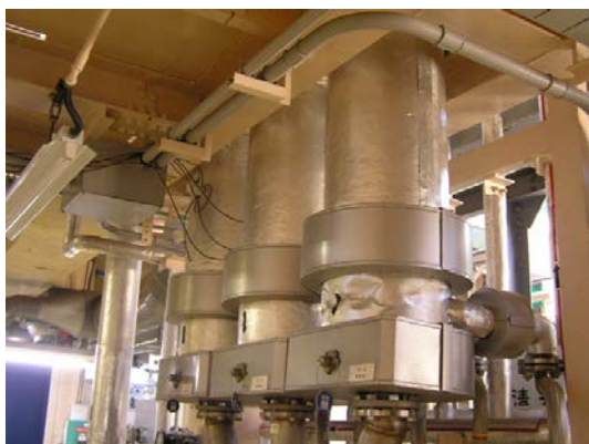
吸着塔撤去前 (1階)
