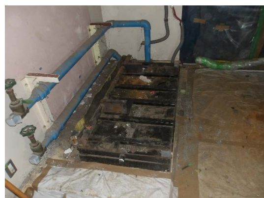
給気設備撤去後
