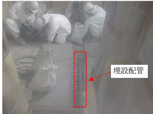
床面の掘削作業 (3) (掘削及びコンクリートガラの回収)
