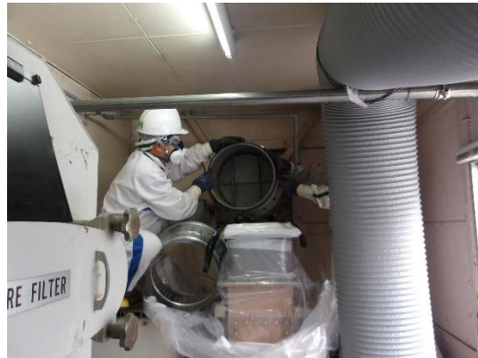
排気筒へのアダプタの取付け（1） （排気機械場）
