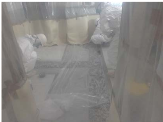
掘削箇所の養生作業 (酢ビシートによる養生)
