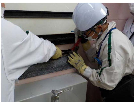
流し台上水配管の閉止
