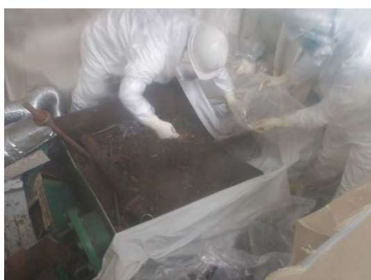
汚泥槽内スラッジの回収（1） （簡易ハウスⅢ作業エリア）
