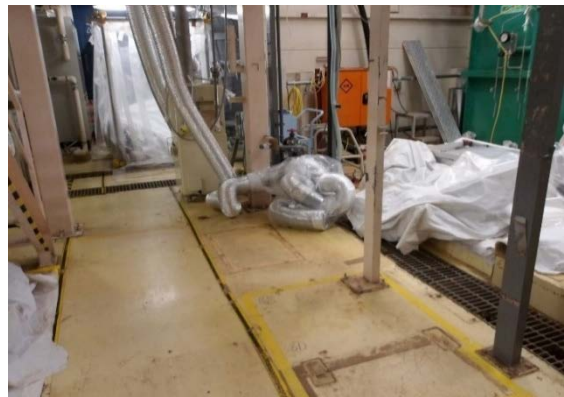
吸着塔撤去後 (1階)
