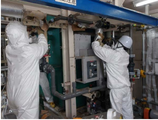
断熱材の撤去
