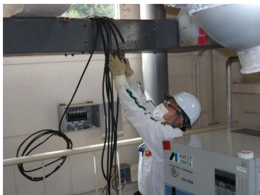
ケーブルラックからの電気配線撤去
