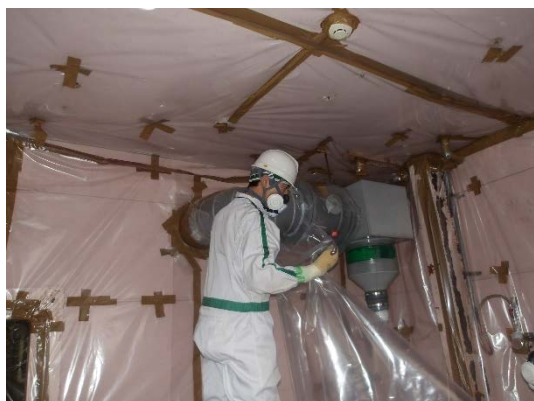
分析室簡易ハウス設置
