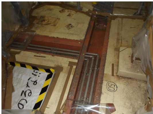
排水トレンチ撤去前
