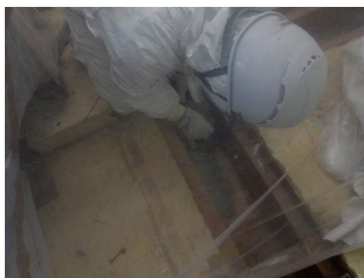
排水トレンチ防水塗膜撤去 (2) (簡易ハウス内)
