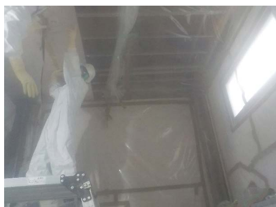
天井板撤去 (簡易ハウス内)
