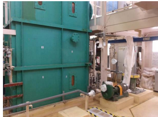
配管切断後の措置（2）
