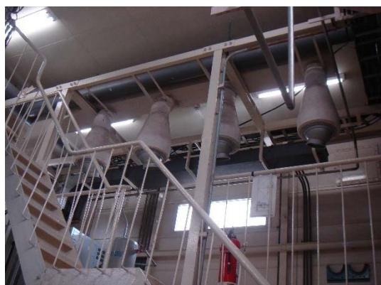
給気ダクト及び電線ラック撤去前 (薬注作業場)
