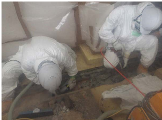
排水トレンチ防水モルタル撤去 (1) (簡易ハウス内)
