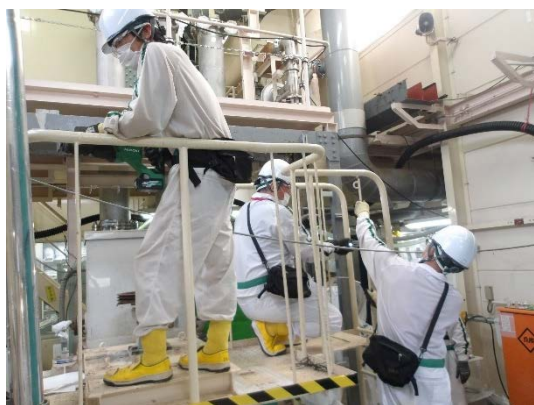
汚泥槽手摺の切断撤去
