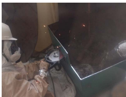
汚泥槽切断撤去（2） （簡易ハウスⅢ作業エリア）
