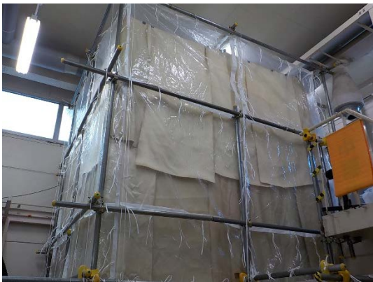
反応槽解体撤去用簡易ハウスの設置 (火気養生後)
