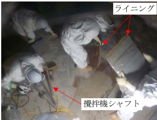
攪拌機シャフト及びライニングの撤去 (地下ピット内)
