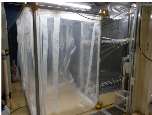
簡易ハウスⅡ外観
