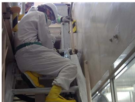
手摺の切断作業
