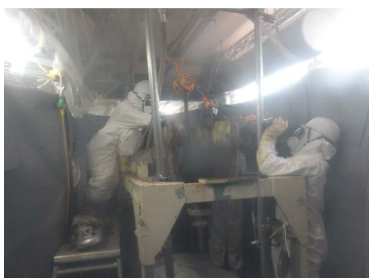
乾燥機主軸の解体撤去 (簡易ハウスⅡ作業エリア)
