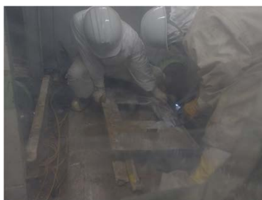
撤去物の減容化 (簡易ハウスⅡ作業エリア)
