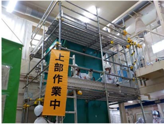
反応槽解体撤去用足場の設置
