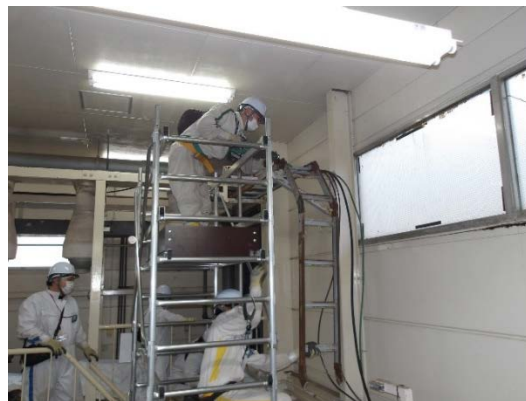
ケーブルラックからの電気配線撤去 (足場作業)
