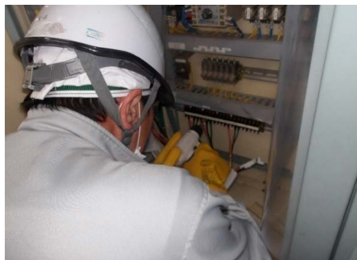
分電盤内の離線作業
