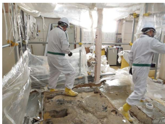
簡易ハウスV撤去
