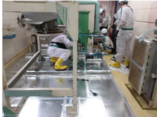
簡易ハウス床面火気養生
