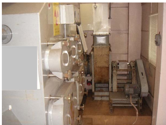
排気機械場撤去前
