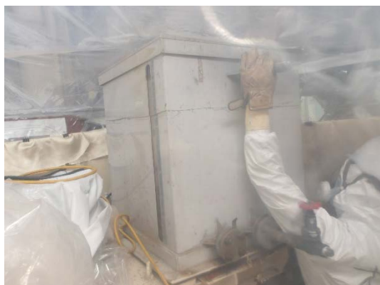
汚泥槽付属設備（清水槽）解体撤去 （簡易ハウスⅢ作業エリア）
