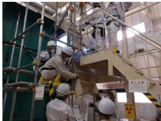
反応槽階段撤去 (3)
