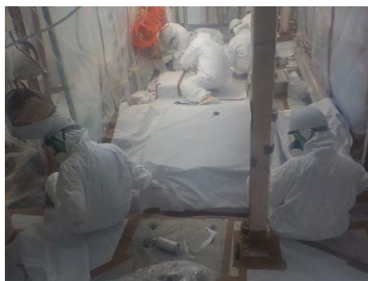
廃水処理室（部屋）床面養生 （簡易ハウス内）
