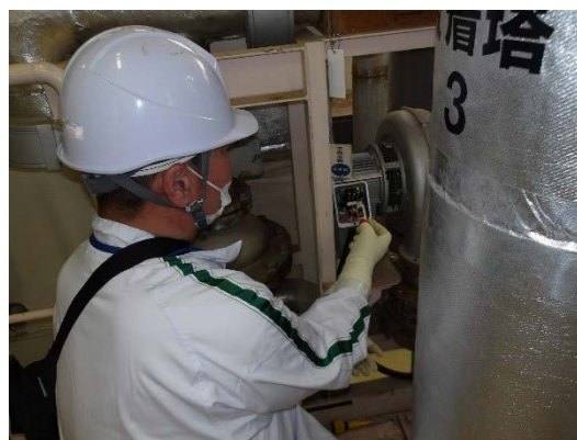
機器端子での無電圧確認
