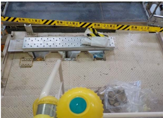
吸着塔撤去後 (2階)
