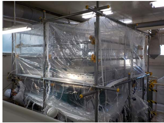
反応槽解体撤去用簡易ハウスの設置
