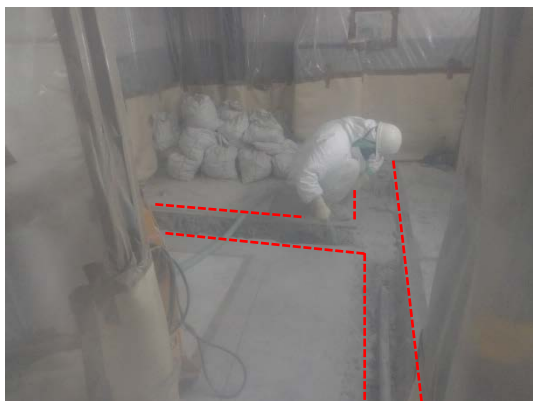
床面の掘削作業 (4) (埋設配管周囲の掘削)
