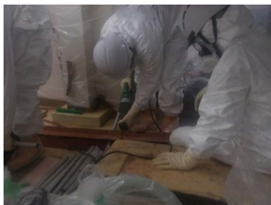
排水トレンチアングル切断 (簡易ハウス内)
