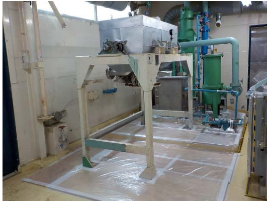
簡易ハウス床面養生
