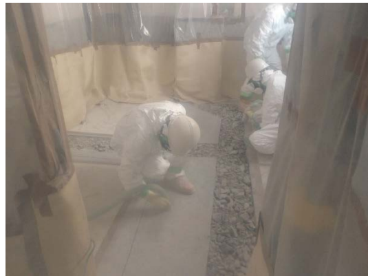
掘削箇所の埋め戻し後汚染検査
