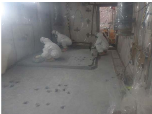
乾燥機室床面研削後汚染検査 (簡易ハウス内)
