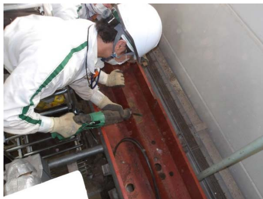
ケーブルラックの切断撤去作業
