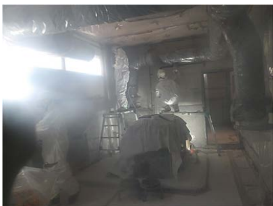
乾燥機室壁面養生 (簡易ハウス内)
