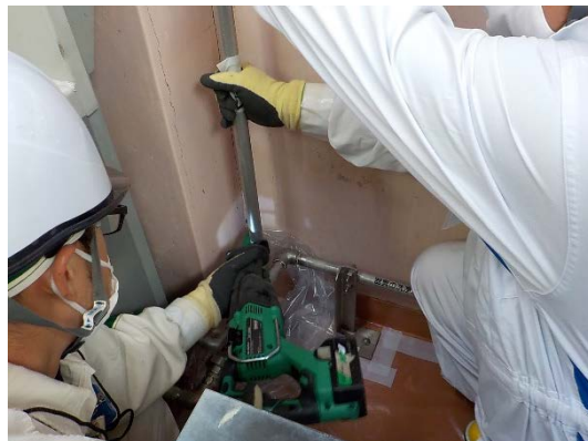
流し台上水配管の切断撤去
