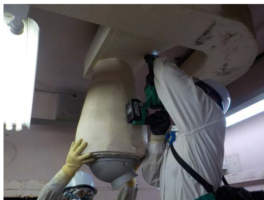
給気ダクトの一部撤去
