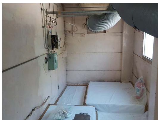
排気設備撤去後
