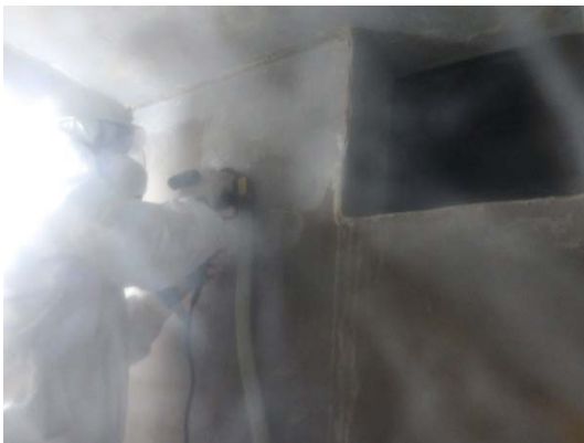
防水モルタルの研削作業 (1) (地下ピット内)
