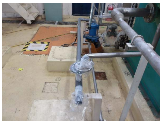
配管切断の措置 (簡易フード)
