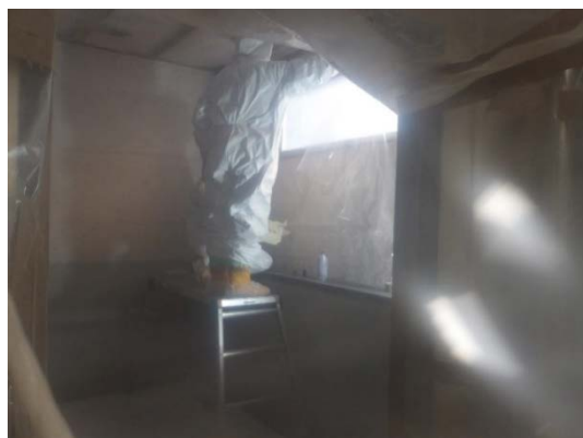
分析室壁面養生 (簡易ハウス内)
