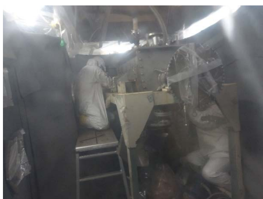
乾燥機本体の解体撤去 (2) (簡易ハウスⅡ作業エリア)
