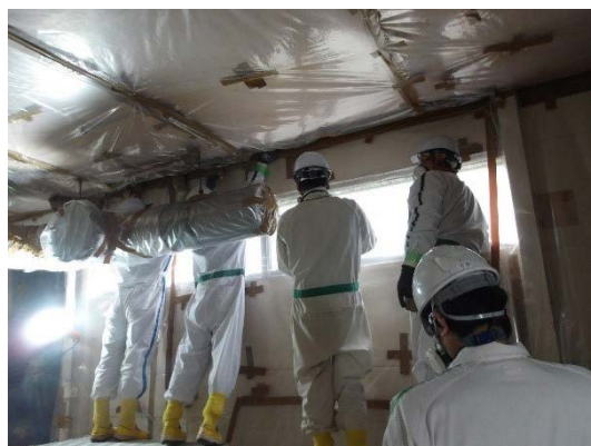
乾燥機室簡易ハウス設置
