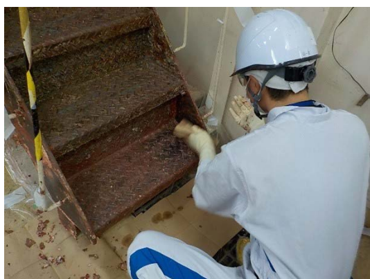
剥離剤の拭き取り
