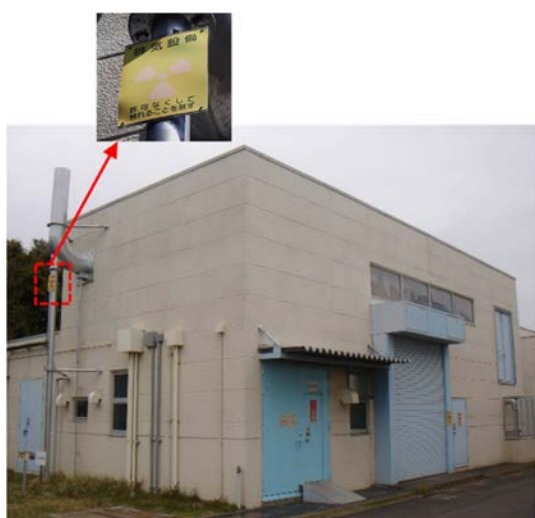
廃水処理室外観（作業前）
