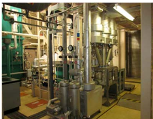
洗浄液受槽及び拔出パネルハウス撤去前
