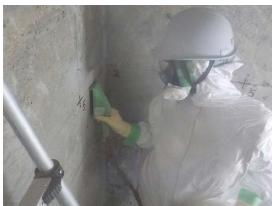
撤去後の汚染検査 (2) (地下ピット内)
