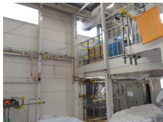
反応槽撤去後
