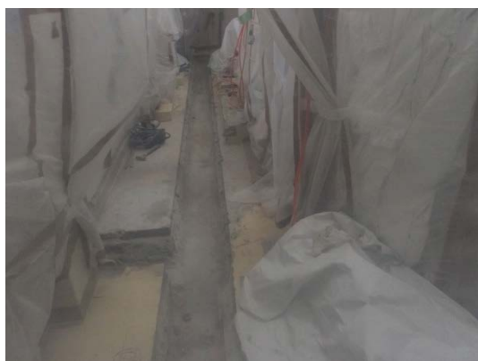
排水トレンチ撤去後 (簡易ハウス内)
