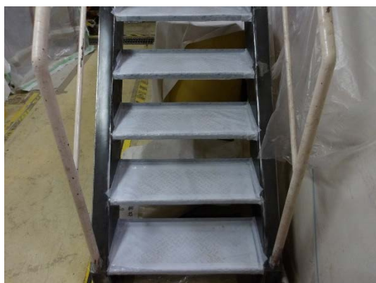
塗膜剥離後養生
