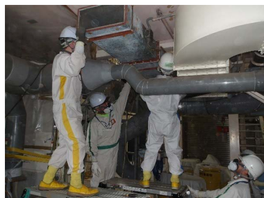
給気ダクト切断撤去 (2)
