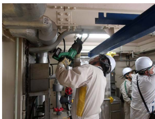
電線管の切断撤去作業
