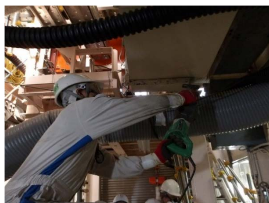
給気ダクト切断撤去 (1)
