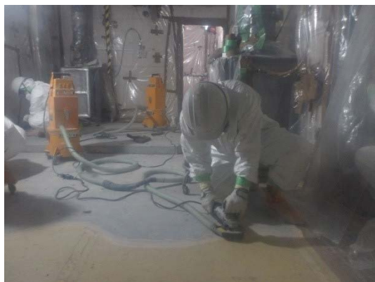
乾燥機室床面研削 (簡易ハウス内)
