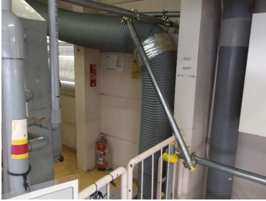
二次側（排気）ダクトの設置（2） （廃水処理室（部屋）→排気機械場）
