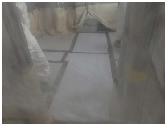
掘削箇所の養生後 (不燃シートによる養生 (2重目))
