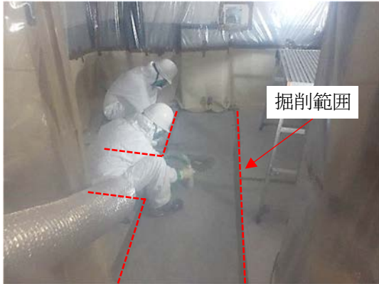
床面の掘削前汚染検査
