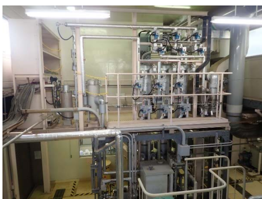
作業架台機器類撤去前
