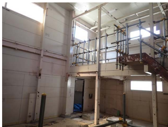
反応槽撤去後
