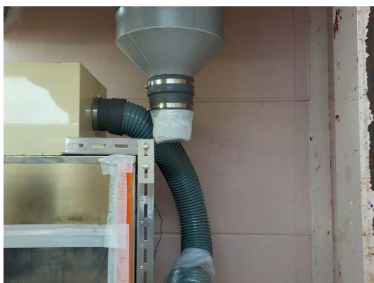
簡易フードと排気ダクトの切離し
