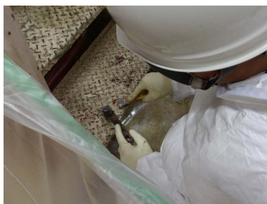
塗膜剥離作業（2） （スクレーパ）
