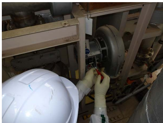
機器端子台からの離線作業
