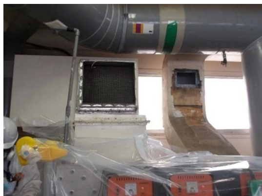
給気口接続ダクト切断撤去
