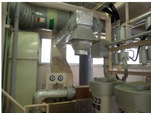
給気ダクト及び排気ダクト撤去前 (2階)
