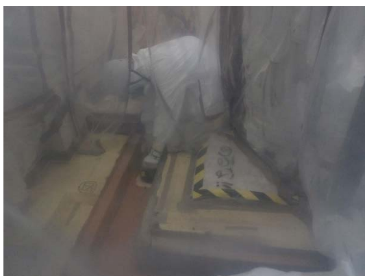
排水トレンチ防水塗膜撤去 (1) (簡易ハウス内)
