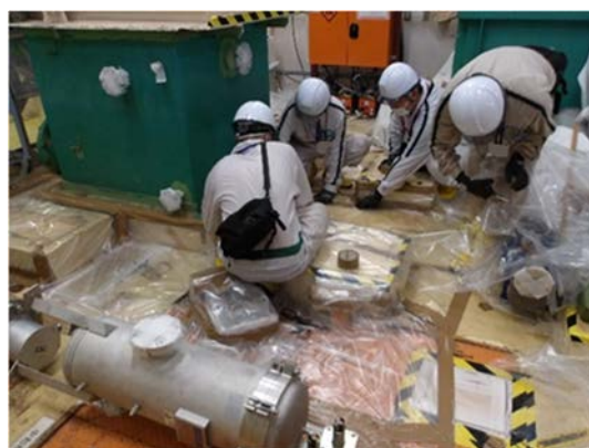
簡易ハウス床面養生
