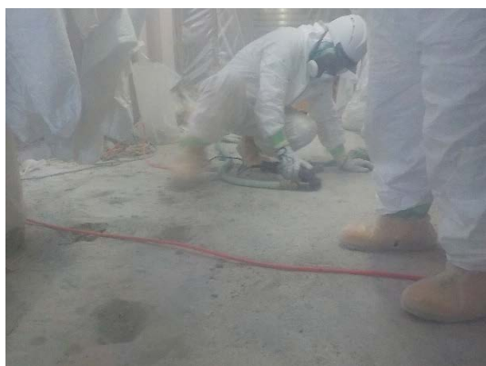
廃水処理室（部屋）床面研削 （簡易ハウス内）
