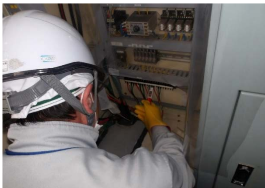
分電盤内の検電作業
