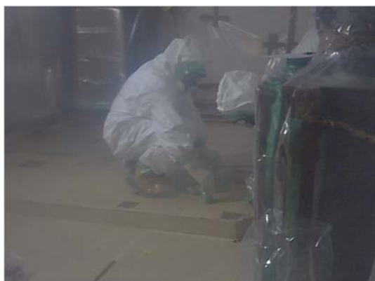
作業前汚染検査 (簡易ハウス内)
