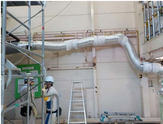
一次側 (吸入) ダクトの設置 (1) (廃水処理室 (部屋))
