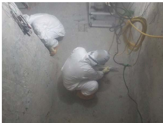
撤去後の汚染検査 (1) (地下ピット内)
