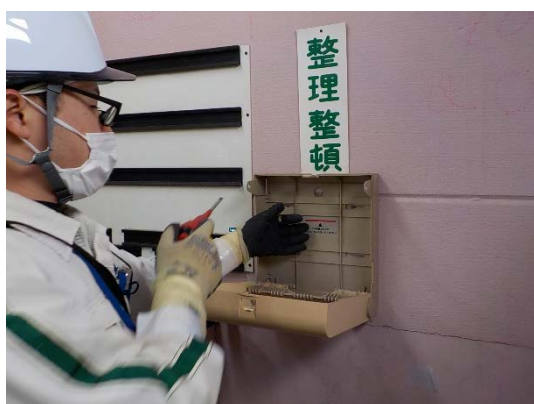
洗瓶ラック等の撤去
