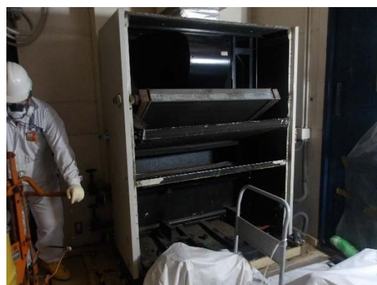
給気設備撤去作業
