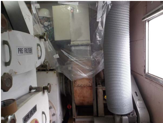
排気筒と既設排気設備の切離し作業 （排気機械場）
