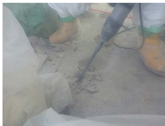
廃水処理室（部屋）アンカーボルト撤去 （簡易ハウス内）
