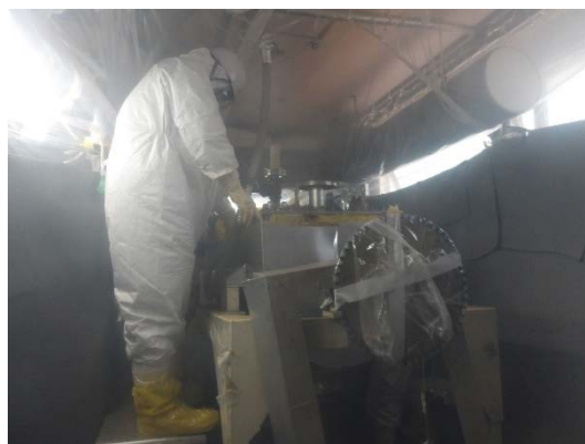
乾燥機本体の解体撤去 (1) (簡易ハウスⅡ作業エリア)
