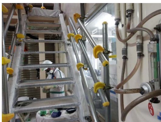
仮設手摺の設置
