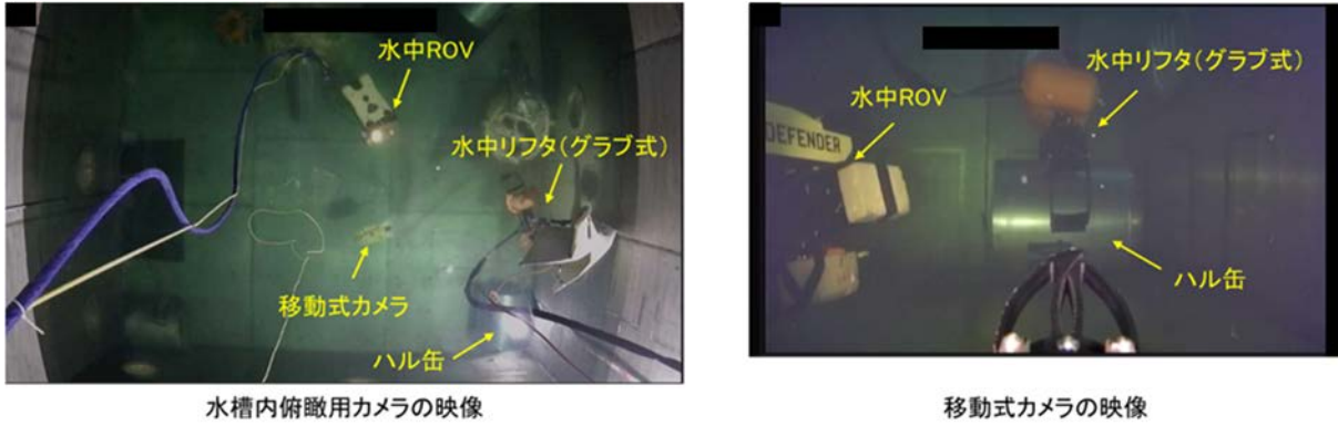
図 45 水中リフタ（Grab式）の取付け時の状況
