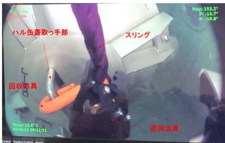
図 23 回収吊具の取付けの様子（水中 ROV のメインカメラの映像）
