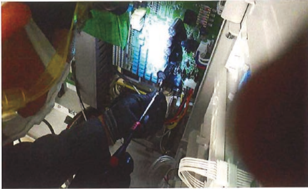
Photo 3.3.3 新規火災受信盤据付（ケーブル接続）
