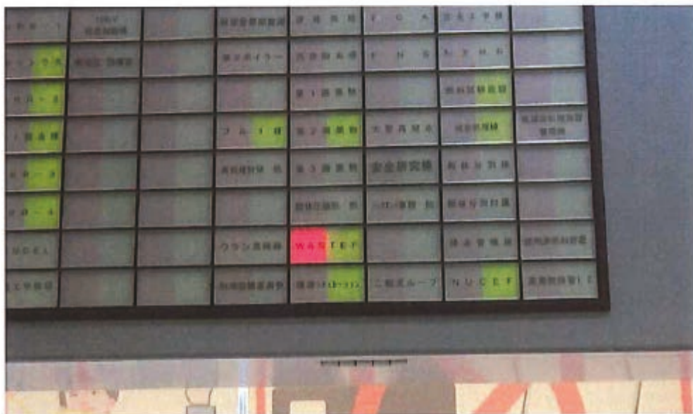
Photo 3.4.3 試験（移報試験）
