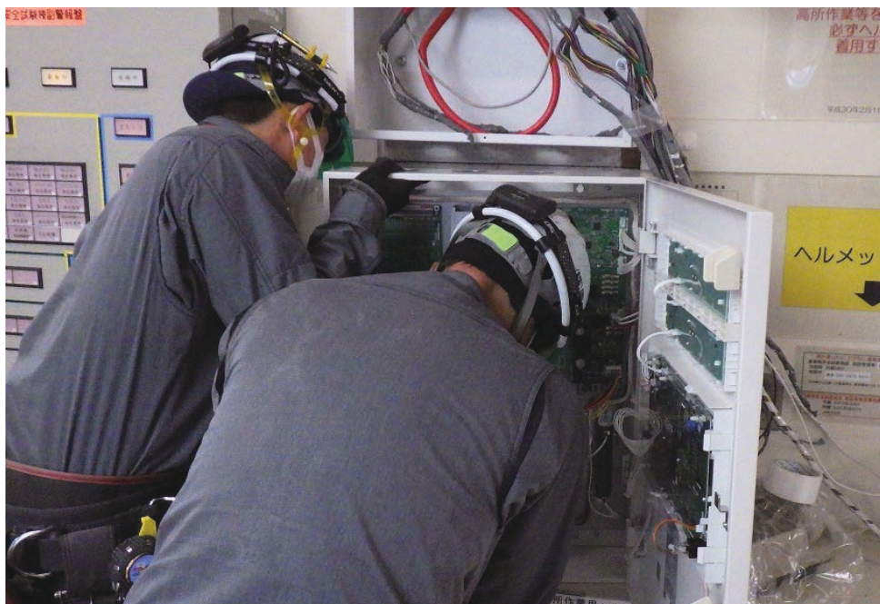
Photo 3.3.2 新規火災受信盤据付（火災受信盤取付け）
