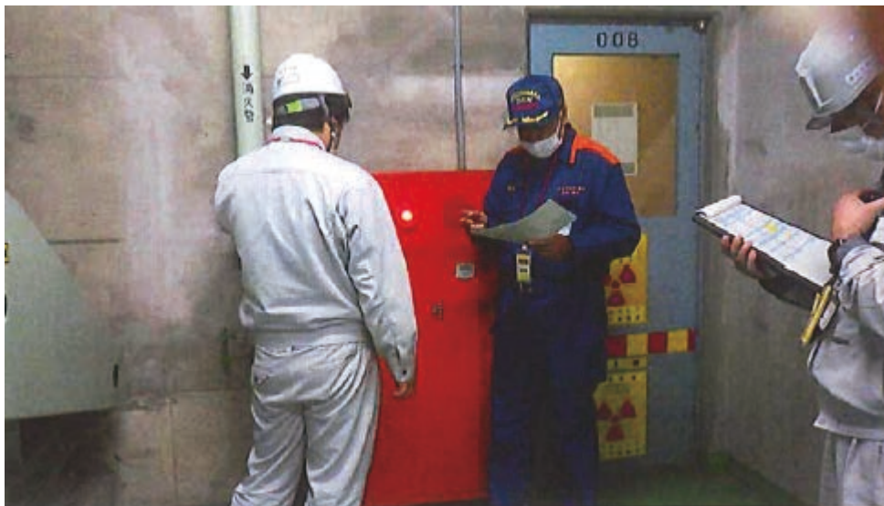
Photo 4.1.1 消防用設備の設置完了検査
