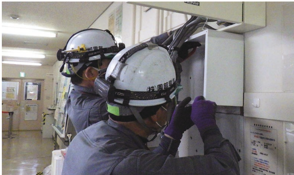
Photo 3.3.1 新規火災受信盤据付（プルボックス取付け）
