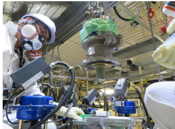
Photo 4.9 水素循環ポンプの取外し
