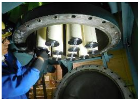
Photo 4.2 油分離器のエレメント交換と油吸着器の活性炭交換
