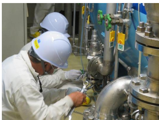
Photo 4.7 安全弁検査のための取外し
