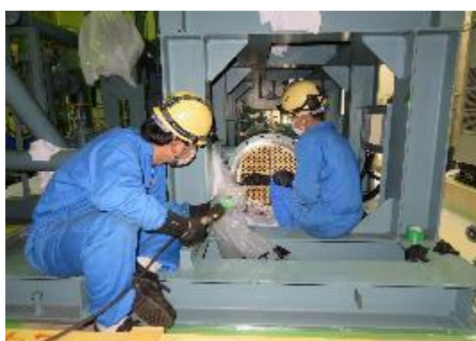
Photo 4.3 ガス冷却器の開放点検
