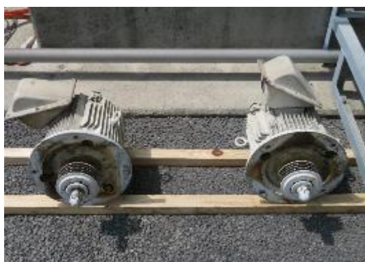
Photo 4.5 散水ポンプの開放点検
