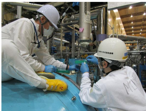
Photo 7.2 タービンの交換作業
