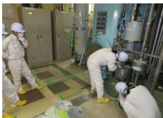
Photo 4.10 油回転ポンプの更新
