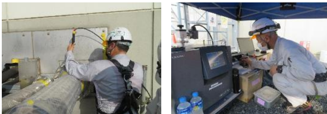
Photo 4.12 屋外高所配管保守点検作業の様子
