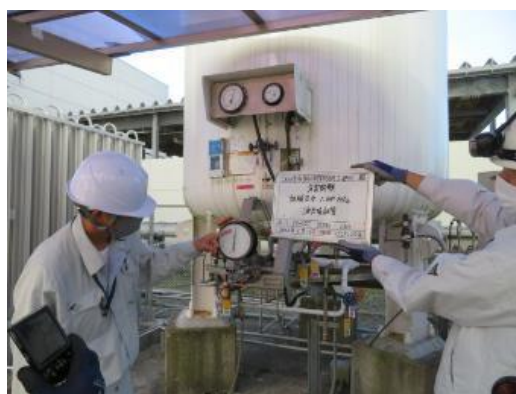
Photo 4.8 気密検査 (液体窒素貯槽)
