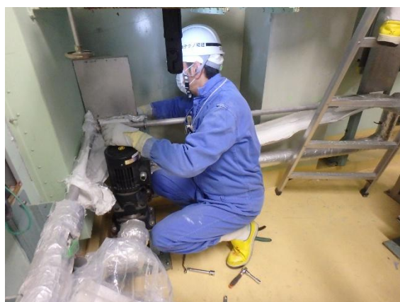
保温材類の撤去状況
