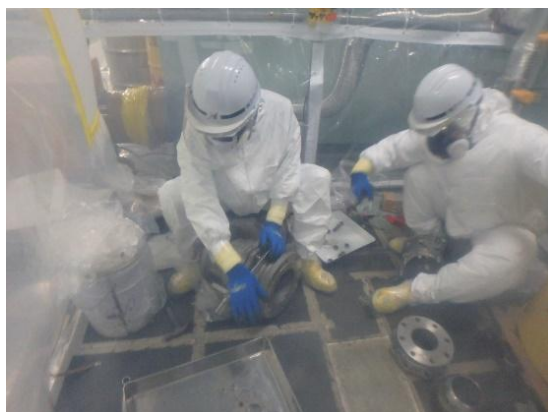
フランジ分解作業状況
