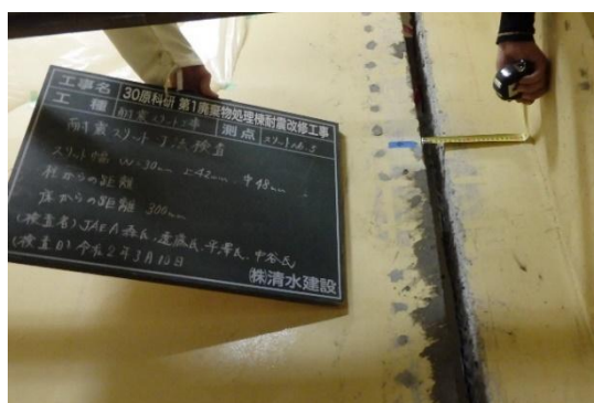
耐震スリットの寸法検査
