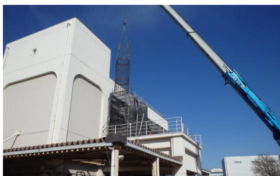
鉄筋建て込み（南側杭）
