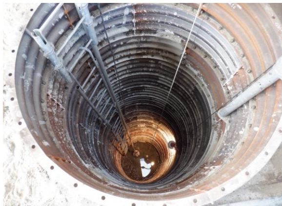
ライナープレート設置（南側杭）
