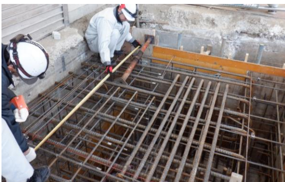
配筋（南側基礎）
