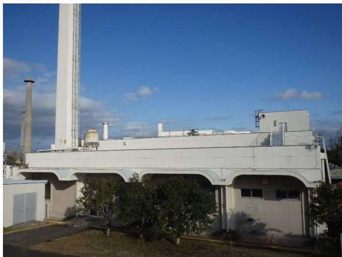
第 1 廃棄物処理棟
