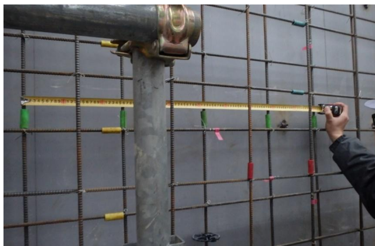
配筋、構造検査
