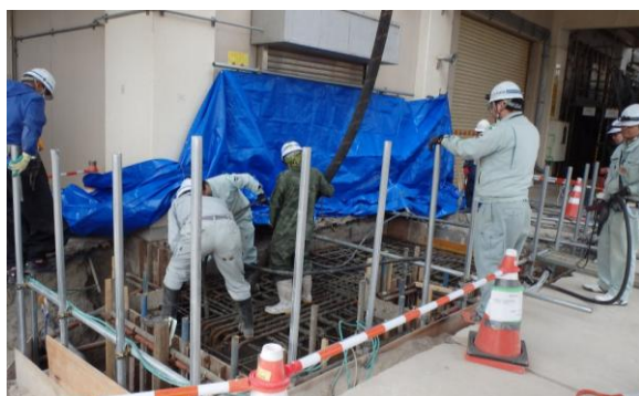
コンクリート打設（南側基礎）
