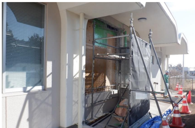
既設窓の撤去
