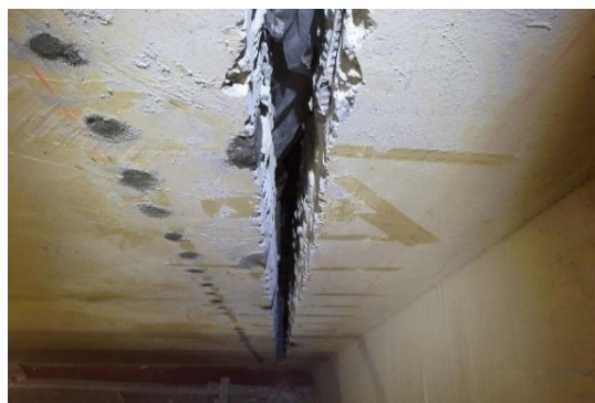
耐震スリットの穿孔
