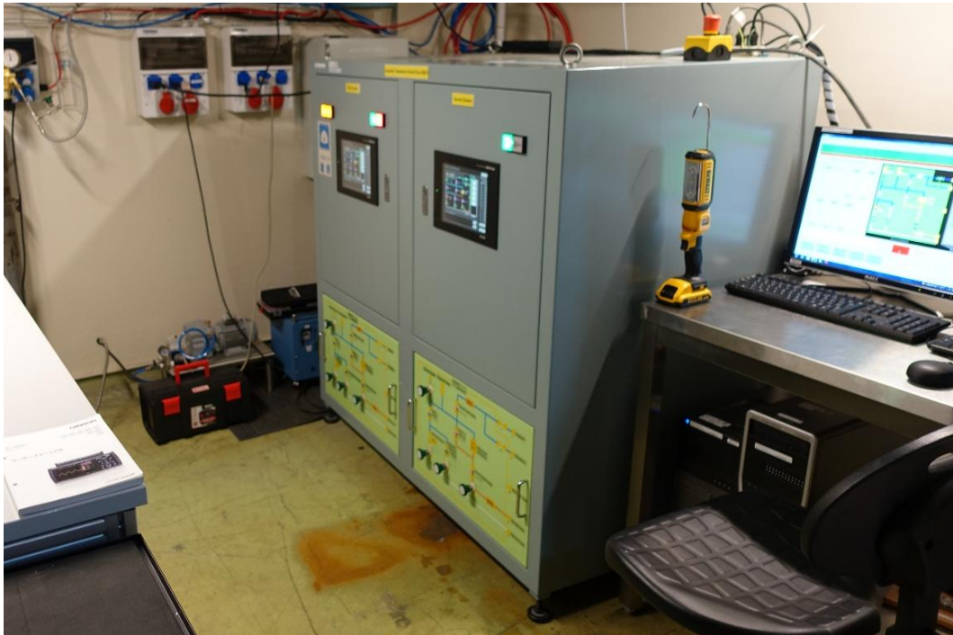
Fig. 4.1 MARIA 炉に設置したキャプセル温度制御装置（現地の設置状況）
