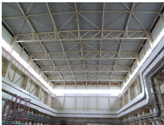
空調ダクト補修後（2012年2月）
