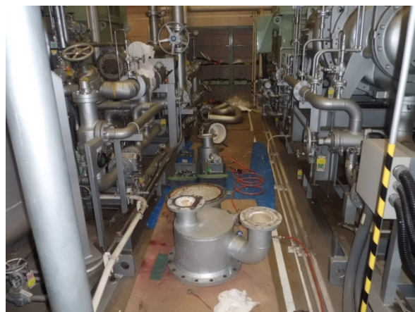
熱交換器分解点検
