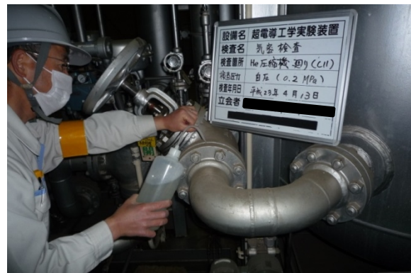
気密試験 主ヘリウム圧縮機(C11)廻り配管
