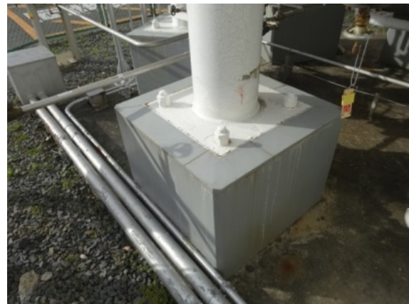
液体窒素貯槽(R60)補修後
