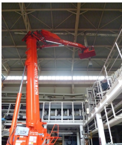
空調ダクト損傷箇所の補修
