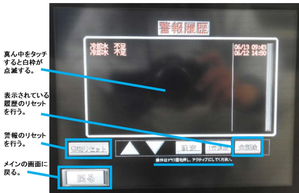
図 4.5 電気炉の制御用タッチパネル (2)
