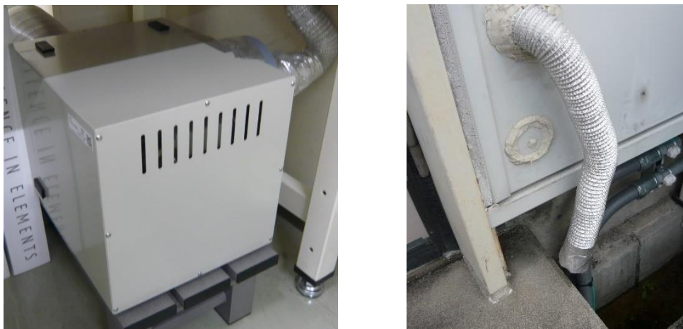
図 2.6.2 強制排気装置 (左 本体 : 右 排気口)
