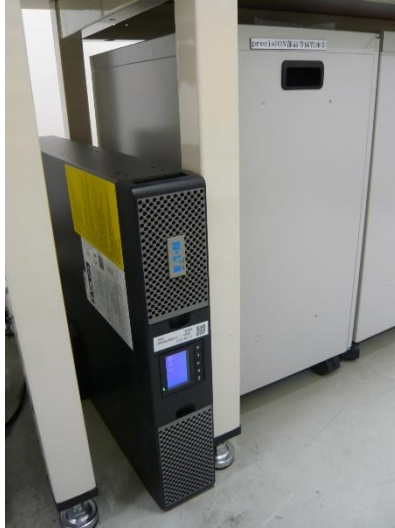
図 2.6.1 TC-EA 冷却ファン用の無停電電源装置
