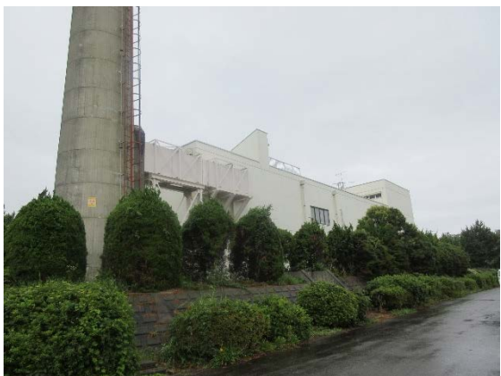
(e) \alpha 固体処理棟 (外観)
