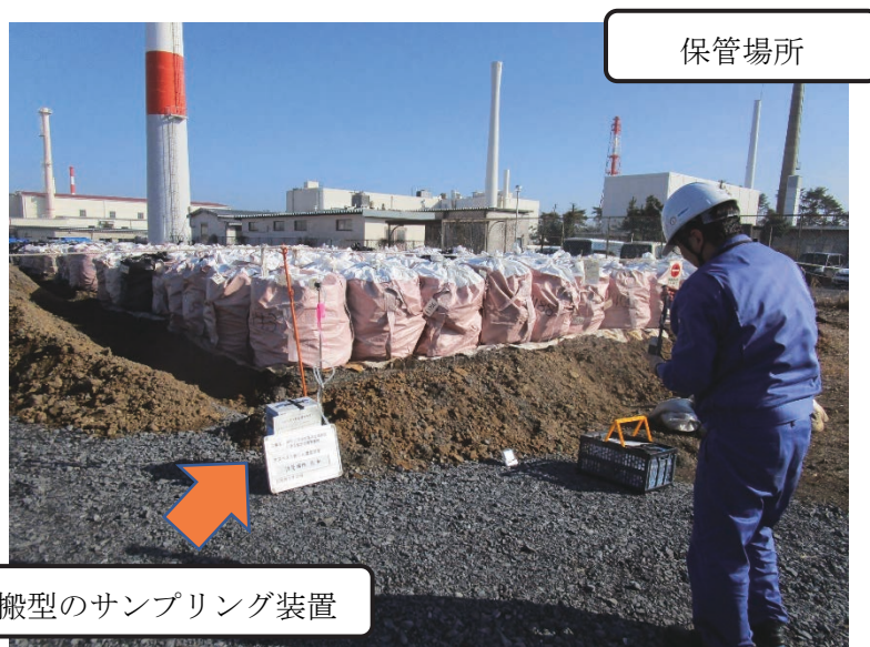
Fig. 13 保管管理時のアスベスト粉じん濃度測定
