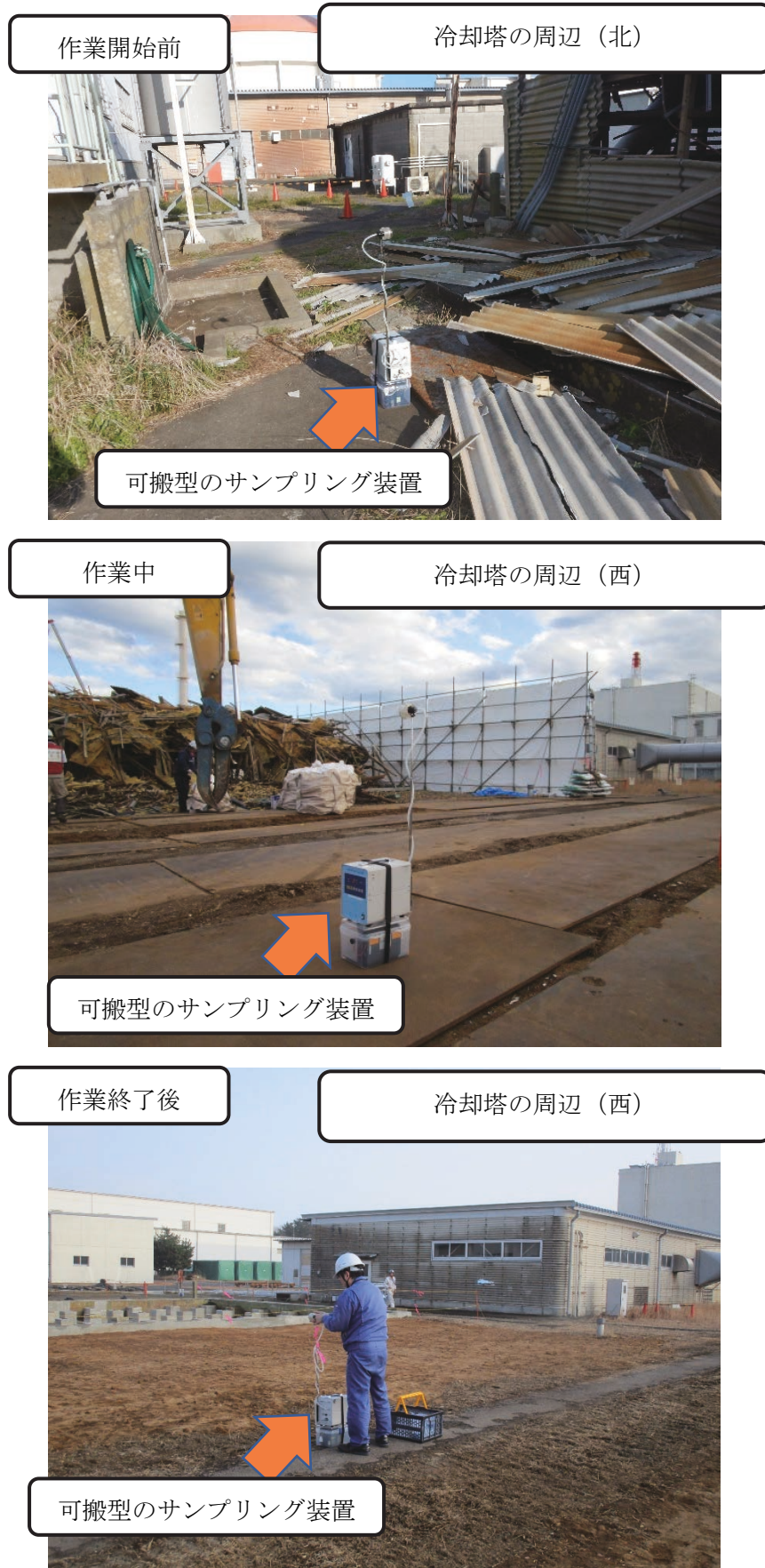
Fig. 11 撤去時のアスベスト粉じん濃度測定
