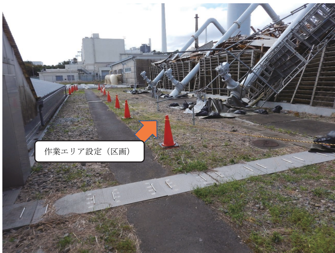
Fig. 5 作業エリアの設定 (現場の区画・表示)
