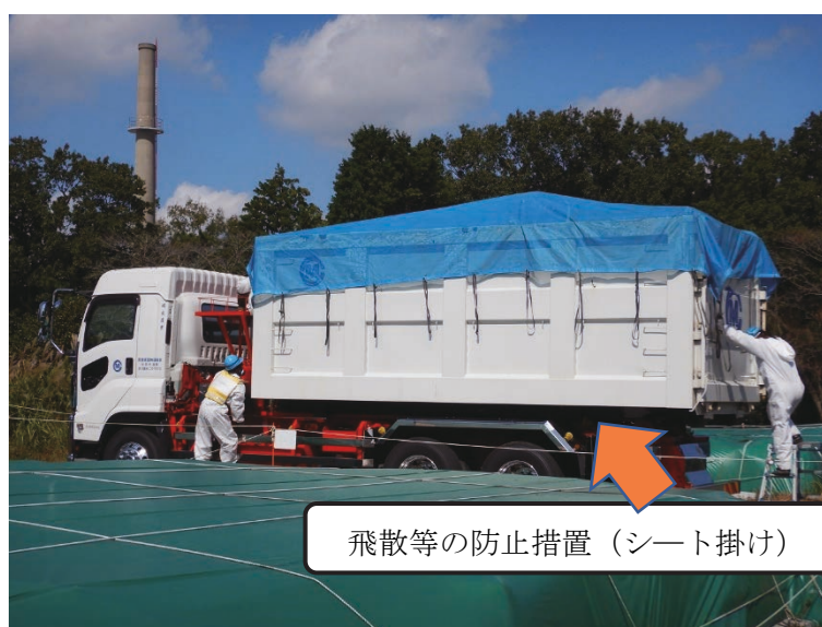
Fig. 14 石綿スレート材の搬出の管理
