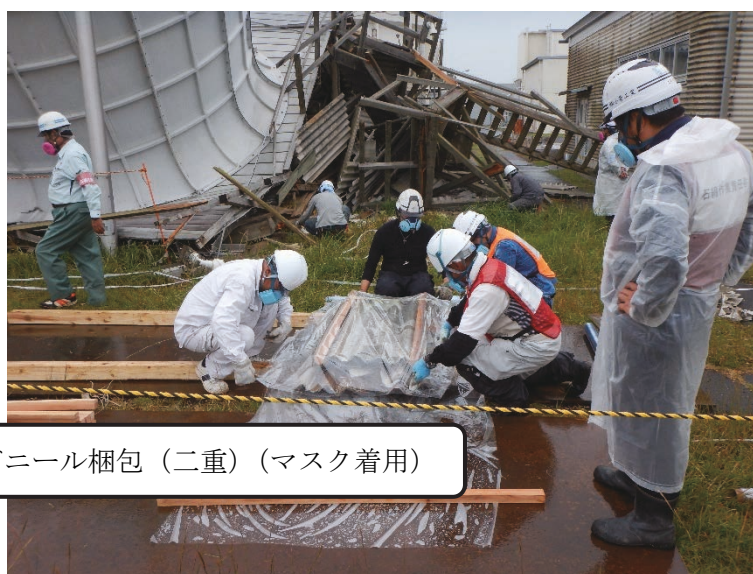
Fig.8 撤去（解体現場での収集・梱包）
