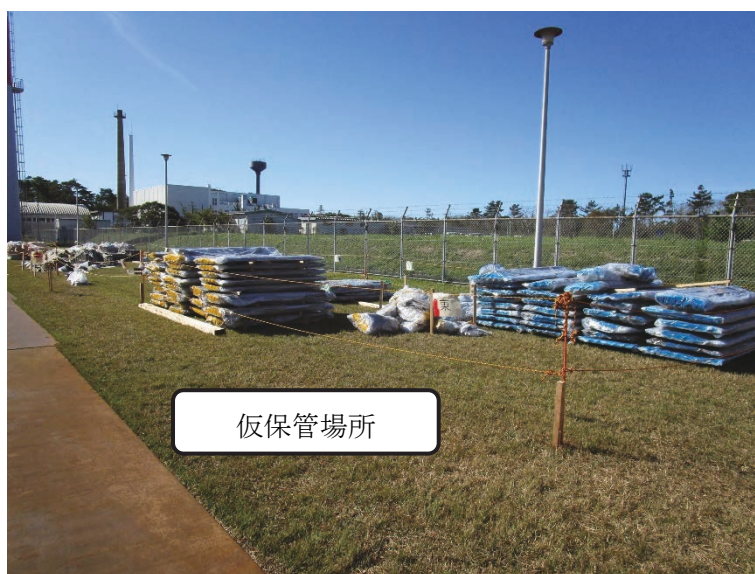
Fig. 9 撤去（仮保管場所までの収集・運搬）
