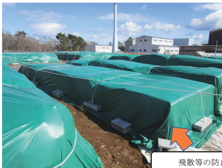
Fig. 12 石綿スレート材の保管管理
