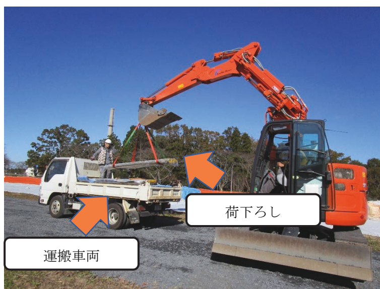
Fig. 10 撤去（運搬車両）
