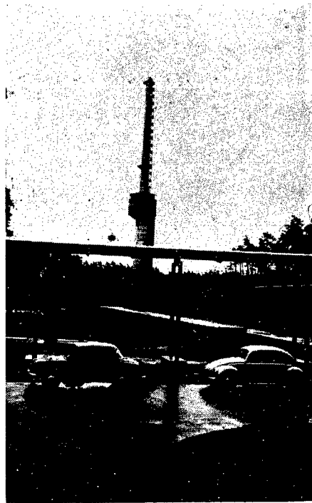
第66図 FR-2 の煙突と 炉建家よりの廃液輸送用架空ダクト
