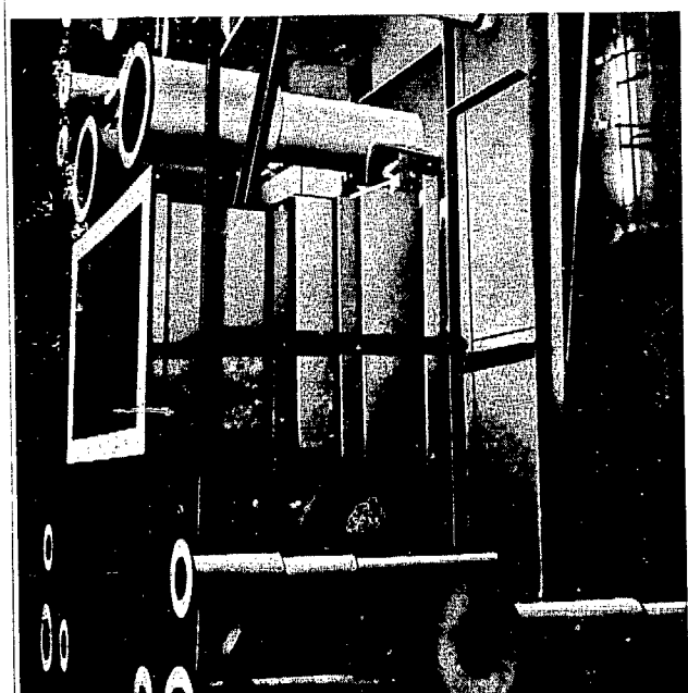
Photo. 8 シャヘイ窓付近の細部 (重量コンクリート打設前). 矢印はシャヘイを完全にするため補強溶接した鉄ブロック.
